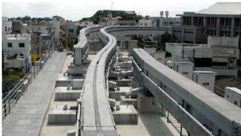
Figura 2 – Vista do aparelho de mudança de via de um sistema monotrilho (fls. 169 do P.A.)
