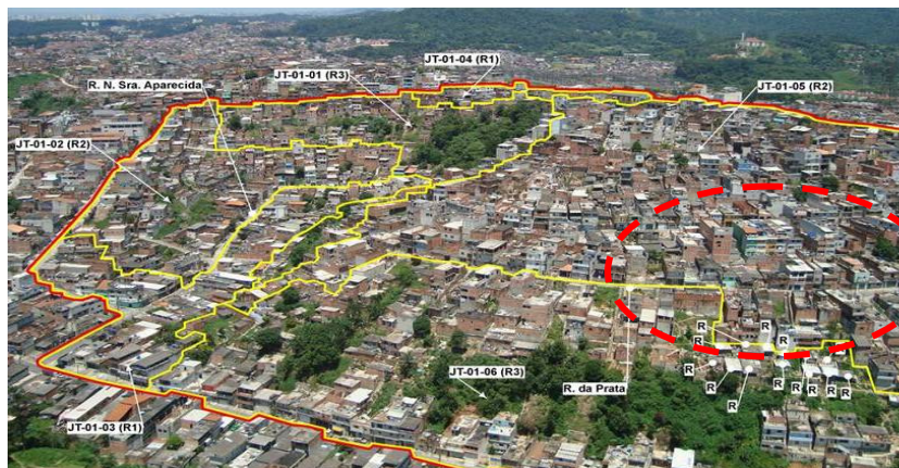
Sinalização de moradias indicadas para reassentamento (R)
