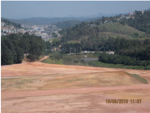
Foto nº 09: Vista geral dos 3 patamares do ARCC, vistoria realizada em 10/09/10.
