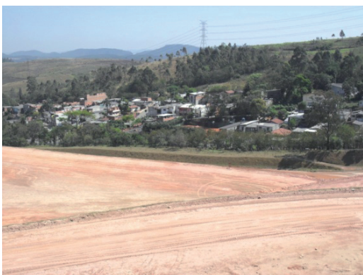
Foto nº 11: Vista da cerca viva entre a área de operação do ARCC e a Avenida Raimundo Pereira Magalhães, vistoria realizada em 10/09/10.
