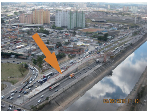
Foto nº 03: No detalhe, construção da Obra de Arte Especial OAE 303-2, nas proximidades da Ponte do Tatuapé, vistoria realizada em 09/09/10.
