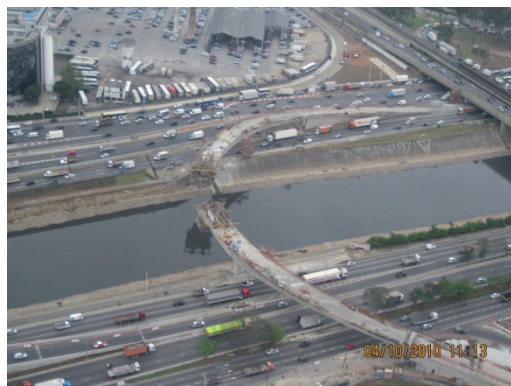
Foto nº 04: Construção da Obra de Arte Especial OAE-301 nas proximidades da Avenida Cruzeiro do Sul, vistoria realizada em 04/10/10.
