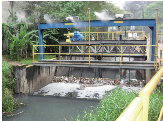
Foto nº 04: Sistema de gradeamento para contenção de resíduos sólidos maiores, vistoria realizada em 24/09/10.
