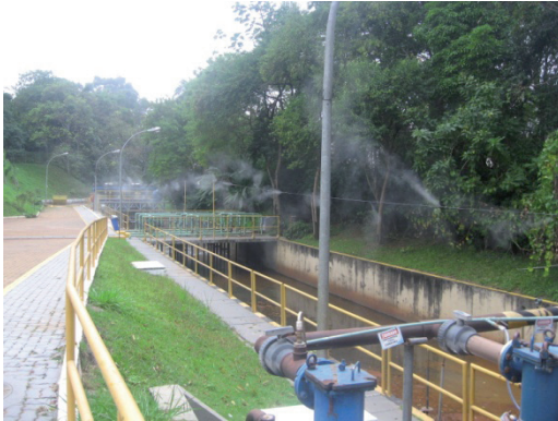
Foto nº 01: Sistema de redução de odores através de lançamentos de desodorizadores à base de água no ambiente, vistoria realizada em 23/04/10.
