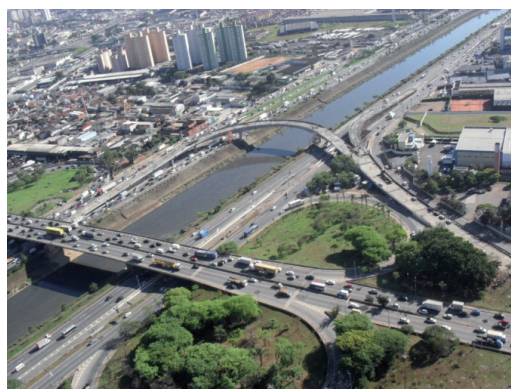
Foto nº 06: Obras da OAE 303-2 nas proximidades da Ponte do Tatuapé, vistoria realizada em 18/11/2010.
