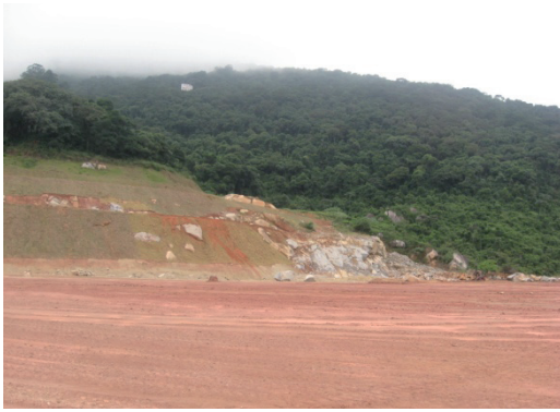
Foto nº 07: Vista geral do ARCC, vistoria realizada em 21/05/10.
