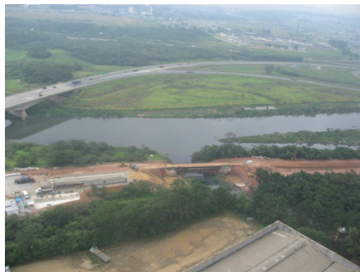
Foto nº 01: Plantio de mudas na Rua Antonio Moreira, entre a Ponte Vila Guilherme e Ponte Jânio Quadros, vistoria realizada em 16/04/10.
