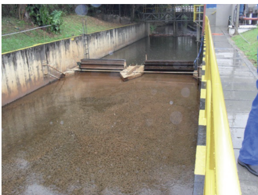
Foto nº 05: Material flotado na superfície indo em direção ao sistema rotativo de remoção, vistoria realizada em 24/09/10.
