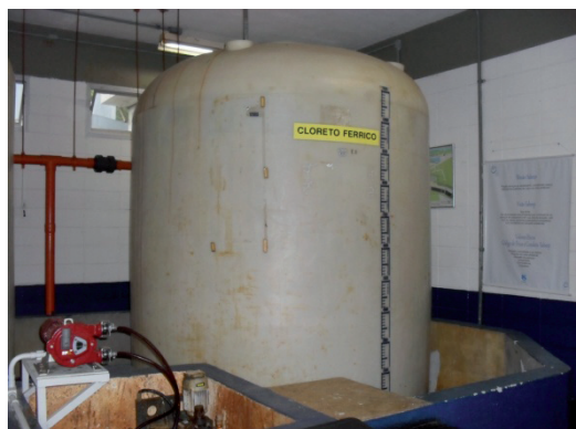
Foto nº 06: Armazenamento do agente químico coagulante, Cloreto Férrico. vistoria realizada em 24/09/10.
