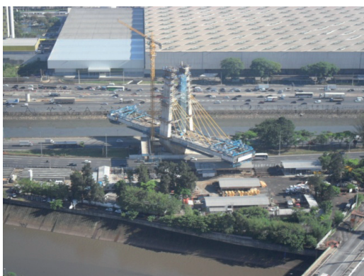
Foto nº 05: Construção da Obra de Arte Especial OAE 202, que ligará a Avenida do Estado em sentido pista norte da Marginal Tietê, vistoria realizada em 18/11/10.
