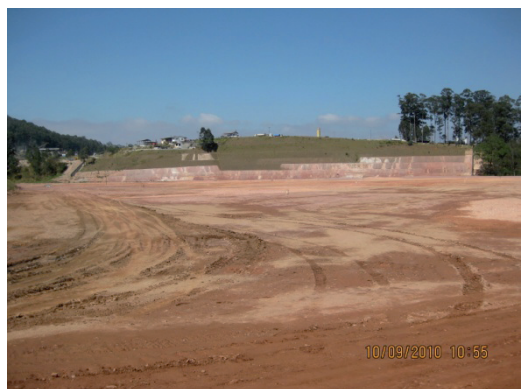
Foto nº 12: Vista geral do ARCC, vistoria realizada em 10/09/10.
