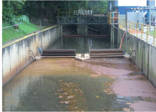
Foto nº 02: Flocos de poluentes após a aplicação dos reagentes químicos, vistoria realizada em 23/04/2010.
