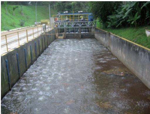
Foto nº 03: Sistema de Aeração para submersão dos flocos de poluentes aglutinados com o Cloreto Férrico, vistoria realizada em 23/04/10.
