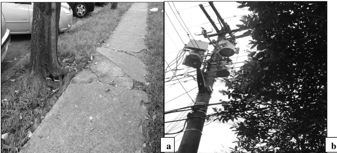
Fotografia 2 – Diagnóstico de arborização: a) Passeio destruído por raízes de *Ligustrum lucidum* W.T. Aiton.; b) Copa de *Tibouchina granulosa* entre as fiações aéreas.
