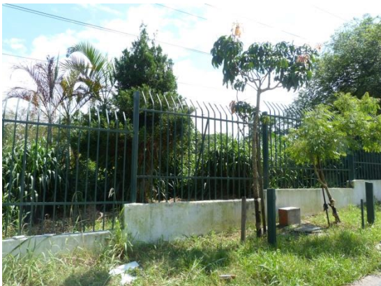
Foto 5. Exemplo de trecho de calçada em mau estado de conservação
