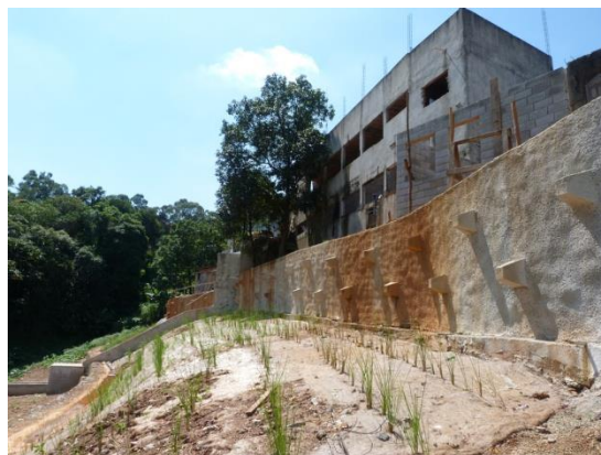
Foto 8. Obra de contenção concluída
