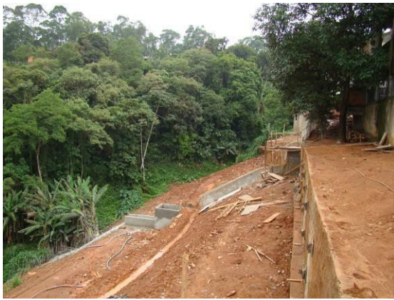
Figura 53. Obra de engenharia para prevenção de processos de escorregamento. Ponto 26.
