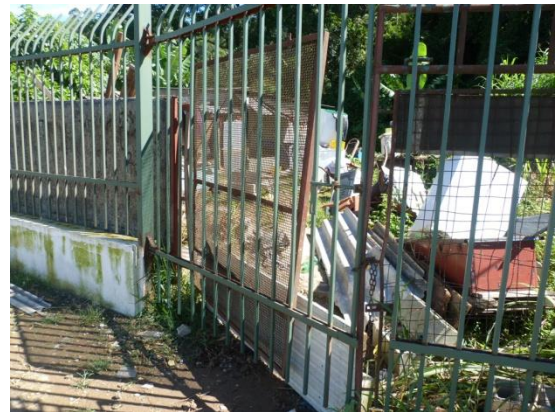
Foto 42. Ocupação irregular para habitação na área do parque
