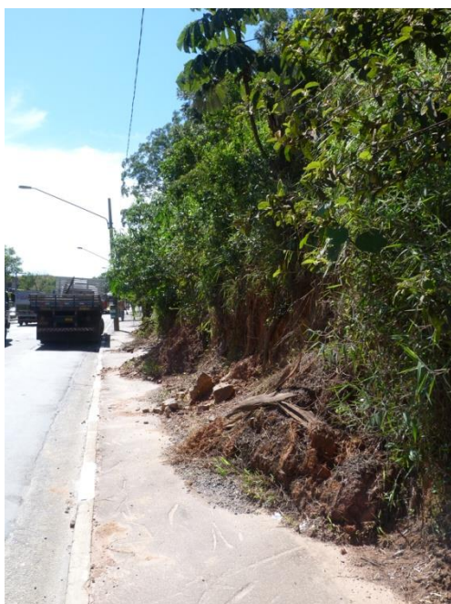
Foto 47. Trecho com deslizamento de terra da área lindeira ao parque para a calçada
