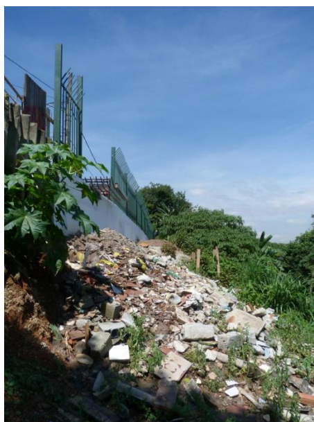
Foto 10. Resíduos depositados no interior do parque, junto à obra de contenção
