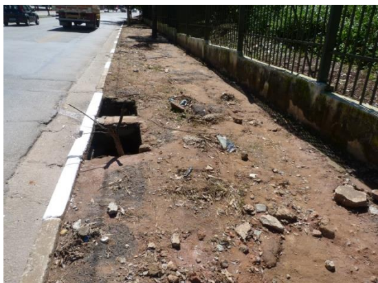
Foto 45. Na Av. Afonso de Sampaio e Sousa, calçadas para pedestres em péssimo estado de manutenção
