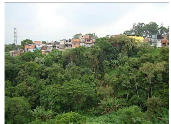
Figura 52. Casas construídas próximo à área de risco geológico. Ponto 26.
