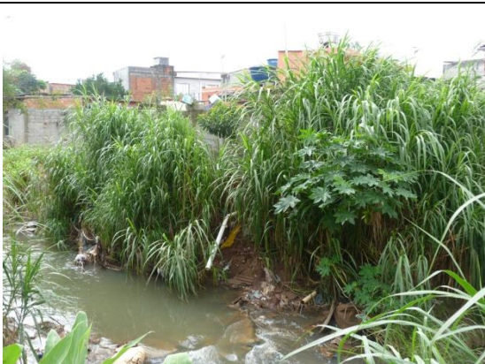
Foto 31. Tubulação de esgoto direcionada para o rio
