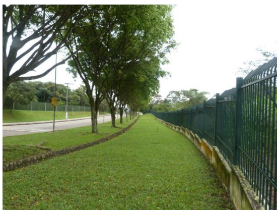
Foto 51. Vias de acesso da entrada superior do SESC em ótimo estado de manutenção
