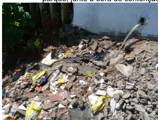
Foto 12. Despejo de águas residuais in natura no interior do parque
