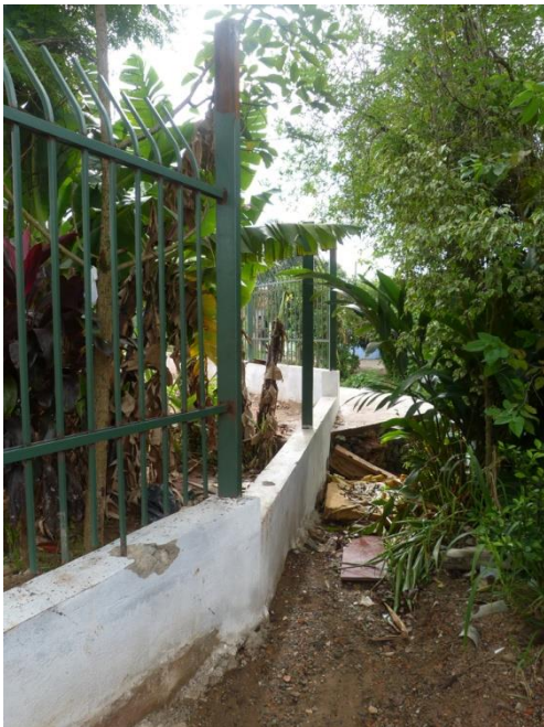
Foto 27. Gradil danificado no Tabor
