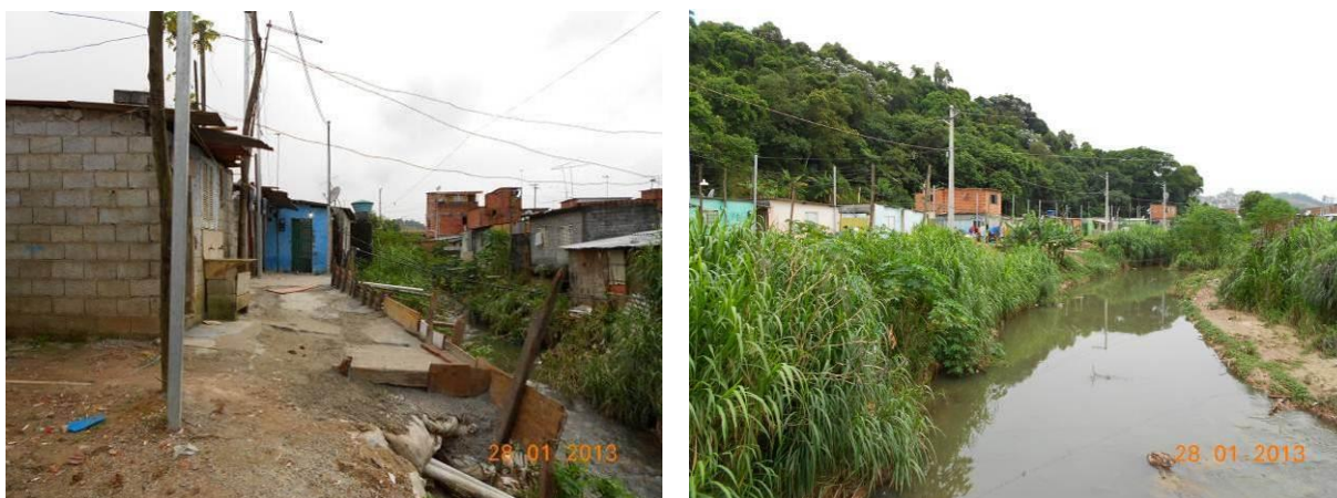
Figura 132. Lançamento de esgoto no Córrego Aricanduva (SP).
