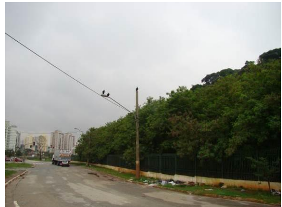
Figura 54. Acúmulo de lixo nas proximidades do PNMFC. Ponto 15.
