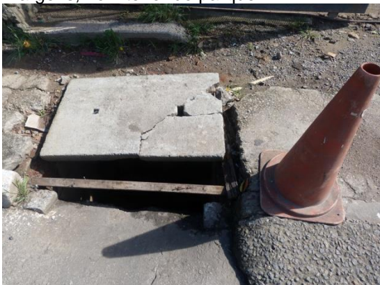
Foto 43. Bueiro sem manutenção, risco de
