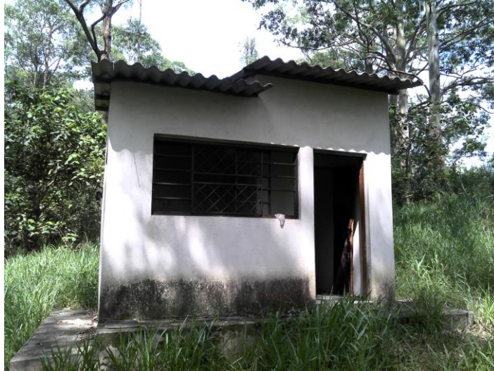
Figura 199. Base da EcoUrbis que está abandonada. Fotografia: Angela Pellin.
