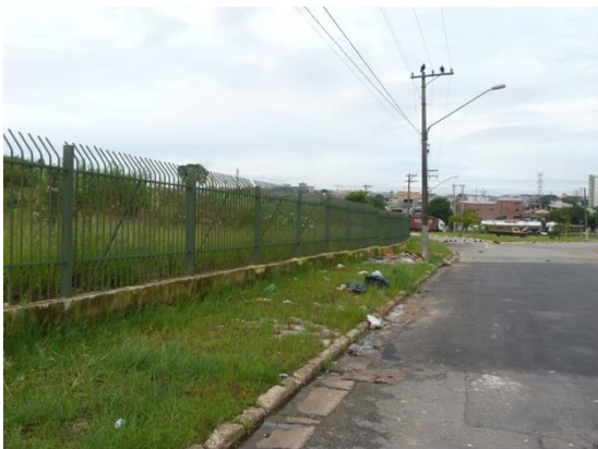
Foto 55. Calçadas da R. Jacu Pêssego sem manutenção, dominada por gramíneas e resíduos despejados no local indevidamente
