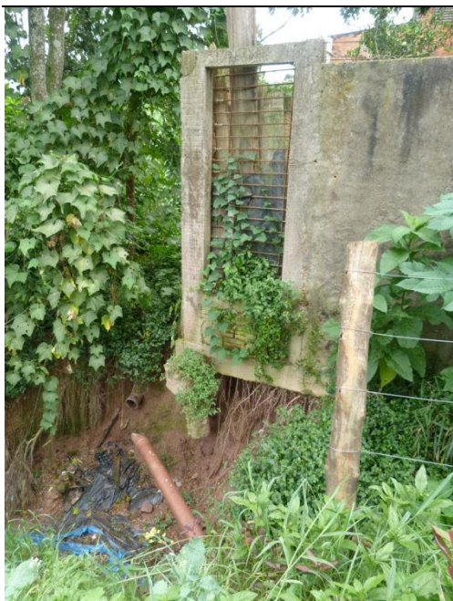
Foto 13. Erosão no interior do parque, com ponto de despejo de águas residuais
