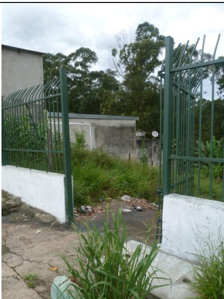
Foto 7. Ponto de acesso de emergência ao parque, destrancado
