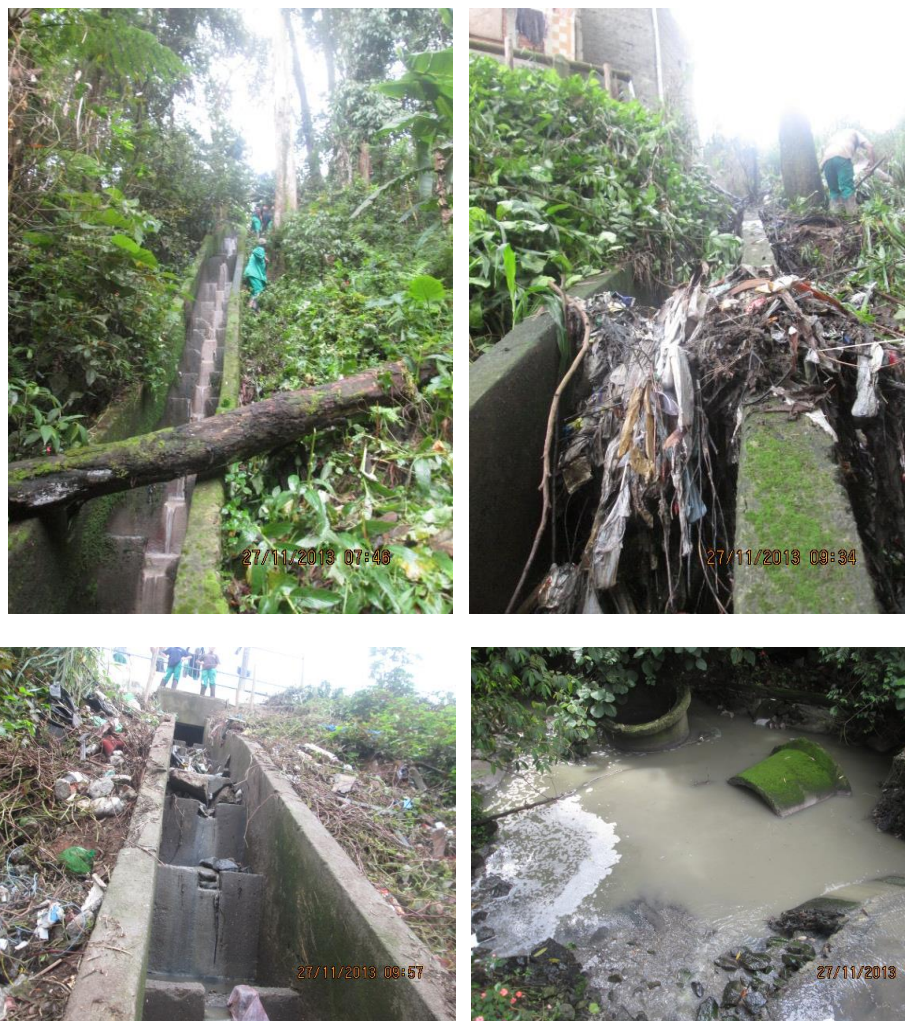
Figura 200. Escadas hidráulicas presentes no interior do PNMFC. Fotografias: acervo fotográfico do PNMFC
