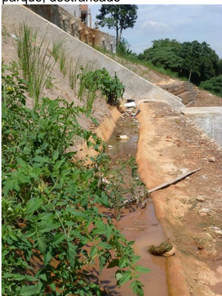
Foto 9. Água acumulada em obra de contenção
