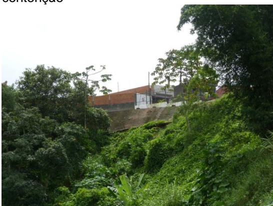
Foto 11. Outra obra de contenção realizada
