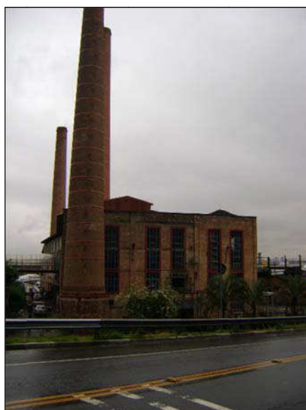
Figura 9.2.5-10: Casa das Caldeiras
