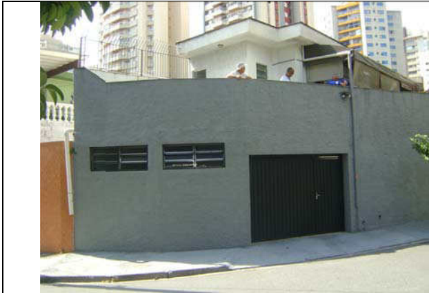
Imóvel residencial localizado na rua Miranda de Azevedo – área desapropriação.
