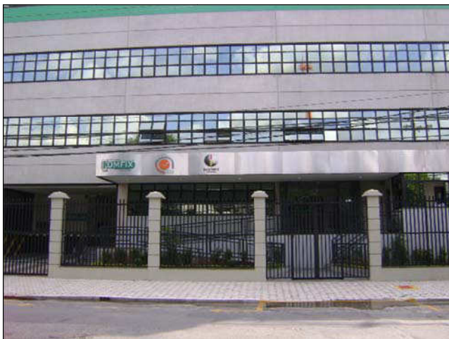
Foto 9.2.6-7: Edifício empresarial – empresas Confix e Doublé Fastener, localizada na rua Santa Marina.
