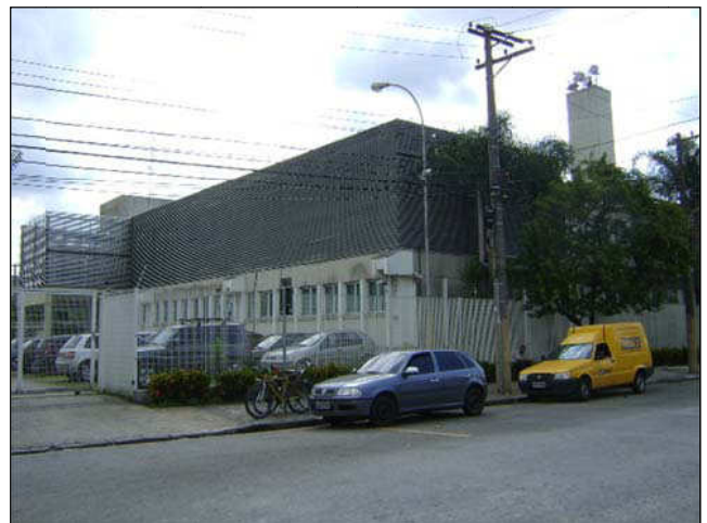
Foto 9.2.6-8: Edifício empresarial – localizada na rua Adriano Marchini.
