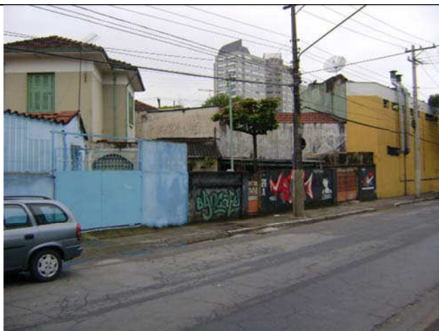
Área de uso residencial horizontal – localizado na Rua Bento Teobaldo Ferraz.
