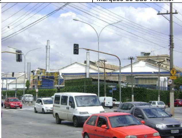
Áreas da Indústria Duratex-Deca – localizada na avenida Marquês de São Vicente.
