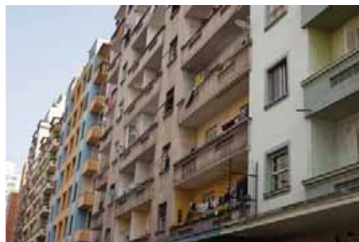
Edifícios residenciais na Rua dos Guaianazes
