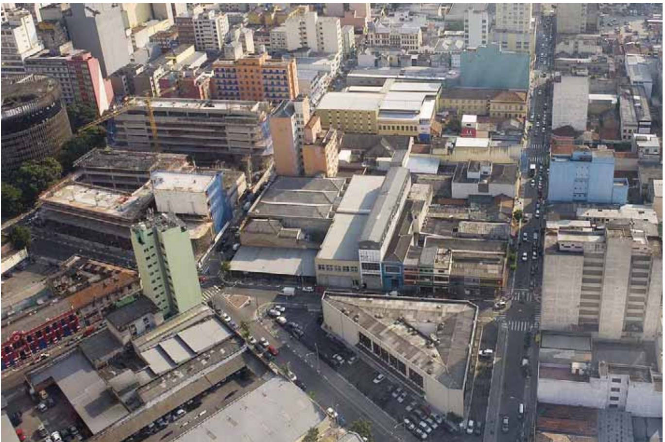
Vista aérea da porção nordeste da área de intervenção, junto à ZEIS: à direita, eixo da Rua Vitória; à esquerda, obras da ETEC
