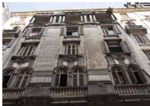
Edifício localizado entre as Ruas General Osório X São João e Barão de Campinas
