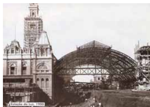
Estação da Luz em construção, 1900
