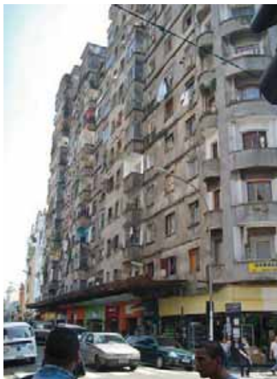
Edifício localizado entre as Ruas Santa Ifigênia X General Osório
