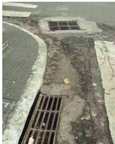
Boca de leão e grelha de captação na esquina das Ruas Gen. Osório x Sta. Ifigênia
