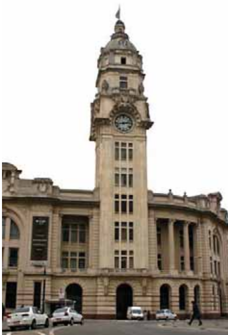
Estação Júlio Prestes - Sala São Paulo
