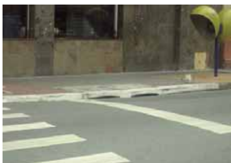
Boca de lobo dupla - Rua Aurora, sentido Rua dos Andradas
