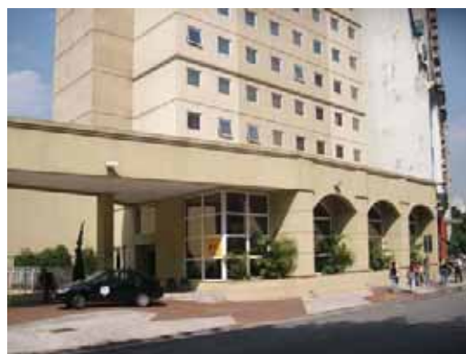
Hotel F1, à Rua Barão de Campinas
