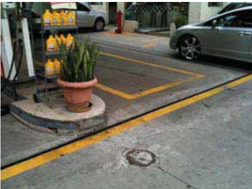
Um dos poços de monitoramento em um posto de combustíveis da região
