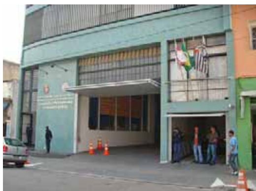
Comando Geral da Guarda Civil Metropolitana, na Rua General Couto de Magalhães, 444, na ADA
