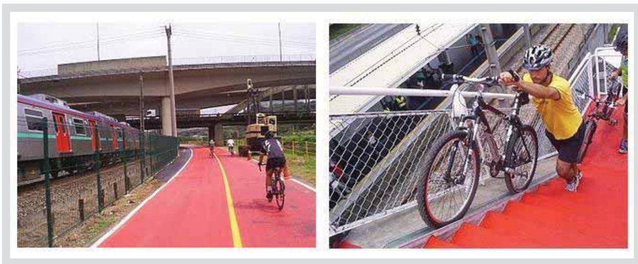
FOTO 10.4.8-4 – CICLOVIA DA MARGINAL DO RIO PINHEIROS
