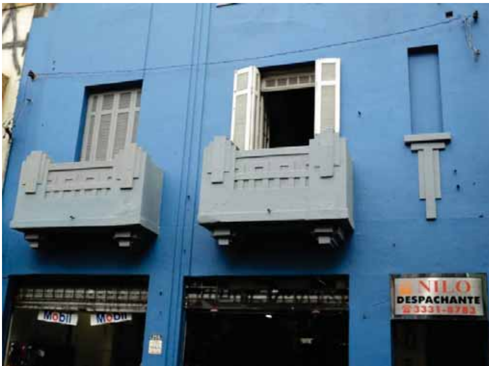
FOTO 10.4.7-1 – EDIFICAÇÃO COM USO MISTO NA RUA GUAIANAZES
