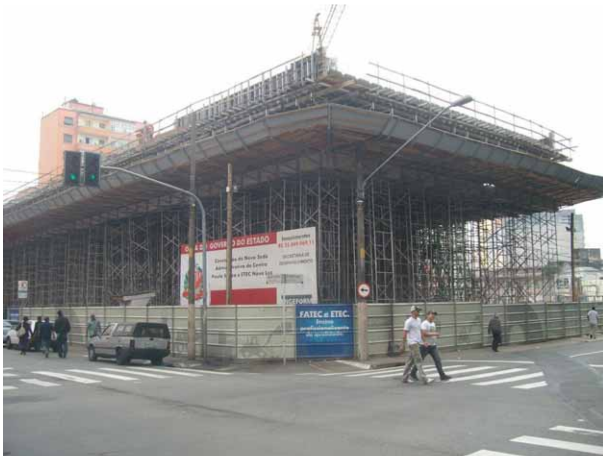
FOTO 10.4.9-1 – OBRAS DA ETEC
