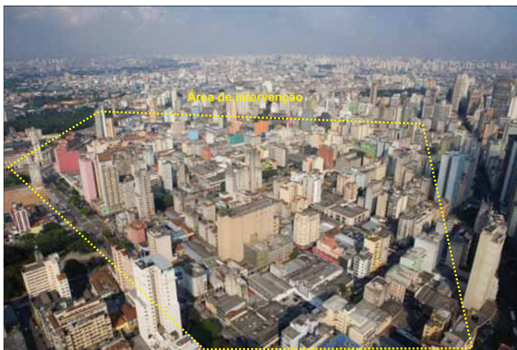
FOTO 5.1-1 – VISTA AÉREA DA ÁREA DE INTERVENÇÃO A PARTIR DA PORÇÃO OESTE
