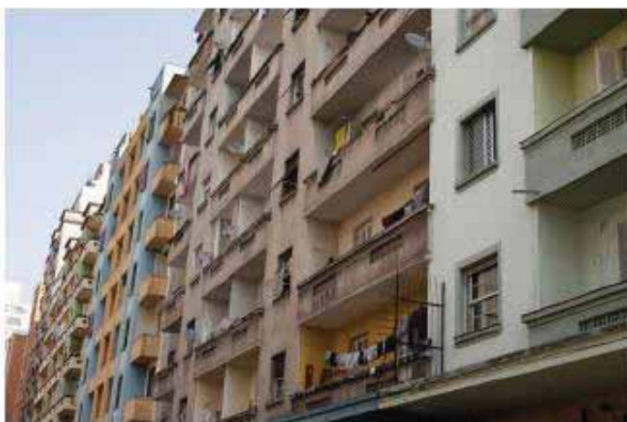
FIGURA 5.4-3 – EDIFÍCIOS RESIDENCIAIS NA RUA DOS GUAIANAZES
