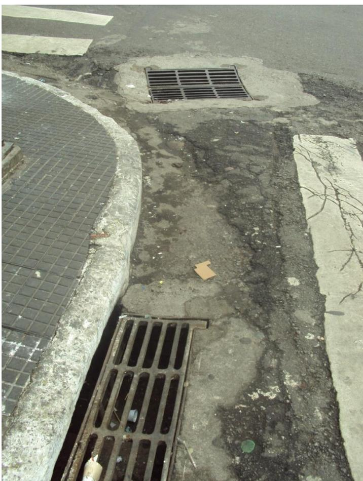
FOTO 10.2.4-3 – BOCA DE LEÃO E GRELHA DE CAPTAÇÃO NA ESQUINA R. GEN. OSÓRIO X R. STA. IFIGENIA
