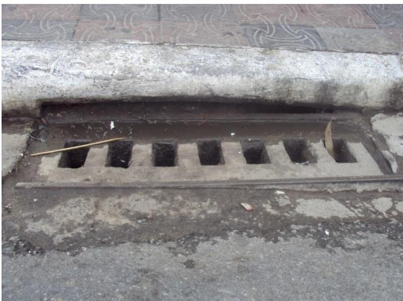
**FOTO 10.2.4-1 – BOCA LOBO COMBINADA COM GRELHA DE CONCRETO R. DOS ANDRADAS X R. DOS TIMBIRAS**
