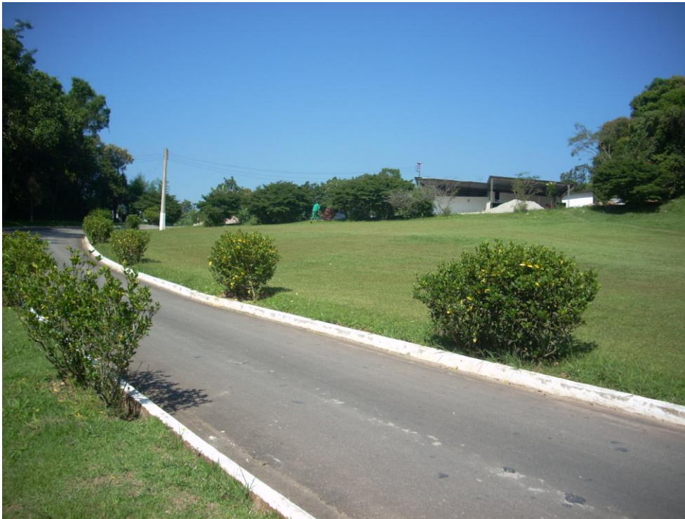
Foto 2.1.1-2 – Alameda de acesso ao Bloco de Serviços, situado ao fundo, à direita.
