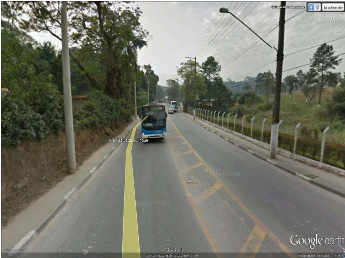
Foto 3.3.2.3-1: Detalhe das condições do eixo viário principal Avenida Sadamu Inoue, próximo ao CEMITÉRIO. A via apresenta boas condições de pavimentação, em pista simples.
