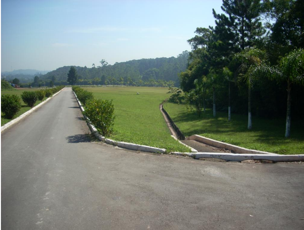
Foto 2.2.2-1: Aspecto da drenagem pluvial, constando de canaletas de concreto, com estruturas de dissipação, sempre desobstruídas.
