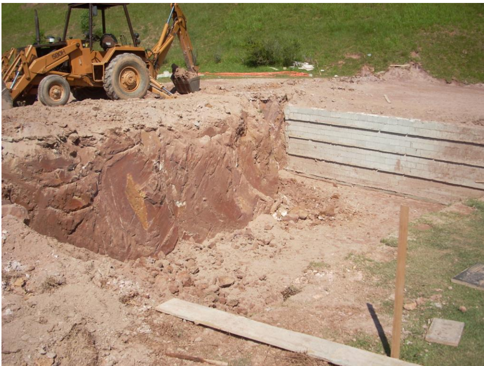
Foto 2.1.1-3: Escavações mecanizadas, para a construção de jazigos, referida na foto 2.1.1 -1
