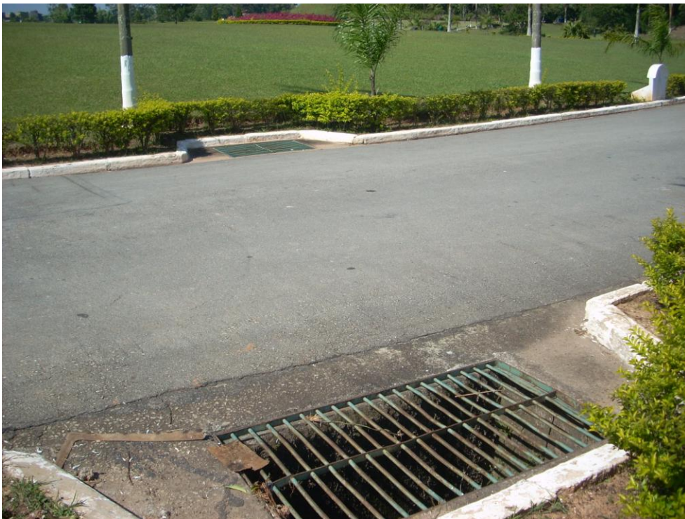
Foto 2.2.2-2: Bocas-de-lobo estão adequadamente distribuídas, em ambos os lados da de todas as alamedas e acessos secundários.
