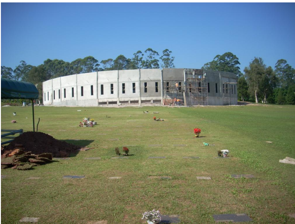
Foto 2.1.1-9: Ampliação do Bloco Principal em 518,92 m 2 , constando de 7 velórios, 1 sala de descanso, 1 sala de estar e depósitos.
