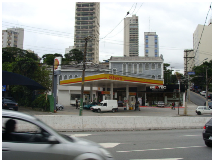
Posto Shell, rua Heitor Penteado, que consta do Cadastro da CESTESB.
