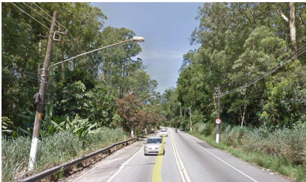
Foto 3.1 – Presença de circuitos primários em ambos os lados da Estrada de Perus
