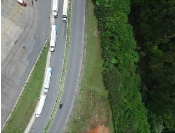
Foto 7.17 – Vista aérea em detalhe do local onde se pretende instalar a subestação. Sobrevoo VANT (out/18)
