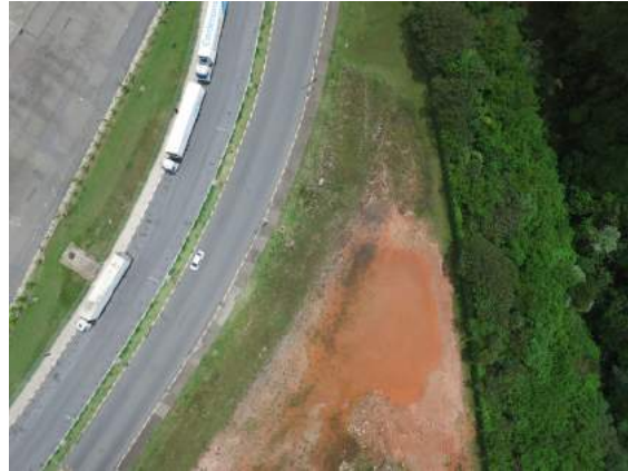
Foto 7.18 – Vista aérea em detalhe do local onde se pretende instalar a subestação. Sobrevoo VANT (out/18)
