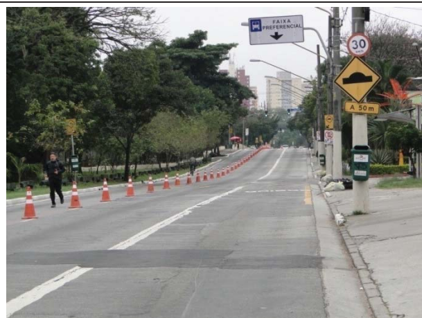
Foto 8.4.1.1-32: Vista, sentido leste, da Av. Governador Carvalho Pinto.
