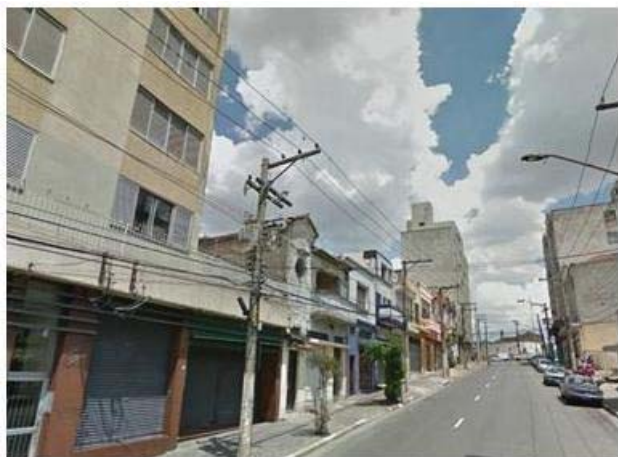
Foto 8.3.3.1-25: Vista da rua Catumbi, e ao fundo a av. Celso Garcia.
