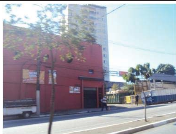
Foto 8.4.3.2.1-44: Detalhe dos imóveis a serem desapropriados na av. São Miguel próximo a rua Raimundo Machado.
