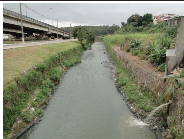
Foto 8.4.1.1-56: Vista do rio Jacu, que passa perpendicularmente sob a Av. São Miguel.
