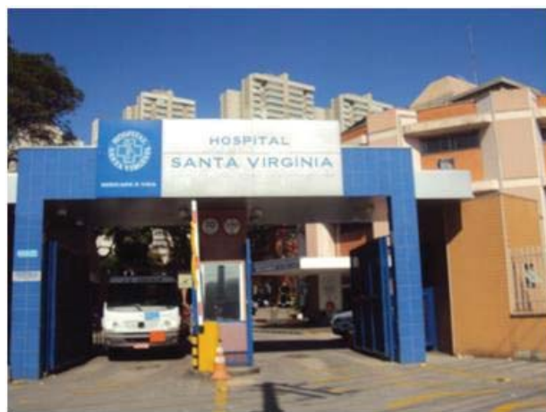
Foto 8.3.3.2-8: Vista do Hospital Particular Santa Virginia, localizado na Av. Celso Garcia.
