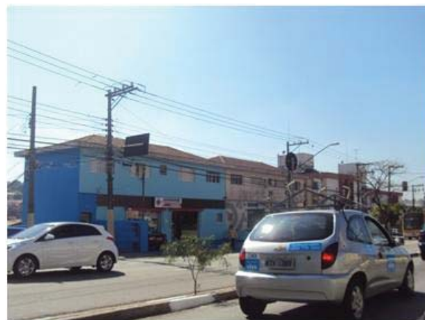
Foto 8.4.3.2.1-36: Vista geral da ADA na av. São Miguel, altura da rua São Celso.
