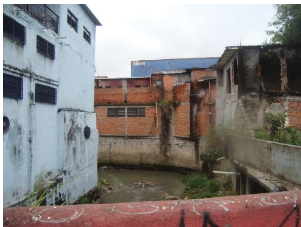
Foto 8.4.2.3-10: APP do Córrego da Ponte Rasa na Av. São Miguel completamente descaracterizada.
