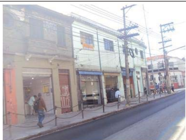
Foto 8.4.3.2.1-16: Comércio a serem desapropriados próximo a rua Ivaí.
