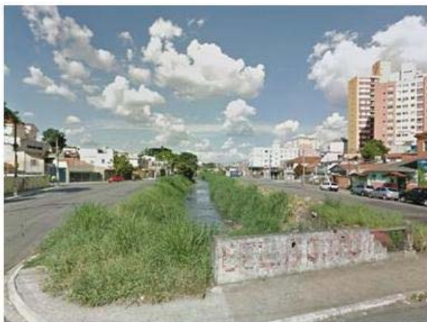
Foto 8.3.3.1-43: Vista geral da av. Buenos Aires.
