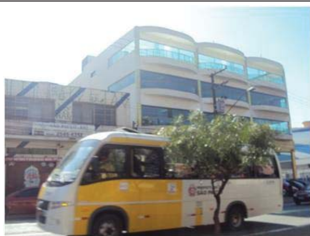
Foto 8.4.3.2.1-41: Vista do prédio de 3 andares a ser desapropriado, localizado na av. São Miguel, próximo a rua Rosa Mendes.
