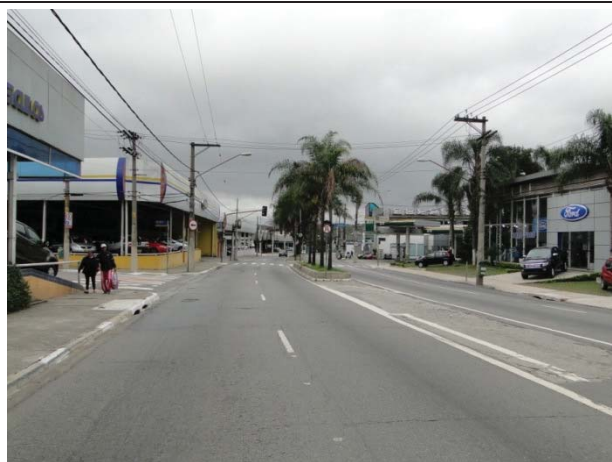
Foto 8.4.1.1-57: Vista, sentido centro, da avenida São Miguel.
