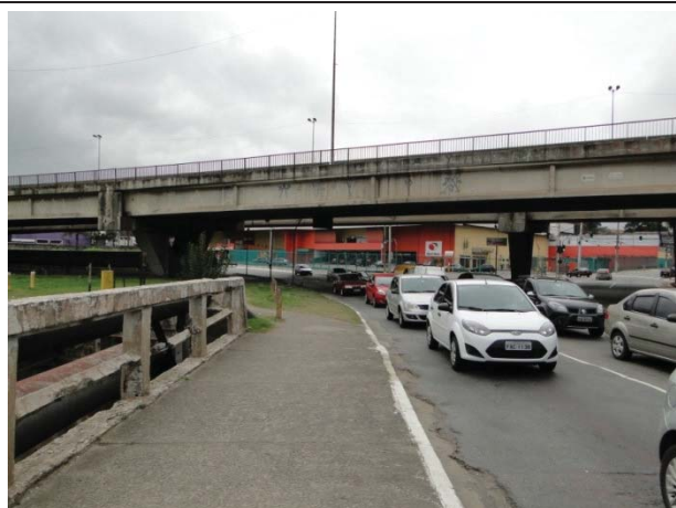
Foto 8.4.1.1-55: Vista, sentido leste, da Av. São Miguel. Neste ponto, sobre a ponte, ocorre inundação.
