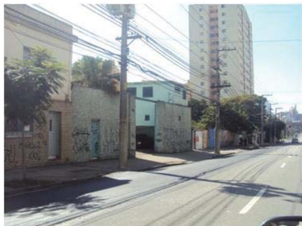
Foto 8.4.3.2.1-27: Detalhe dos imóveis localizados na av. Celso Garcia, próximo a rua Emboraí, a serem desapropriados.
