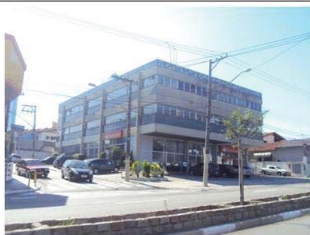
Foto 8.4.3.2.1-43: Detalhe do imóvel que será afetado com as obras, localizado na av. São Miguel com a rua Antônio Martins Silva.
