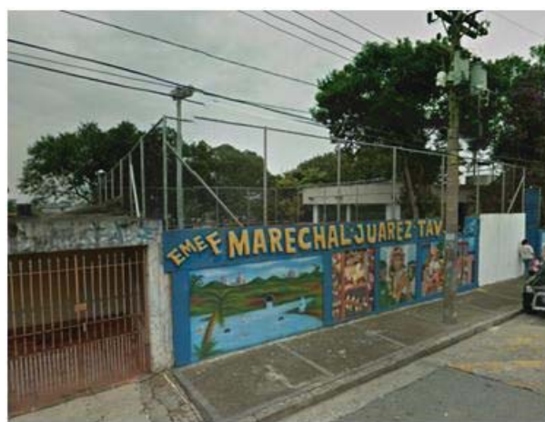
Foto 8.3.3.2-22: Detalhe da EMEF Marechal Juarez Távora, localizada na rua Japaraíquara.
