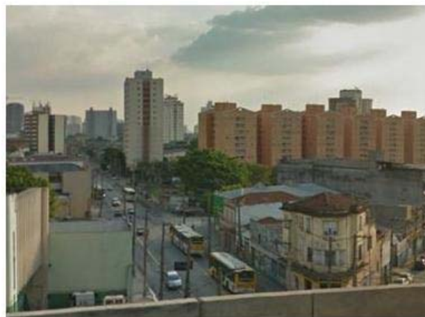
Foto 8.3.3.1-34: Vista geral da av. Celso Garcia sob o viaduto Eng. Alberto Braga.
