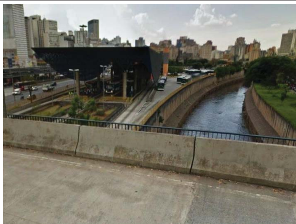
Foto 8.3.1.3-1: Vista do rio Tamanduateí a partir do viaduto Antônio Nakashima, sentido norte. Ao fundo, na esquerda, observa-se o Terminal Parque Dom Pedro.
