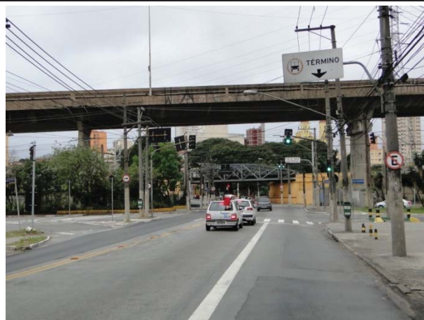
Foto 8.4.1.1-22: Vista da Av. Celso Garcia, sentido leste. Notar a frente o cruzamento em nível com a Av. Airton Pretini, sob a qual passa o rio Aricanduva. No alto da foto é possível observar o viaduto Eng. Alberto Badra.
