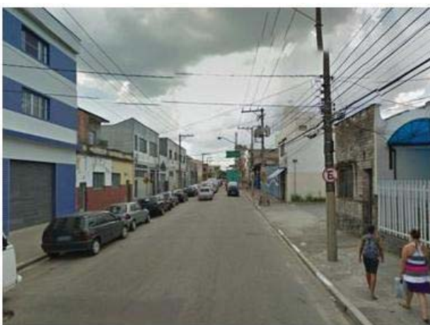
Foto 8.3.3.1-23: Vista geral da rua Coimbra, onde há residências e comércios, próximo a av. Celso Garcia.
