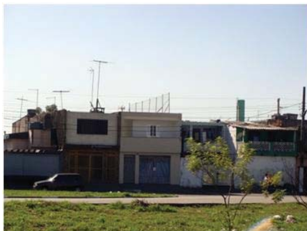
Foto 8.4.3.2.1-51: Imóveis a serem desapropriados para a instalação do Terminal São Miguel.
