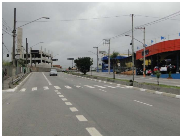
Foto 8.4.1.1-53: Vista, sentido centro, da avenida São Miguel.
