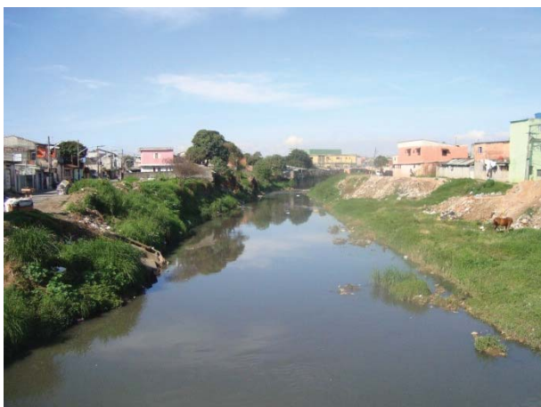
Foto 8.4.2.3-15: Vista geral para o rio Itaquera no trecho de intervenção, próximo à rua Abaitinga.
