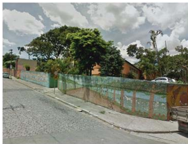
Foto 8.3.3.2-18: Detalhe da Escola Estadual Professora Irene Branco da Silva, localizado na rua Quarunas.
