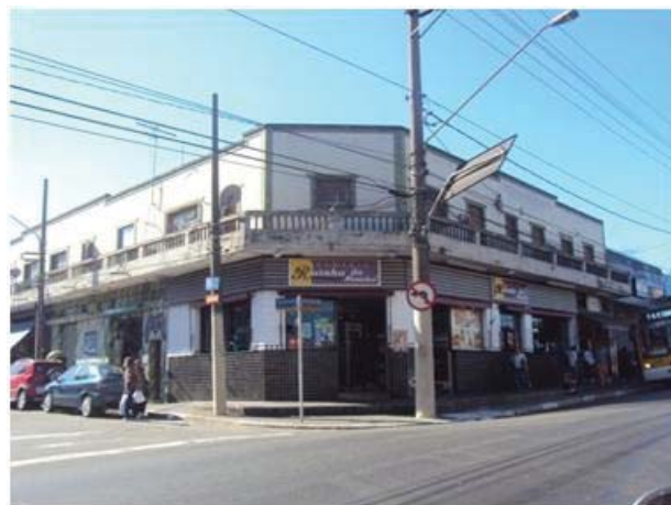
Foto 8.4.3.2.1-52: Detalhe dos imóveis comerciais a serem desapropriados na av. Marechal Tito com a rua Tito Guimarães Junqueira.
