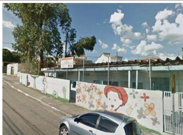
Foto 8.3.3.2-19: Vista da EMEI Mario Graciotti, localizada na AID do empreendimento.
