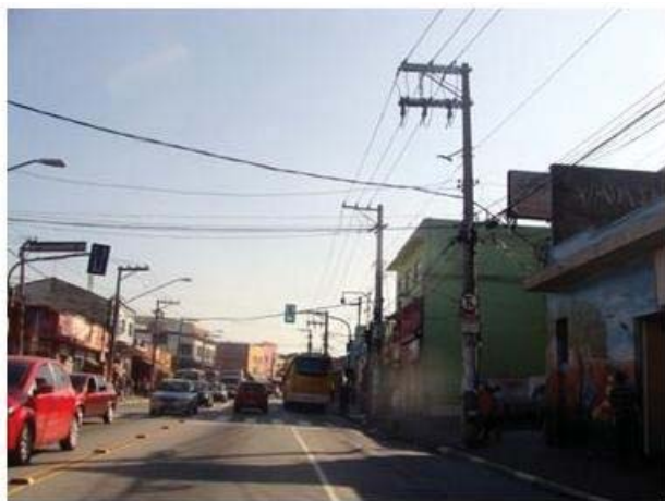
Foto 8.3.3.1-60: Vista geral da Av. Mal Tito.
