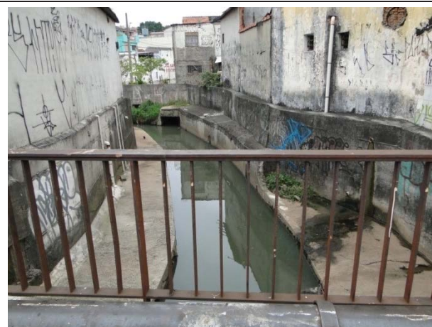
Foto 8.4.1.1-48: Vista do córrego Ponte Rasa, que passa perpendicularmente sob a Av. São Miguel.
