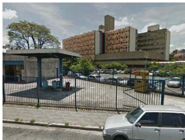
Foto 8.3.3.2-26: Hospital Municipal Dr. Alípio Correa Netto, localizado na alameda Rodrigo Brum.
