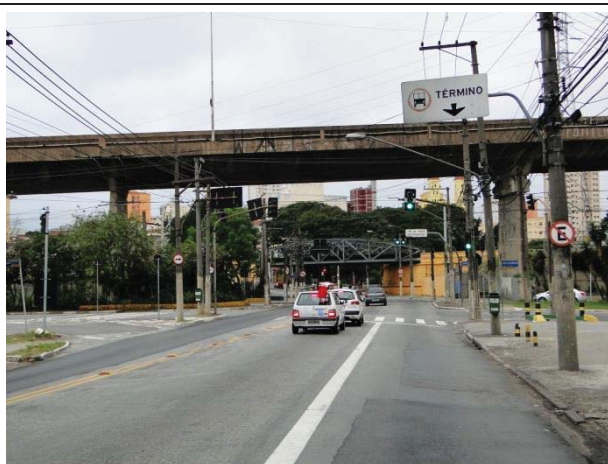
Foto 8.3.1.3-5: Vista, sentido leste, do cruzamento das avenidas Celso Garcia e Airton Pretini, sob a qual está o rio Aricanduva. No alto notar o viaduto Eng. Alberto Badra.
