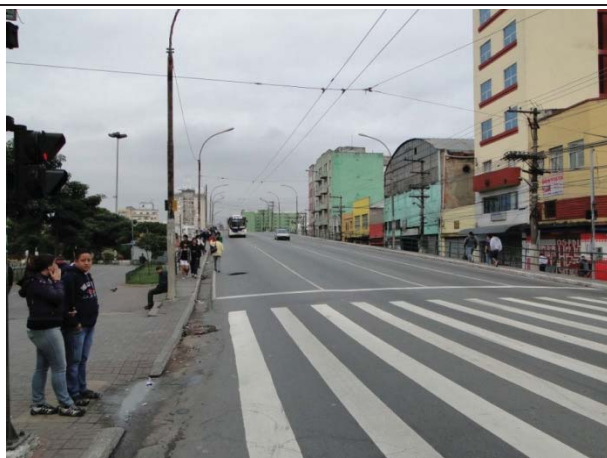
Foto 8.4.1.1-3: Vista do viaduto Maestro Alberto Marino, na avenida Rangel Pestana, sentido centro.
