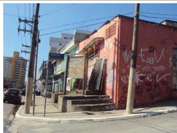
Foto 8.4.3.2.1-33: Detalhe dos comércios e residências a serem desapropriados na rua Diário de São Paulo com av. São Miguel.
