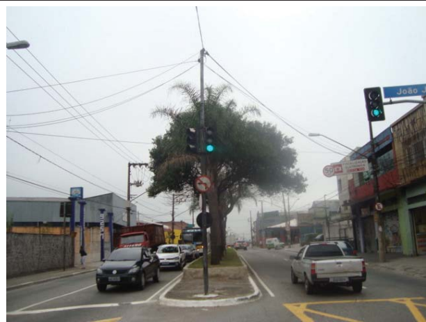
Foto 8.4.2.1-69: Trecho final de intervenção na Av. São Miguel, próximo à rua João José Rodrigues. O viário sofrerá alterações, fato que levará ao manejo dos exemplares arbóreos existentes no canteiro central.
