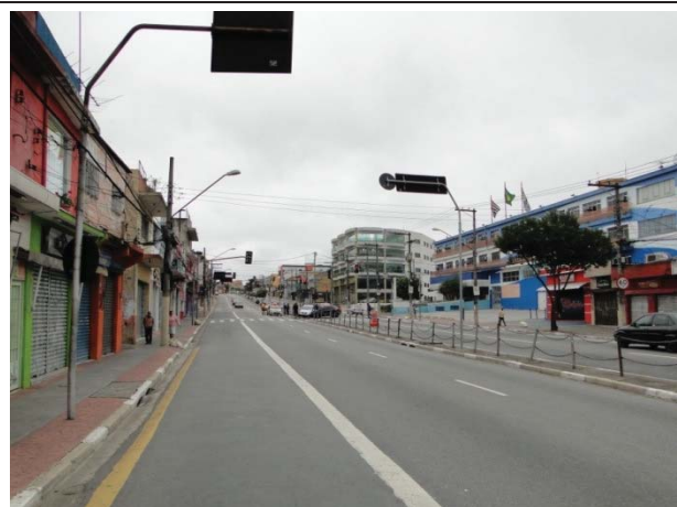
Foto 8.4.1.1-47: Vista, sentido centro, da avenida São Miguel.
