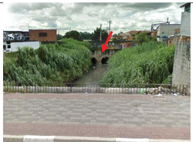
Foto 8.3.1.3-18: Vista, sentido nordeste, do ribeirão Lajeado, a jusante da Av. Marechal Tito. Notar a tubulação sub-dimensionada sob a linha férrea.
