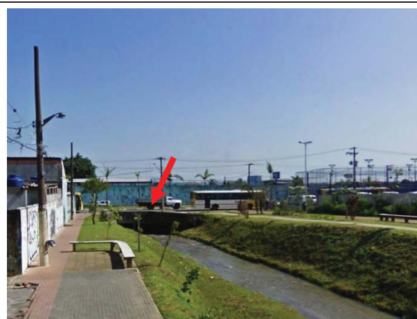
Foto 8.3.1.3-16: Vista, sentido norte, do córrego Água Vermelha. Ao fundo a avenida Marechal Tito, ponto onde a canalização passa a ser fechada.
