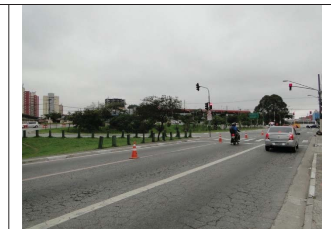
Foto 8.4.1.1-34: Vista, sentido leste, da Av. Gov. Carvalho Pinto. A frente observa-se o entroncamento das avenidas Gov. Carvalho Pinto e Av. São Miguel.
