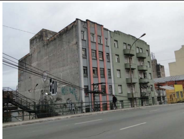
Foto 8.4.1.1-6: Vista do local onde será implantado o Terminal Concórdia.
