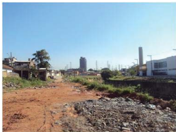
Foto 8.4.3.1-29: Vista da rua Dario Ferreira Martins sem pavimentação, onde está prevista a implantação do Terminal São Miguel.
