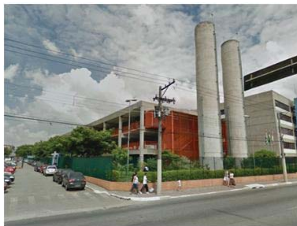
Foto 8.3.3.2-30: Vista geral do CEU Vila Curuça, localizado no final do trecho.
