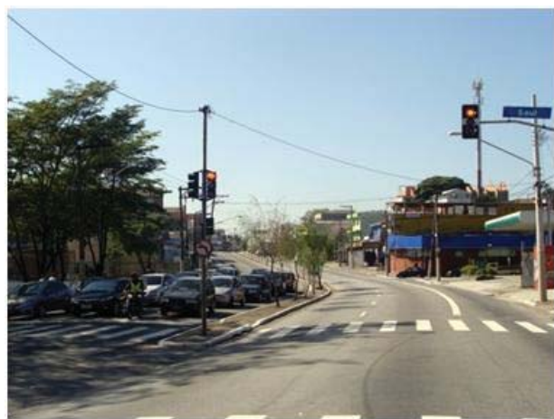
Foto 8.4.3.1-23: Vista geral da ADA., no início de avenida São Miguel.
