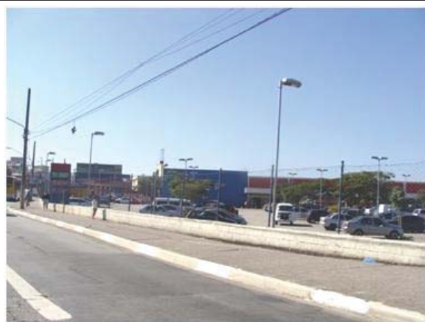
Foto 8.4.3.2.1-49: Rua Palmeira de Leque com a av. São Miguel, onde uma parte do supermercado Extra será desapropriada.
