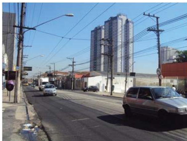
Foto 8.4.3.1-14: Final do trecho da intervenção na av. Celso Garcia.
