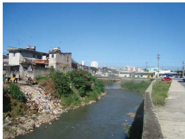
Foto 8.4.2.3-16: Áreas de Preservação do rio Itaquera completamente descaracterizadas no trecho de intervenção.
