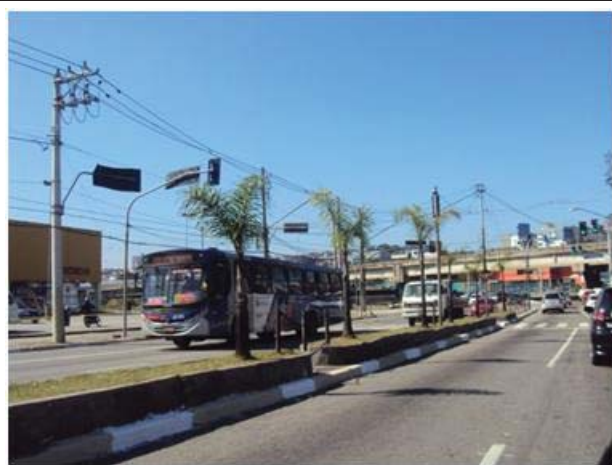
Foto 8.4.3.1-27: Vista geral da av. São Miguel, próximo da travessa Robert Morton.
