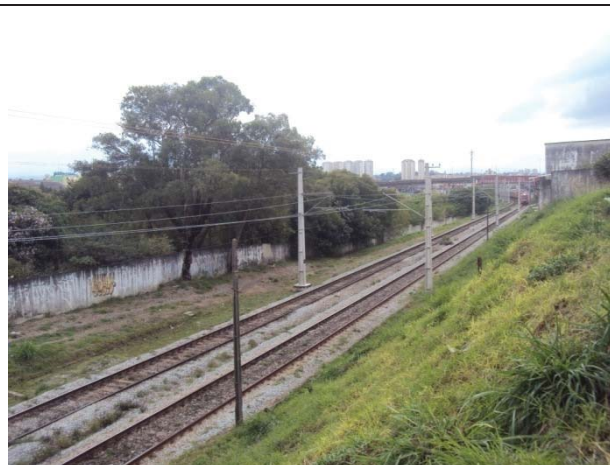
Foto 8.3.3.1-38: Vista da linha da CPTM, próxima a área de intervenção direta.
