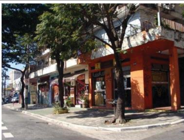
Foto 8.4.3.2.1-34: Detalhe dos comércios a serem desapropriados, localizados na av. São Miguel com rua Salomão Dana.
