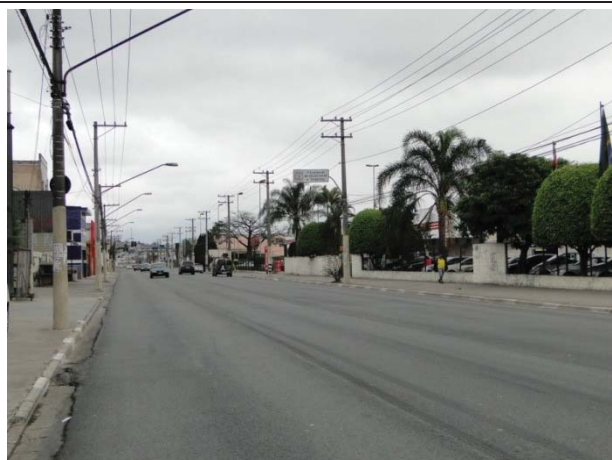
Foto 8.4.1.1-63: Vista, sentido centro, da avenida Marechal Tito.
