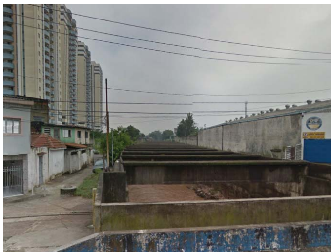
Foto 8.4.2.3-1: Rio Aricanduva canalizado.
