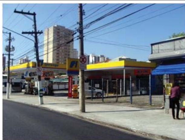
Foto 8.4.3.2.1-21: Detalhe do posto a ser desapropriado na av. Celso Garcia, próximo a rua Bernardo Magalhães.
