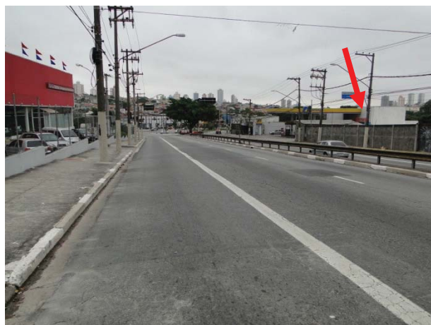
Foto 8.3.1.4-3: Trecho 3. Avenida São Miguel, sentido Avenida Governador Carvalho Pinto. Na esquerda da foto encontra-se a futura área de instalação do Terminal Ponte Rasa.
