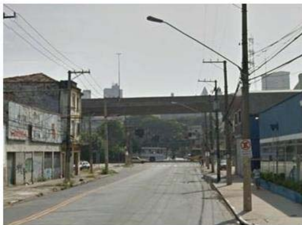
Foto 8.3.3.1-33: Final da av. Celso Garcia sob o viaduto Eng. Alberto Braga.
