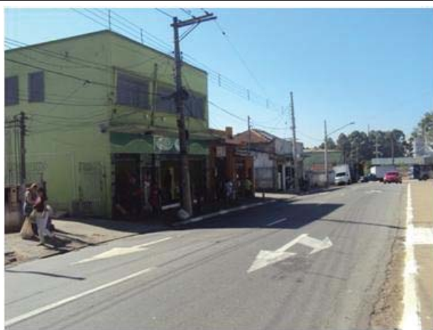
Foto 8.4.3.2.1-50: Detalhe da av. São Miguel próximo a Praça Padre Aleixo Monteiro Mafra, onde os imóveis serão afetados.
