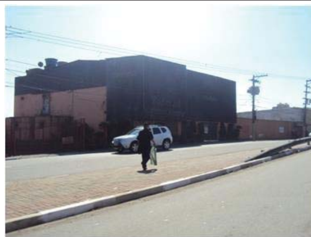
Foto 8.4.3.2.1-38: Detalhe dos imóveis a serem desapropriados na av. São Miguel, próximo a rua Carvalhópolis.
