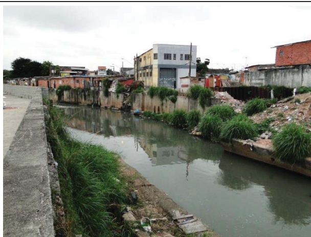
Foto 8.3.1.3-13: Vista, sentido norte, do rio Itaquera, a partir da rua Corvina, no ponto de cruzamento com a rua Abaitinga.
