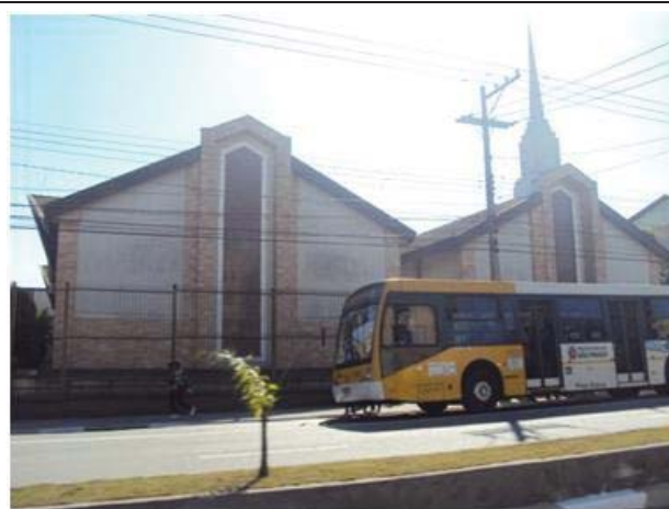
Foto 8.4.3.2.1-48: Detalhe da igreja a ser desapropriada na av. São Miguel próximo a av. Manoel dos Santos Braga.
