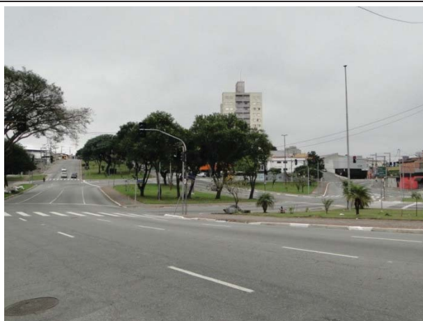
Foto 8.4.1.1-43: Vista, sentido centro, da avenida São Miguel.
