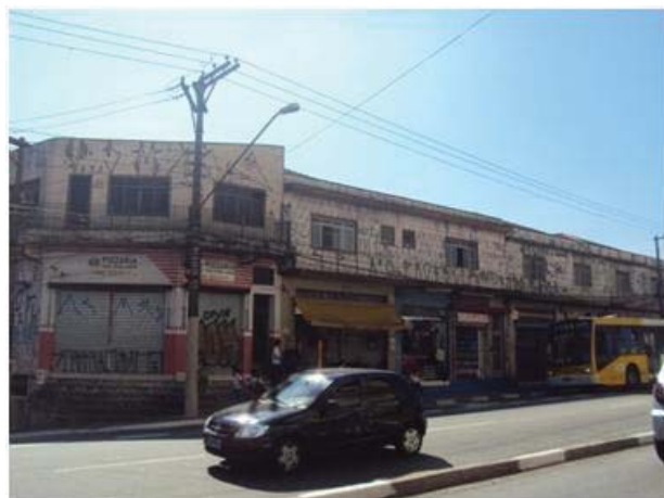
Foto 8.4.3.2.1-35: Vista dos imóveis sem uso a serem desapropriados na av. São Miguel, próximo a rua Fernão Alves.
