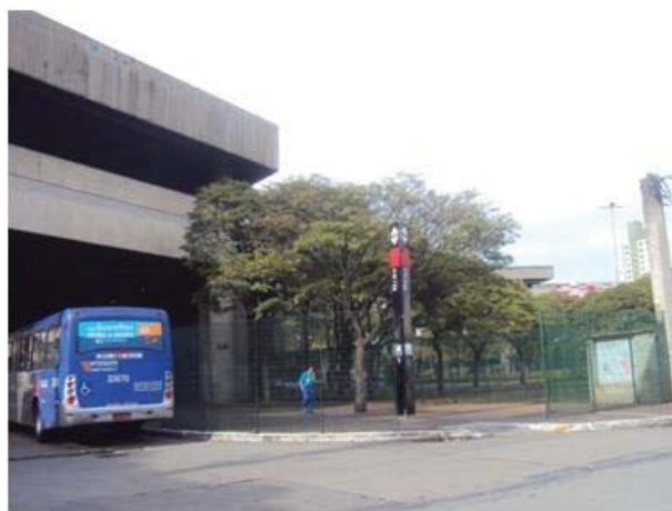
Foto 8.3.3.1-8: Vista Estação Brás do Metro.
