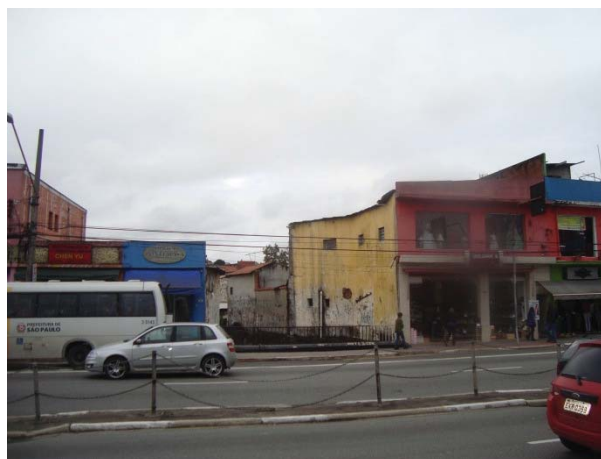
Foto 8.4.2.3-11: Av. São Miguel, em ponto de transposição do córrego da Ponte Rasa. Nota-se a APP do córrego ocupada por terrenos residenciais e comerciais.
