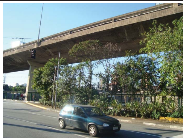
Foto 8.4.2.1-23: Demais exemplares arbóreos nativos e exóticos ocorrentes no canteiro central da Av. Aricanduva, a serem manejados para readequações do viário.
