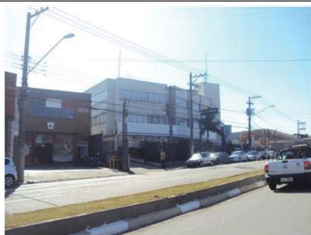
Foto 8.4.3.2.1-47: Detalhe dos imóveis a serem desapropriados na rua Manoel dos Santos Braga com av. São Miguel.
