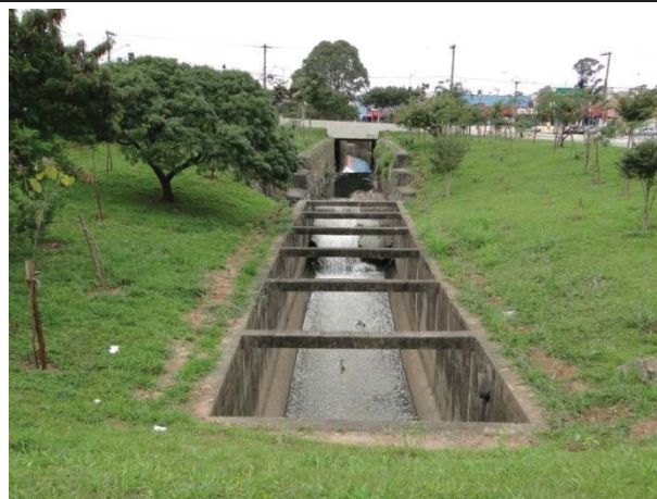
Foto 8.4.1.1-36: Vista do córrego Tiquatira, sentido cabeceira. Observar no topo da foto a ponte da Av. São Miguel, que faz sua transposição. Neste ponto ocorrem grandes inundações devido o aporte de água vindo do córrego Ponte Rasa.
