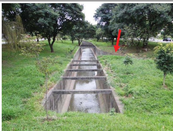
Foto 8.3.1.3-7: Vista do córrego Tiquatira, sentido oeste, próximo ao cruzamento das avenidas Governador Carvalho Pinto e São Miguel. Notar no canto superior direito a foz do córrego Ponte Rasa.
