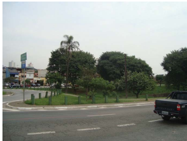
Foto 8.4.2.3-5: Trecho de interseção entre a Av. Gov. Carvalho Pinto e a Av. São Miguel. Nota-se a APP do córrego Tiquatira, preservada.
