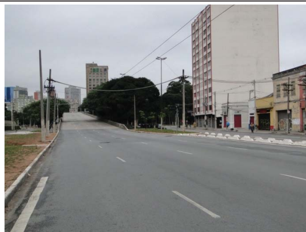
Foto 8.4.1.1-2: Vista da avenida Rangel Pestana, sentido centro. Ao fundo observa-se o viaduto Vinte e Cinco de Março.
