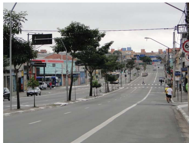
Foto 8.3.1.4-4: Trecho 4. Avenida São Miguel, sentido Avenida Jacú-Pêssego.
