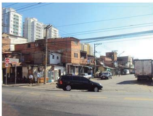
Foto 8.4.3.1-10: Detalhe da favela localizada na av. Celso Garcia.
