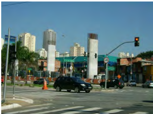
Foto 8.3.3.2.5-13: Notar em segundo plano a área de desapropriação para implantação do terminal
