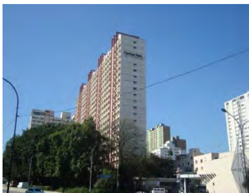
Foto 8.3.3.2.3-21: Conjunto Comercial – Av. 23 de Maio
