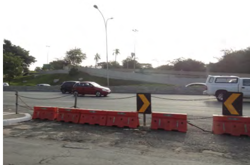
Foto 8.4.2.4.2-6: Visada tomada a partir da faixa de acostamento da Av. 23 de Maio, na área de influência do Córrego Boa Vista, cujo curso se dá por tubulações subterrâneas – APP 08.
