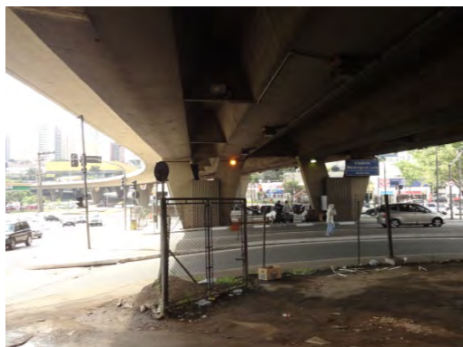
Foto 8.4.2.4.2-15: Vista geral da Av. Prof. Vicente Ráo. O córrego existente se encontra canalizado – APP 13
