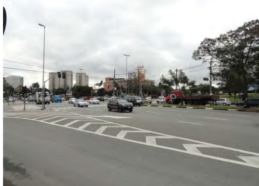
Foto 8.4.2.4.2-21: Vista geral da ADA do empreendimento, no cruzamento da Av. Interlagos com a Av. das Nações Unidas – APP 19.
