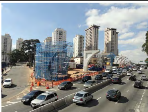
Foto 8.4.2.4.2-11: Vista geral da área de influência do Córrego Parque Colonial, que foi canalizado – APP 11.
