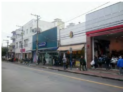
Foto 8.3.3.2.5-5: Imóveis a serem desapropriados junto à R. Leite de Moraes
