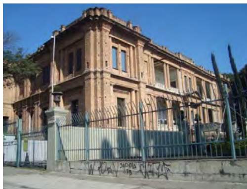
Foto 8.3.3.2.2-18: Pinacoteca do Estado de São Paulo – Avenida Tiradentes
