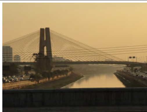
Foto 8.4.2.4.2-2: Ao fundo ponte estaiada, por onde o rio cruza – APP 01
