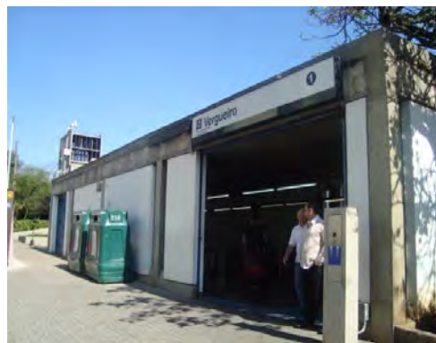
Foto 8.3.3.2.3-12: Entrada de acesso ao Metrô Vergueiro
