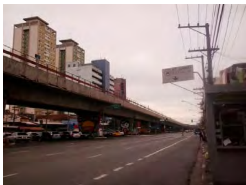
Foto 8.3.3.2.2-9: Avenida Cruzeiro do Sul
