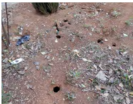
Foto 8.4.2.3.1-19: Tocas localizadas em talude na Avenida 23 de Maio.
