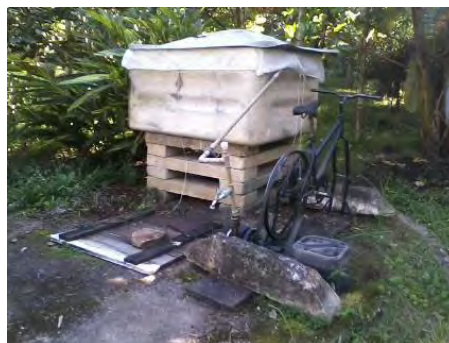
Foto 8.4.2.3.1-43: Caixa d'água tampada verificada no Parque.
