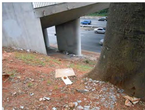
Foto 8.4.2.3.1-16: Vista de parte inferior de viaduto e resíduos inertes.
