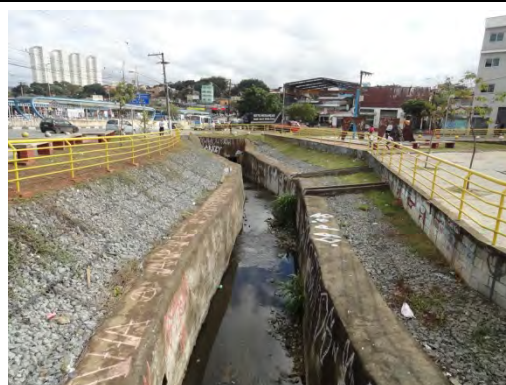
Foto 8.4.2.4.2-30: – Vista geral do curso d' água sem denominação, na porção a céu aberto, tomada a partir da passarela de acesso à Av. Dr. Sebastião Medeiros – APP 23.
