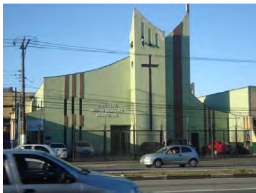
Foto 8.3.3.2.5-30: Equipamento Institucional junto à Av. Cupecê – junto à área prevista para desapropriação
