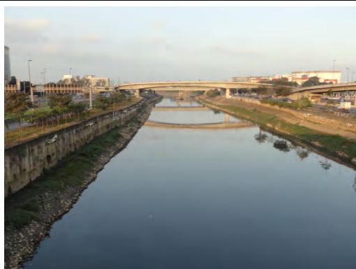
Foto 8.4.2.4.2-1: Vista geral da montante do Rio Tietê – APP 01.
