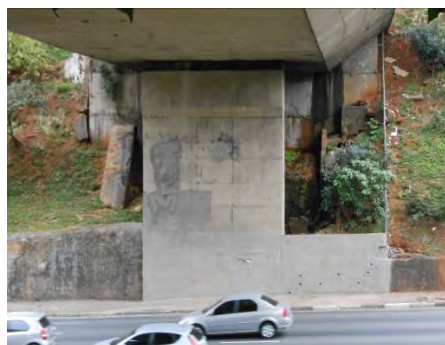
Foto 8.4.2.3.1-20: Vista de parte inferior de viaduto, local propício para abrigo de fauna sinantrópica.
