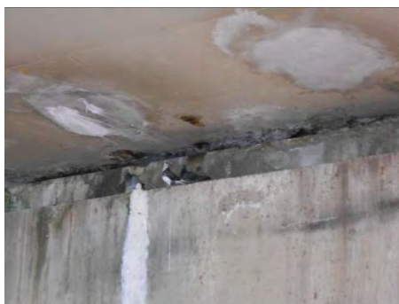
Foto 8.4.2.3.1-21: Indivíduos de Columba livia registrados na parte inferior de viaduto.
