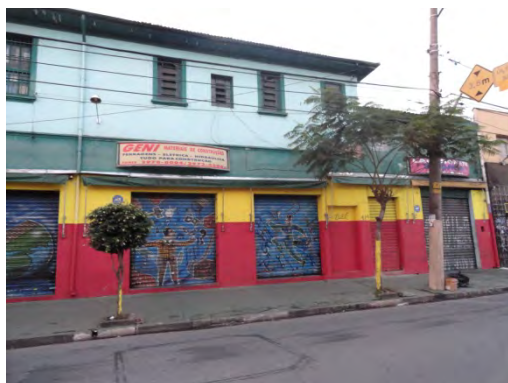
Foto 8.4.2.1-21: Vista geral da vegetação na Rua Darzan.
