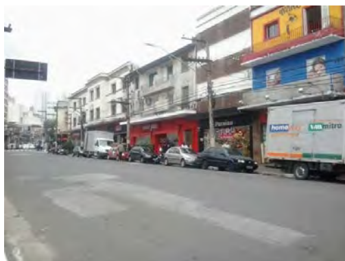
Foto 8.3.3.2.5-2: Imóveis na área prevista para desapropriação – R. Voluntários d Pátria
