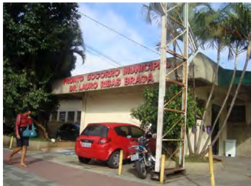
Foto 8.3.3.2.2-7: Pronto Socorro Municipal localizado junto à Avenida Voluntários da Pátria com Rua Santa Eulália
