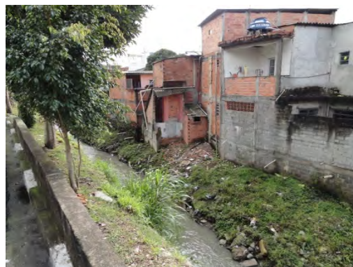
Foto 8.4.2.4.2-32: Vista geral, tomada a partir da calçada da Rua Leopoldo Lugonez. Percebe-se a presença de residências em sua margem direita – APP 24.
