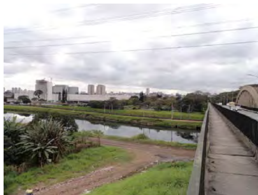
Foto 8.4.1.1-4: Vista sobre a ponte do Rio Pinheiros
