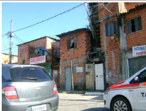
Foto 8.3.3.2.5-18: Observar tipologia de construção incidente na área.
