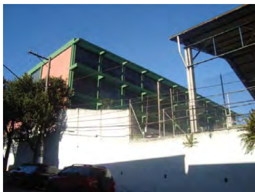
Foto 8.3.3.2.5-39: Equipamento Social na AID – Escola Estadual Leonor Quadros - AID
