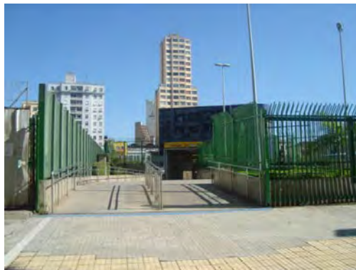
Foto 8.3.3.2.2-20: Metrô Luz – Linha Amarela
