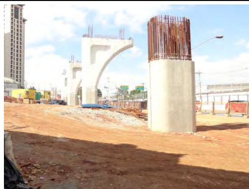
Foto 8.4.2.4.2-12: Vista geral das obras que estão sendo executadas na área, paralelamente à Av. 23 de Maio – APP 11.
