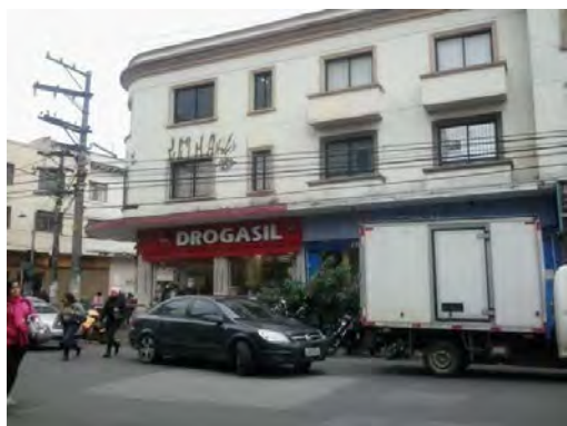
Foto 8.3.3.2.5-3: Vista de edificação a ser desapropriada, esquina das Ruas V. da Pátria e Leite de Moraes
