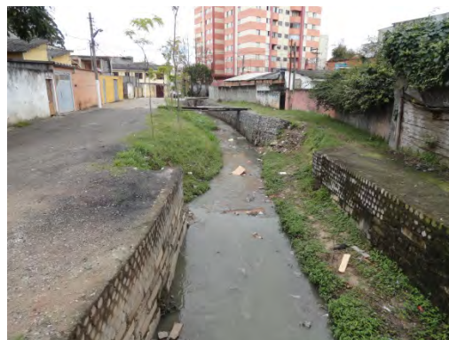
Foto 8.4.2.4.2-20: Continuação do córrego, ao longo da área que onde está prevista desapropriação – APP 17.
