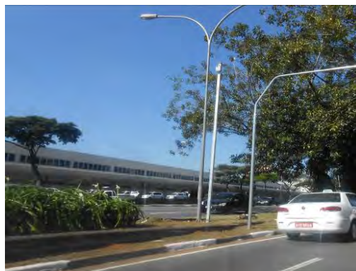
Foto 8.4.2.3.1-31: Vista geral do local das obras do monotrilho que está sendo executado.
