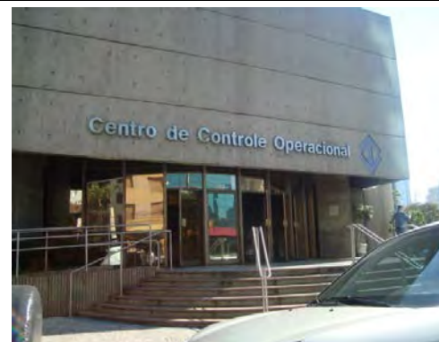
Foto 8.3.3.2.3-16: Centro de Controle Operacional do Metrô de São Paulo, junto à Rua Vergueiro
