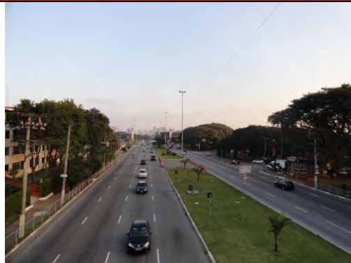
Foto 8.4.2.1-4: Vista geral da vegetação presente na avenida Santos Dumont.
