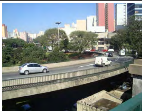
Foto 8.3.3.2.3-6: Viaduto de acesso a Av. 23 de Maio – Bela Vista
