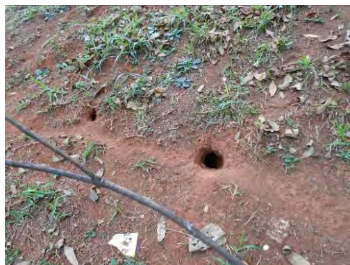
Foto 8.4.2.3.1-18: Tocas localizadas em talude na Avenida 23 de Maio.
