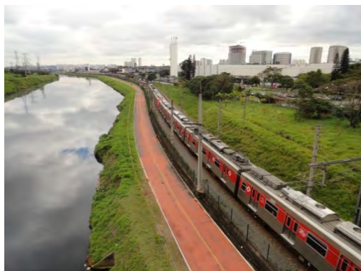
Foto 8.4.2.4.2-25: Vista geral da montante do Rio Jurubatuba. Percebe-se em sua margem, a presença de linha da CPTM – APP 21.
