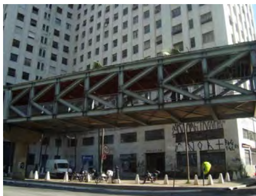
Foto 8.3.3.2.2-22: Passarela de acesso de pedestres para o terminal de ônibus Bandeira
