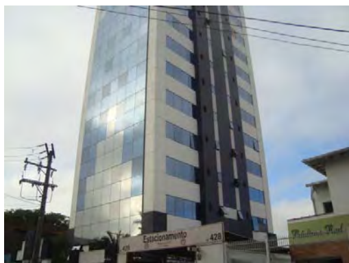
Foto 8.3.3.2.2-1: Conjunto comercial junto à Rua Duarte de Azevedo - Santana
