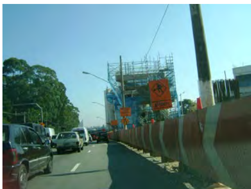
Foto 8.3.3.2.4-3: Obras de implantação do Sistema Monotrilho – Distrito Campo Belo
