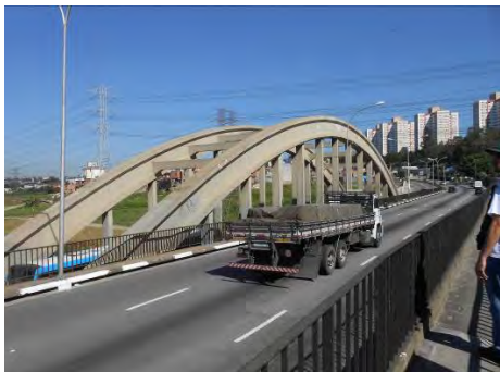
Foto 8.4.2.3.1-34: Vista geral da Ponte Jurubatuba .
