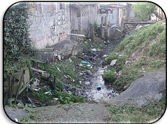
Canal de Saneamento
