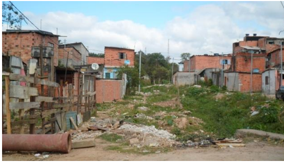
Foto 8.2.3.1.4-9 – Parque Linear Ribeirão Cocaia - vista da Rua Alziro Pinheiro Magalhães para as moradias irregulares inseridas em área de parque.
