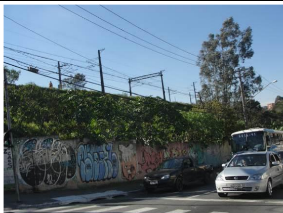
Foto 8.2.3.1.3-3 – A faixa de domínio da Linha 9 Esmeralda da CPTM é formada por campos antrópicos e árvores isoladas, sendo área verde representativa na SUC da APRM-Guarapiranga (Rua Dr. Oscar Andrade de Lemos – coordenada UTM 327185/7374073).
