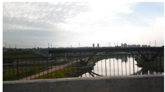
Foto 8.1.3.1.4-6 – Parque Linear Jurubatuba – Rio Jurubatuba vista de cima da ponte Interlagos.
