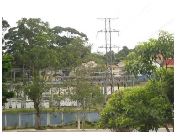
Foto: 8.2.2.3 -2 – Subestação de energia elétrica
