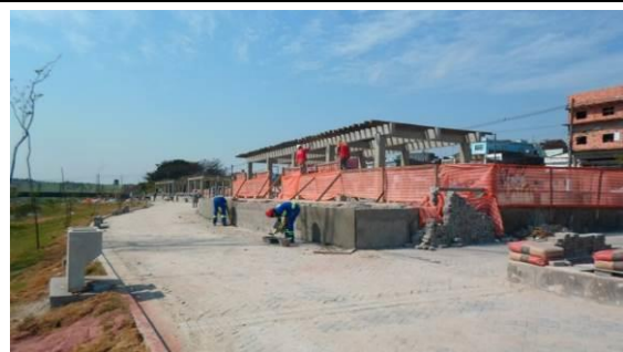
Foto 8.1.3.1.4-20 – Parque Linear Ribeirão Cocaia – detalhe para as obras de infraestrutura do parque.
