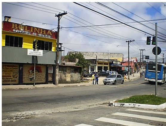
Foto 8.2.1.2-14 – Confluência da rua Antônio José Escudeiro (praça Alfredo Alves de Oliveira) com a avenida Dona Belmira Marin – Ponto crítico suscetível a alagamento.
