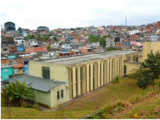
Foto 8.2.3.1.5-15 – Vista geral da AMA Jardim Castro Alves, com cobertura vegetal formada por gramados e árvores isoladas (Rua Prof. Adolpho Pinheiro Machado – coordenada UTM 328171/7373276).
