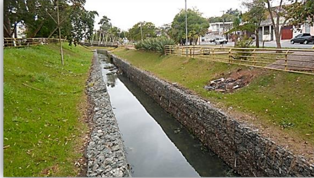
Foto 8.2.1.2-1 - Vista para o Córrego Rio das Pedras próximo a Rua Eduardo Ramos.
