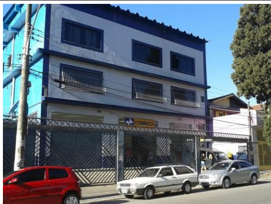
Foto: 8.2.2.3 -1 – Agencia dos Correios – Av. do Arvoreiro.
