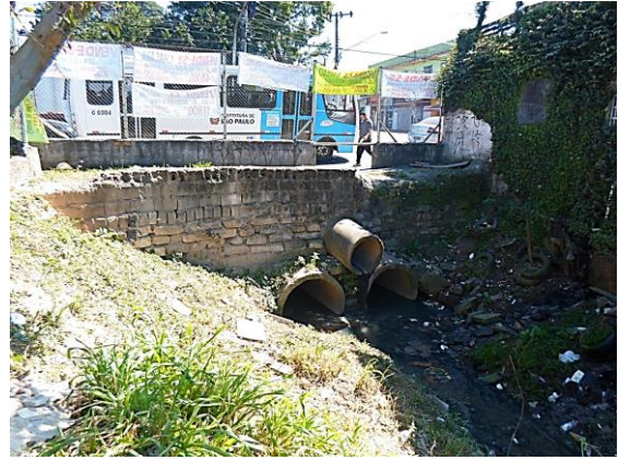
Foto 8.2.1.2-13 – Córrego (sem nome) afluente do ribeirão Cocaia - Vista para a saída de água da tubulação após cruzar a avenida Dona Belmira Marin.
