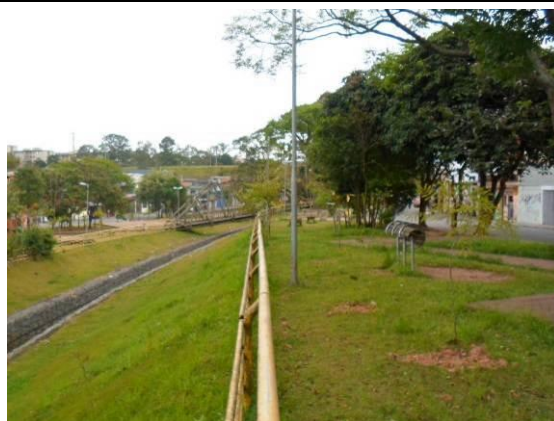
Foto 8.2.3.1.3-4 – Vista do Parque Linear América localizada na SUC da APRM-Guarapiranga. O córrego encontra-se canalizado e a APP recuperada com elementos paisagísticos: gramíneas e árvores isoladas (Rua Ângelo Prado - coordenada UTM 327440/7374050).
