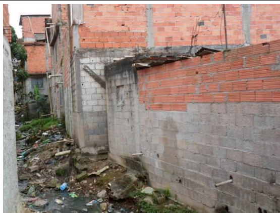
Foto 8.2.3.1.3-6 – Detalhe de ocupação irregular às margens de córrego localizado na AID. A faixa de APP ainda permeável restringe-se a poucos metros além do leito do curso d'água. Tal situação é bastante comum nas SUCs da APRM-Billings (Travessa da Rua Torquato Tapajós – coordenada UTM 327889/7372986).
