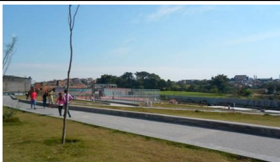
Foto 8.1.3.1.4-19 – Parque Linear Ribeirão Cocaia - vista para a o passeio recém colocado.
