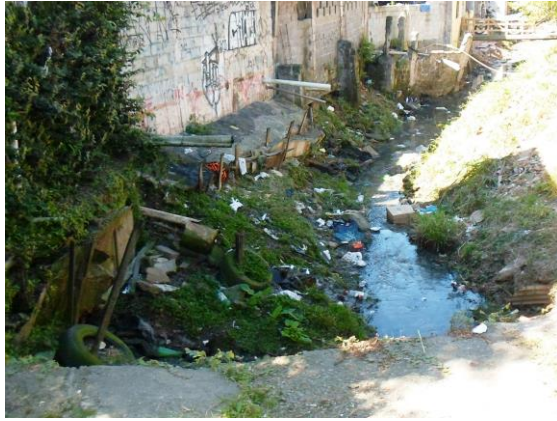
Foto 8.2.1.2-12 – Córrego (sem nome) afluente do ribeirão Cocaia – Esgoto in natura sendo lançado diretamente no córrego.
