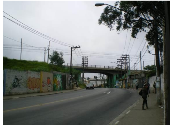
Foto 8.3.2.2- 4 – Av. Dna. Belmira Marin, vista da passagem por baixo dos trilhos do trem
