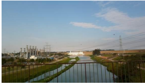
Foto 8.1.3.1.4-3 – Parque Linear Jurubatuba – Rio Jurubatuba vista de cima da ponte Interlagos.
