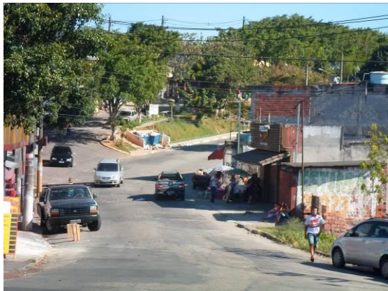
Foto 8.2.2.4-11- Via de mão dupla sem sinalização e com asfaltamento precário
