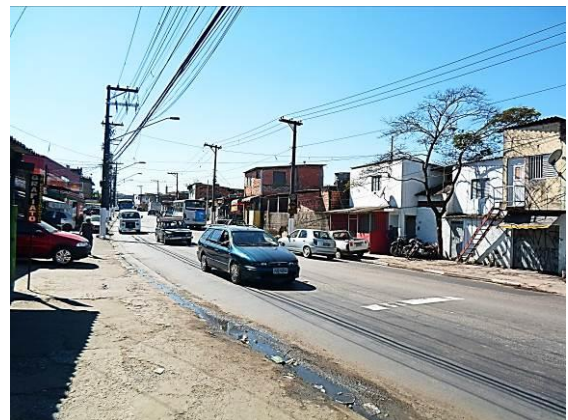
Foto 2.7-2 – Vista para as condições do pavimento e da sinalização horizontal em trecho da Avenida Dona Belmira Marin.
