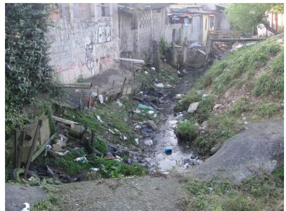
Foto 8.3.3.2-6 – Canal de Saneamento.
