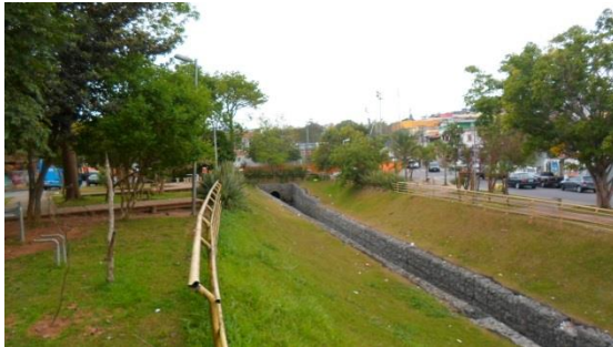
Foto 8.2.3.1.7-5 – Vegetação Significativa - Praça 'sem nome', localizada entre a Rua Ângelo Prado e Rua Eduardo Ramos, atual Pq. Linear América.
