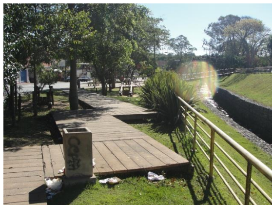
Foto 8.2.3.1.8-12 – Praça “sem nome” na Rua Eduardo Ramos.
