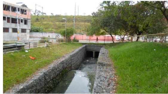
Foto 8.2.3.1.4-2 – Parque Linear América - vista para a canalização do córrego.
