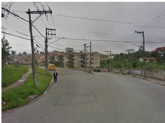
Foto 8.1.2.4-23- Via de mão dupla com asfalto e calçadas em estado precário
