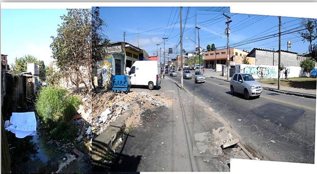
Figura 8.3.1.2-2 – Vista geral da galeria da Estaca 124+14,50m (sentido Centro – Bairro)
