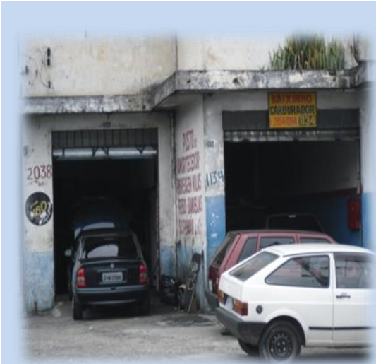
Oficina mecânica sem denominação altura do nº . 2038
