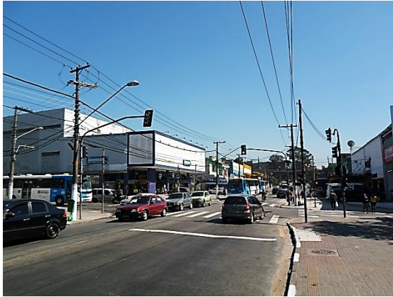
Foto 8.2.1.2-10 – Vista para o cruzamento da avenida Dona Belmira Marin com avenida Grande São Paulo/ rua Leri Santos – Ponto crítico suscetível a alagamento.
