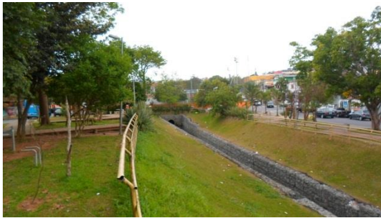
Foto 8.2.3.1.4-1 – Parque Linear América - vista para a canalização do córrego.
