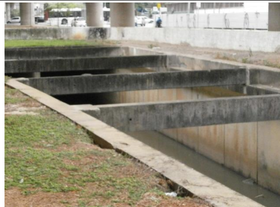
Foto 7.2.9-16 - Córrego Água Espraiada, vista para jusante.
