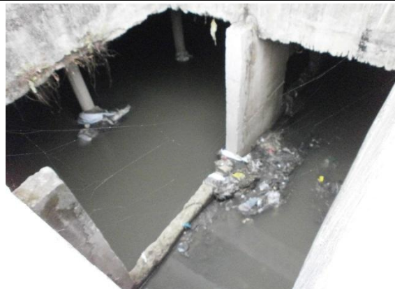
Foto 7.2.9-15 - Dreno do Brooklin, na altura do encontro com o Córrego Água Espraiada.
