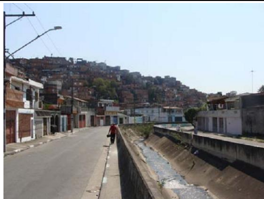
Foto 7.2.9-12 - Córrego Ponte Baixa na rua Leonilda Kimori. O Monotrilho terá parte do seu traçado ao longo desta via.
