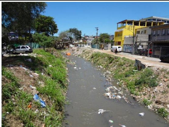
Foto 7.2.9-7 - Córrego do Capão Redondo, vista para montante, a partir da R. Dezenove, no Jardim São José.
