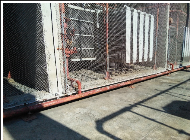
Foto 10: Detalhe dos transformadores antigos, que serão substituídos na ETD Paula Souza
