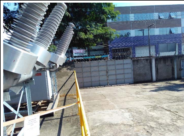
Foto 04: Visão geral da entrada da ETD
