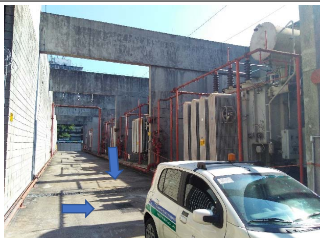
Foto 07: Detalhe de canaletas de drenagem pluvial ao longo do arruamento da ETD Paula Souza.
