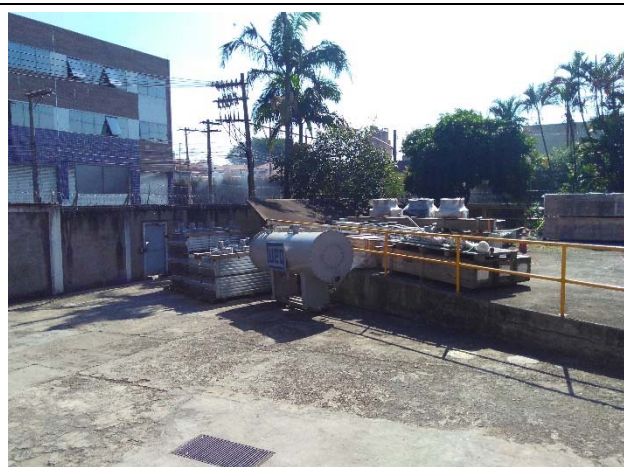
Foto 05: Por apresentar uma área externa livre de equipamentos a ETD é utilizada como depósito temporário. Durante a modernização, essa área servirá de apoio as atividades a serem realizadas.
