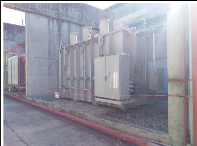
Foto 12: Transformador novo, aguardando a obtenção das devidas licenças e início das atividades de modernização da ETD, para ser colocado em atividade, alocado em uma baia ociosa da ETD Paula Souza.
