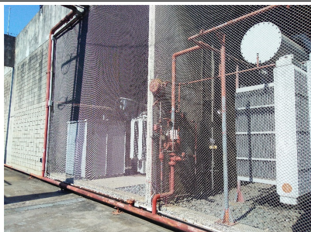
Foto 11: Detalhe dos transformadores antigos, que serão substituídos na ETD Paula Souza
