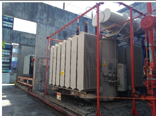
Foto 09: Detalhe dos transformadores antigos, que serão substituídos na ETD Paula Souza.
