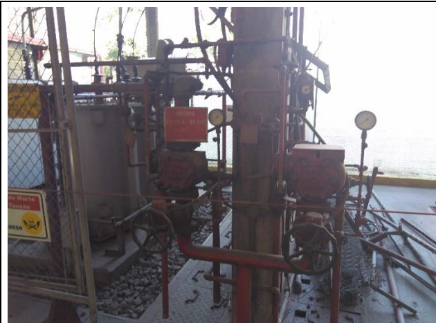
Foto 08: Detalhe de mecanismos de contenção de incêndio.
