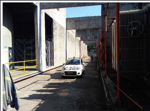
Foto 02: Visão geral do arruamento interno da ETD Paula Souza.
