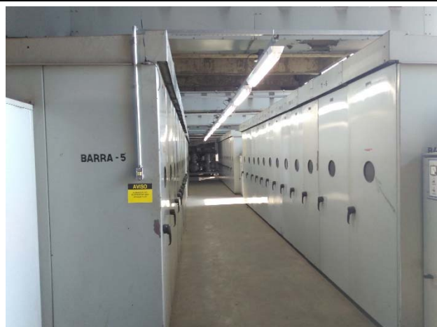
Foto 03: Vista da casa de controle que sofrerá algumas alterações para modernização de alguns equipamentos
