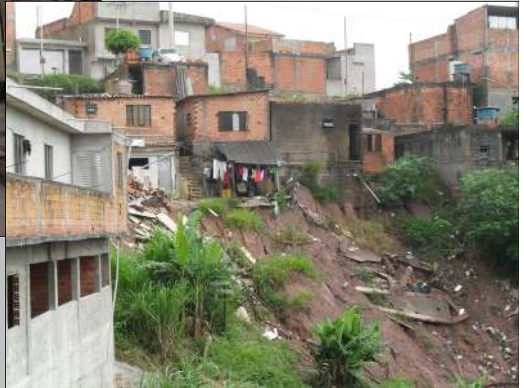
SM-08-05: Vista do escorregamento no setor. Notar exposição das fundações das moradias. MUITO ALTO →
