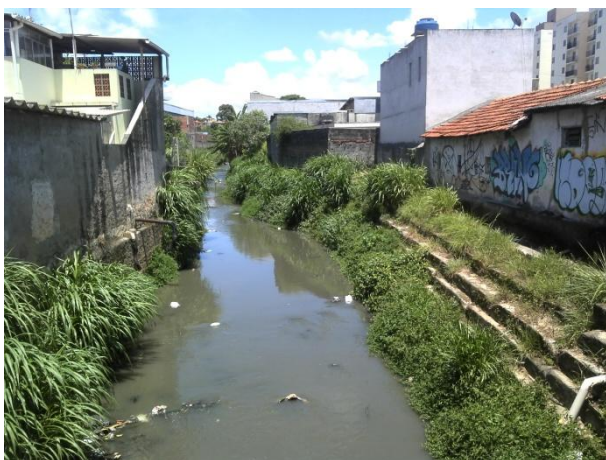
Foto 10.3.2.5-3: Vista de trecho do Córrego Tremembé onde se observa, à esquerda na foto, muro de propriedade na margem do curso d'água. 25/11/2014.
