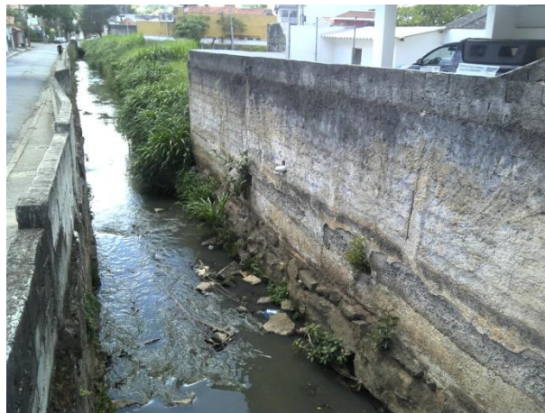
Foto 10.3.2.5-6: Vista de trecho do Córrego Tremembé onde se observa, a direita na foto, muro de propriedade e, à esquerda, muro de limite da rua. 25/11/2014.
