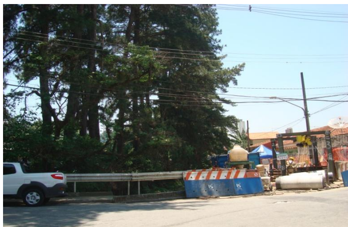
Foto 7.1-1: Obras da SABESP ao final da Rua Mamud Rahd, junto ao Córrego Tremembé, para implantação de galerias de inspeção e coletores-tronco.
