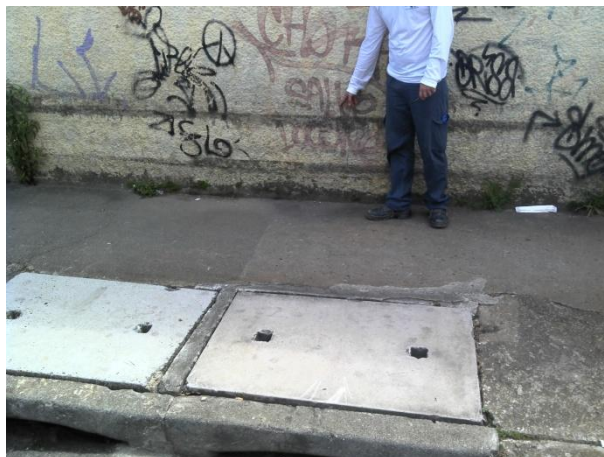
Foto 10.3.1.6-5: A marca d'água na parede refere-se a evento de inundação, exemplificando a ineficiência das estruturas de drenagem. 25/11/2014.
