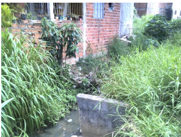
Foto 10.3.2.7-3: Córrego da Cantareira: observar a ausência de APP, a proximidade das edificações ao canal, resíduos sólidos descartados de forma irregular, provavelmente transportados de áreas de montante, e as tubulações de esgoto voltadas para o curso d'água. 25/11/2014.
