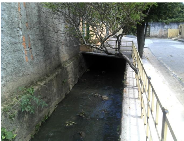
Foto 10.3.2.5-7: Vista de trecho do Córrego da Cantareira onde se observa, a esquerda na foto, muro de propriedade e, à direita, muro de limite da rua. 25/11/2014.
