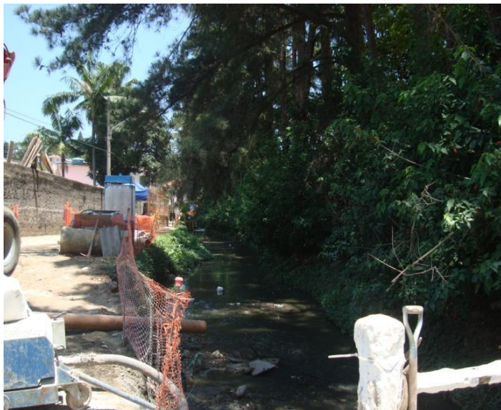
Foto 7.1-2: Obras da SABESP ao final da Rua Jupiuba, junto ao Córrego Tremembé, para implantação de galerias de inspeção e coletores-tronco.
