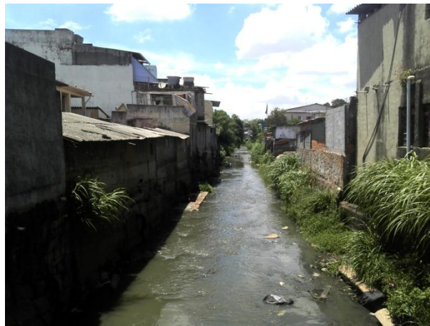
Foto 11.3.2.5-2: Vista de trecho do Córrego Tremembé onde se observa-se o seu confinamento entre muros. 25/11/2014.
