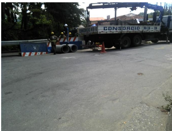
Fotos 10.3.1.8-3 e 10.3.1.8-4: Obras no sistema de microdrenagem podendo causar turbidez do corpo d'água. 25/11/2014.
