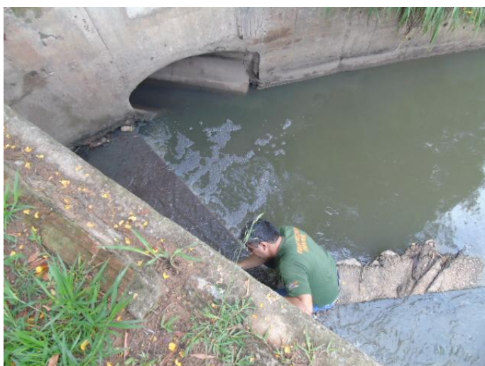
Foto 10.4.2.1-9 – Varredura em possíveis abrigos.
