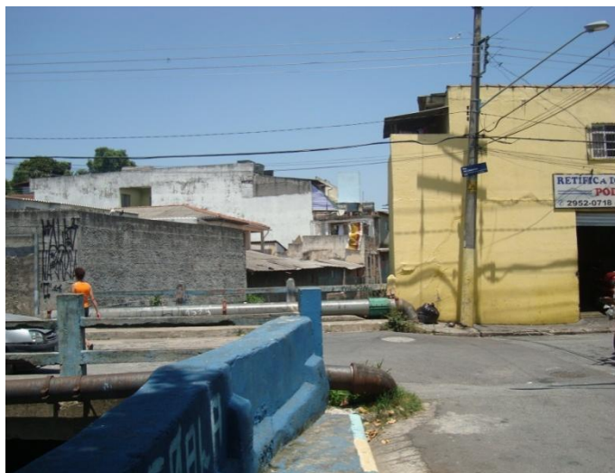
Foto 10.5.3.3-4: Adutoras de água junto à ponte da rua das Casarinas, sobre o Córrego Tremembé, no trecho B.
