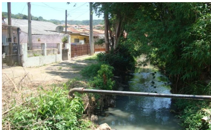
Foto 10.5.3.3-1: Adutora de água no início da área de projeto, no Trecho A, rua Francisco Inglês.
