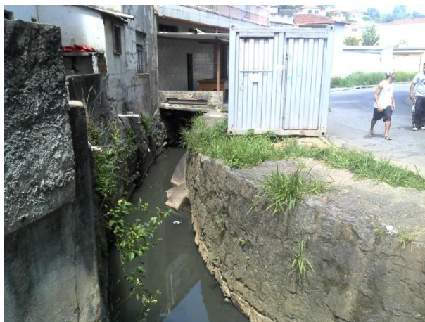
Foto 10.3.2.7-2: Córrego da Cantareira: observar a ausência de APP, a proximidade das edificações ao canal e as tubulações de esgoto voltadas para o curso d'água. 25/11/2014.
