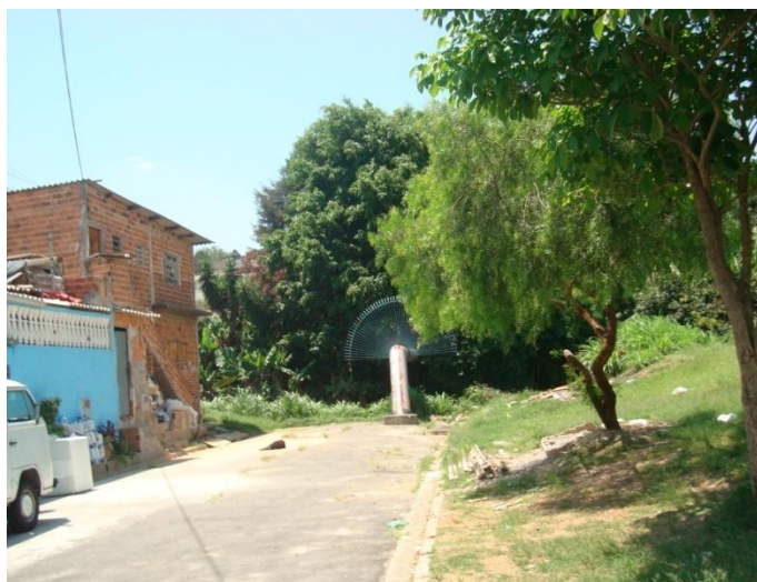
Foto 10.5.3.3-5: Adutora de água ao final da rua Atos Ribeiro, ao lado do campo de futebol onde está previsto o reservatório 5.
