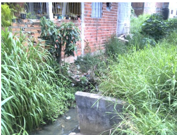
Foto 10.3.1.1-1: Moradias em área de várzea do Córrego Tremembé.
