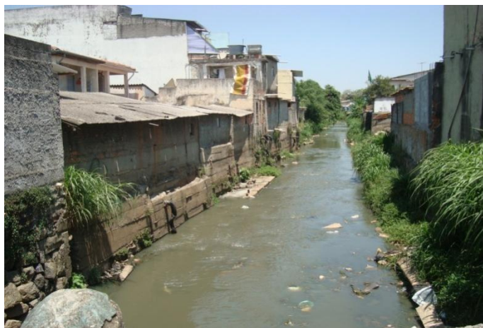
Foto 10.5.3.2-13: Vista a partir da ponte sobre o Córrego Tremembé na rua Casuarinas (trecho B): imóveis próximos ao Córrego, a princípio fora da ADA mas que merecerão atenção especial.
