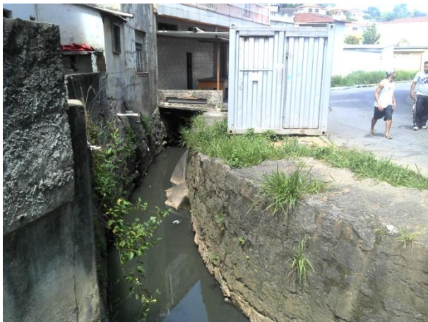
Foto 10.3.1.8-1: Descarte de efluentes no corpo d'água. 25/11/2014.
