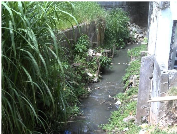
Foto 10.3.2.5-5: Vista de trecho do Córrego da Cantareira onde se observa a contenção da margem esquerda do curso d'água com concreto e muro de propriedade, à direita. 25/11/2014.
