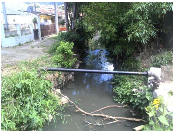
Foto 10.3.2.7-5: Córrego da Cantareira: observar a ausência de APP, a proximidade das edificações ao canal, a presença de resíduos sólidos descartados de forma irregular e as tubulações de esgoto voltadas para o curso d'água. 25/11/2014.
