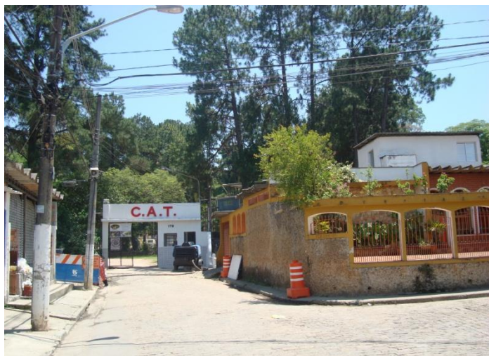
Foto 10.5.2.2-3: Clube Atlético Tremembé – CAT, ao final da rua Jupiuba, com acesso sobre o Córrego Tremembé. Está inserido na AID mas não será afetado pelas obras.
