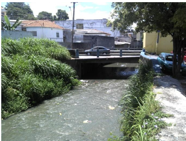
Foto 10.3.2.5-11: Vista de trecho do Córrego Tremembé onde se observa ponte de pequena altura. 25/11/2014.
