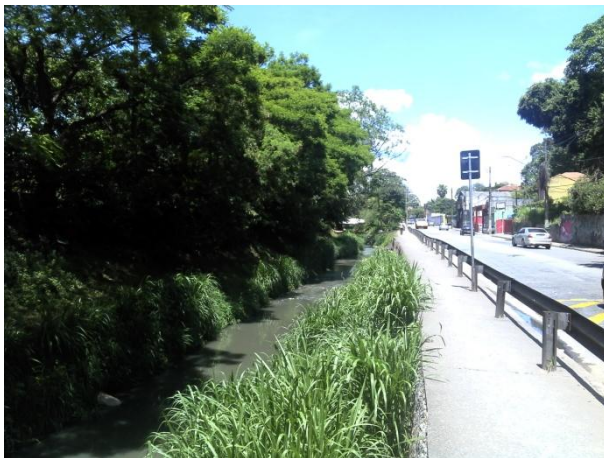
Foto 10.3.2.5-9: Vista de trecho do Córrego Tremembé onde se observa, à direita na foto, muro de limite da rua. 25/11/2014.
