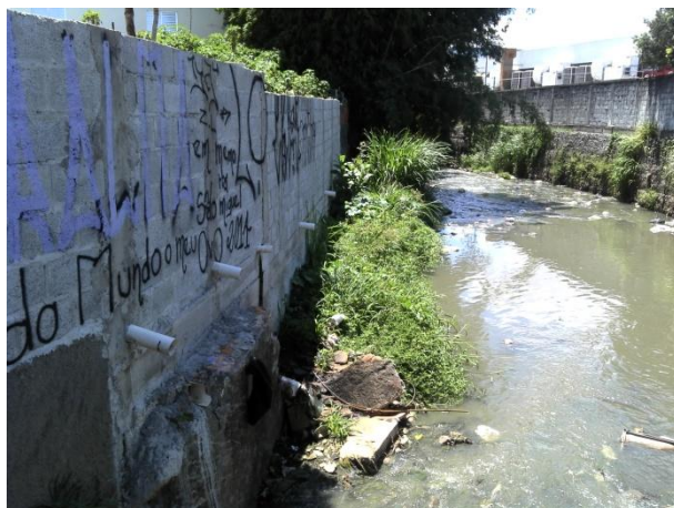
Foto 10.3.2.7-6: Córrego Tremembé: observar a ausência de APP, a proximidade das edificações ao canal, a presença de resíduos sólidos descartados de forma irregular e as tubulações de esgoto voltadas para o curso d'água. 25/11/2014.
