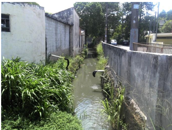
Foto 10.3.2.7-1: Córrego Tremembé: observar a ausência de APP, a proximidade das edificações ao canal e as tubulações de esgoto voltadas para o curso d'água. 25/11/2014.
