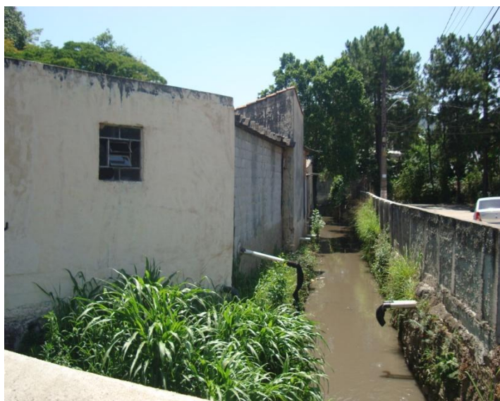
Foto 10.5.2.2-1: Lançamento de efluentes domésticos ao fundo de imóveis localizados na rua Prof. Pedro Pedreschi
