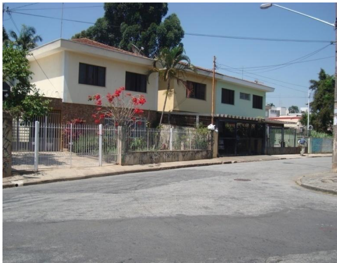
Foto 10.5.3.2-11: Imóveis da rua Raul de Moraes Vitor, junto ao encontro com a rua Conchilia, que serão totalmente removidos.
