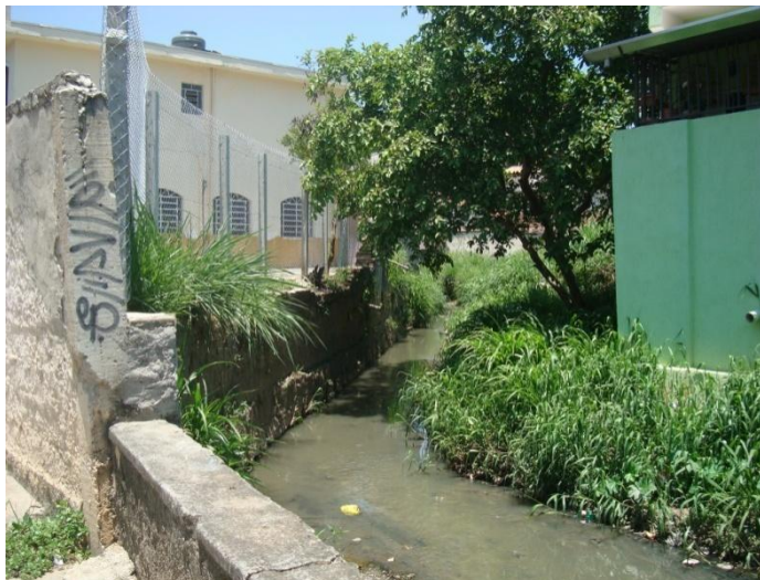
Foto 10.5.3.2-15: Trecho da rua Francisco Inglês onde atualmente o Córrego percorre o fundo dos lotes de residências que não estão inseridas na ADA mas demandarão atenção.
