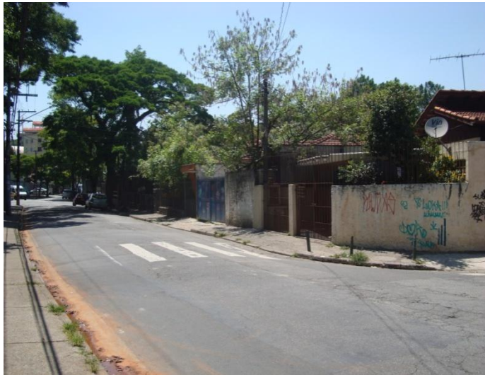
Foto 10.5.3.2-6: Imóveis na rua Prof. Pedro Pedreschi, a serem removidos.
