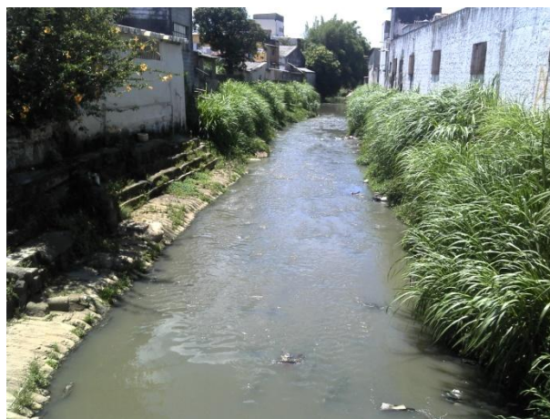
Foto 10.3.2.5-4: Vista de trecho do Córrego Tremembé onde se observa, à direita na foto, muro de propriedade na margem do curso d'água. 25/11/2014.
