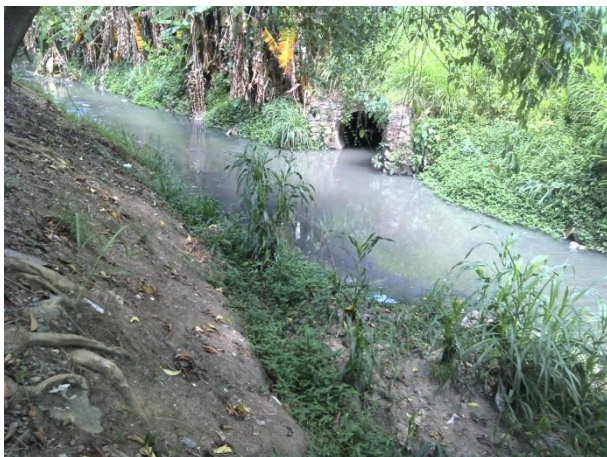
Foto 10.3.1.6-4: Tubulação de galeria com lançamento de efluente no canal, e assoreamento da margem oposta. exemplificando a insuficiência das estruturas de drenagem. 25/11/2014.
