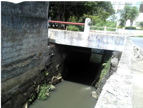
Foto 10.3.2.5-1: Vista de trecho do Córrego Tremembé, onde se observam as duas margens revestidas de concreto e passagem para a sua transposição. 25/11/2014.
