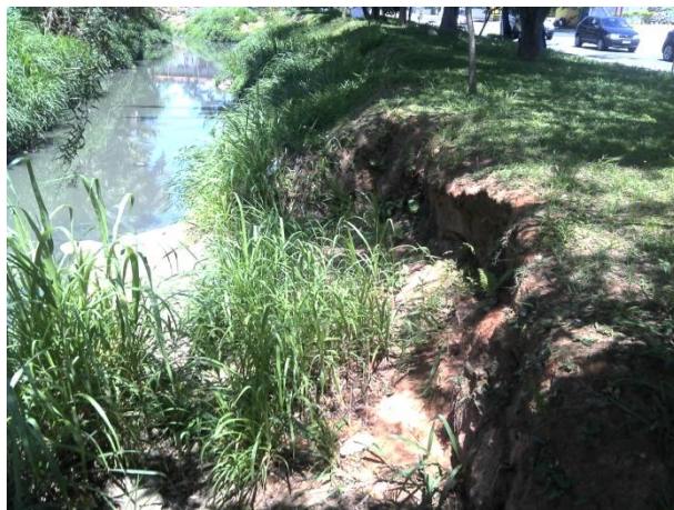
Foto 10.3.2.7-8: Córrego Tremembé: observar o desbarrancamento da margem, à direita na foto. 25/11/2014.
