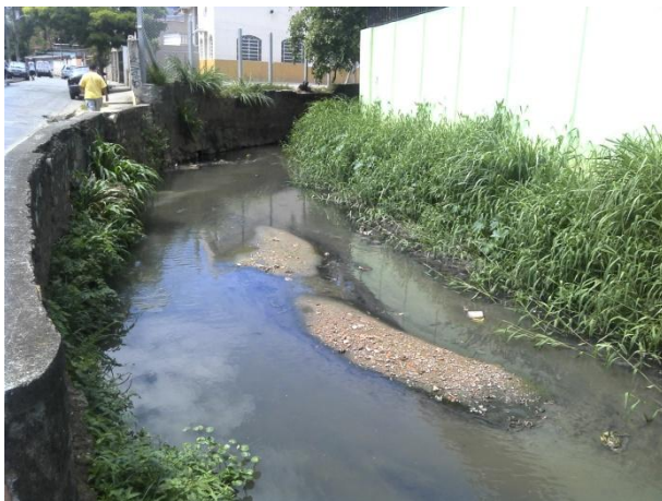
Foto 10.3.2.7-7: Córrego da Cantareira: observar a ausência de APP, a proximidade das edificações ao canal e a ocorrência de assoreamento. 25/11/2014.
