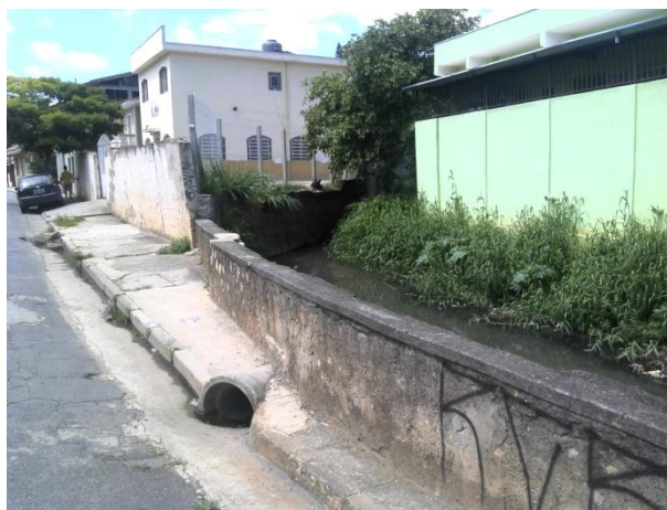
Foto 10.3.2.5-8: Vista de trecho do Córrego da Cantareira onde se observa, à direita na foto, muro de propriedade e, à esquerda, muro de limite da rua. 25/11/2014.
