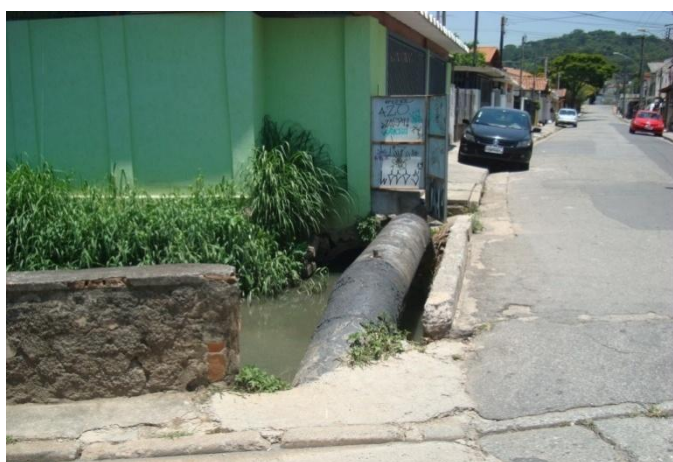
Foto 10.5.3.3-2: Adutora de água no encontro das ruas Jateí e Francisco Inglês, no trecho A.
