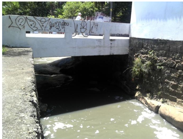
Foto 10.3.2.5-10: Vista de trecho do Córrego Tremembé onde se observa ponte de pequena altura. 25/11/2014.
