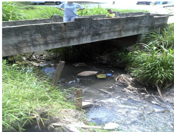
Foto 10.3.1.8-2: Turbidez da água decorrente de entulhos e efluentes no corpo d'água. 25/11/2014.
