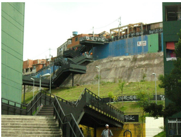
Foto 53. Escadas com contenção de encostas na Rua Três Arapongas
