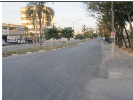
Foto 53. Av K Shimomoto (visada na direção da Av. Jaguaré próximo à R. Bolonha) Fonte: Arquitetur
