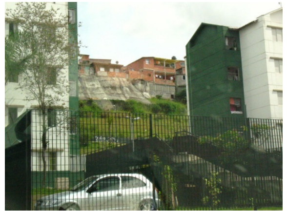
Foto 44. Contensão de Encostas
