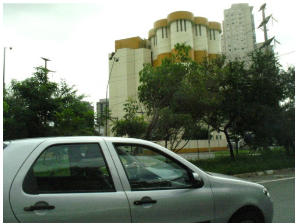
Foto 29. Indústria transformada em habitação, localizada na Avenida Escola Politécnica
