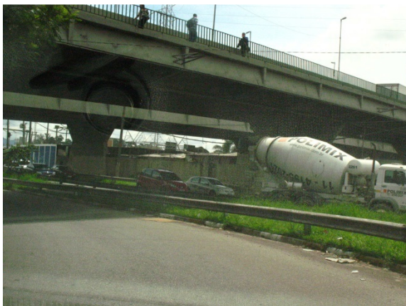
Foto 65. Ponte da Avenida Jaguare
