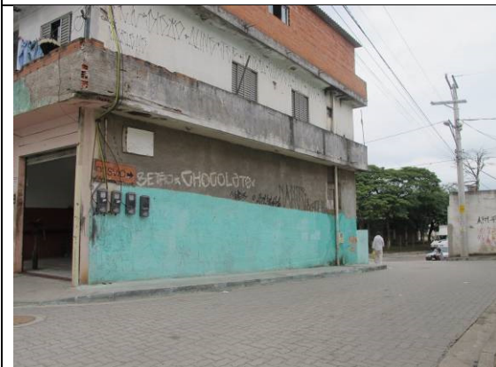
Foto 71. Acesso da Av. José Maria da Silva p/ Av. Torres de Oliveira - Fonte:Arquitetur
