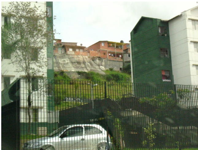
Foto 89. Contenção de encosta e Bairro Legal da CDHU na Favela Nova Jaguaré. - Fonte:Arquitetur
