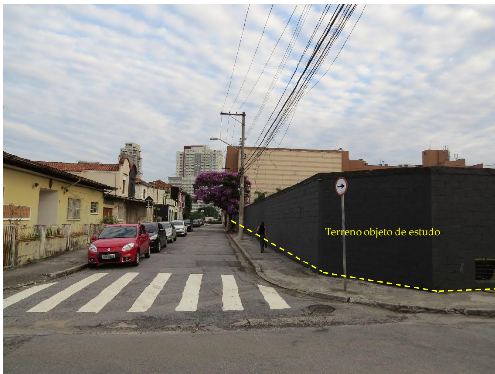
Figura 15. Vista geral da Rua Vista Alegre, que circunda o terreno.
