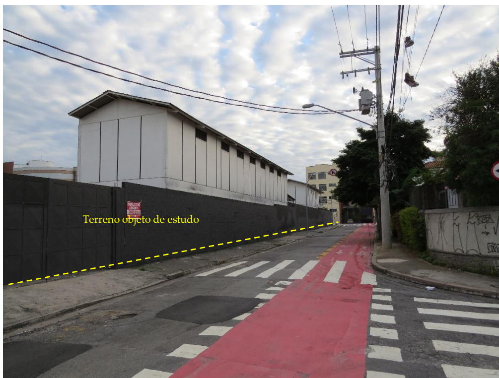
Figura 16. Arborização urbana escassa na Rua Monte Santiago.
