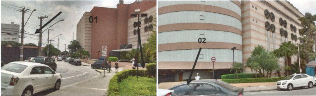
FOTO Nº 08 (a,b): Vista parcial externa da área, mostrando também parcialmente o shopping existente no local, próximo a área em estudo.
