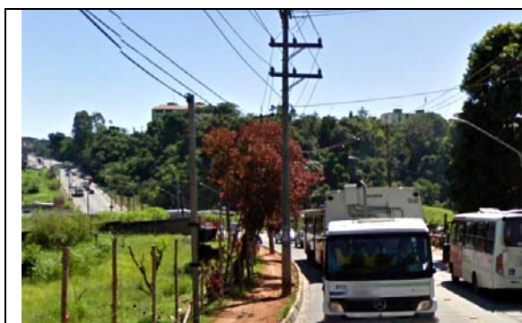
Início do trecho na Estrada do Iguatemi que será alargada com usos rurais no entorno
