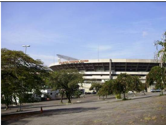
Foto 6.4.10.3-62: Fachada frontal do Estádio Cícero Pompeu de Toledo (Morumbi).
