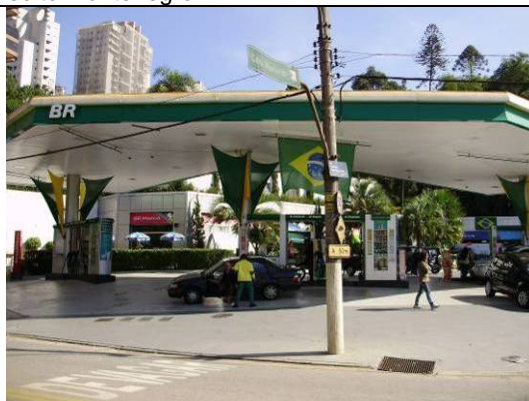
Foto 6.4.10.3-26: Posto de combustíveis localizado na mesma esquina.
