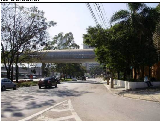
Foto 6.4.10.3-11: Estação Morumbi da CPTM, junto à Marginal do Rio Pinheiros.
