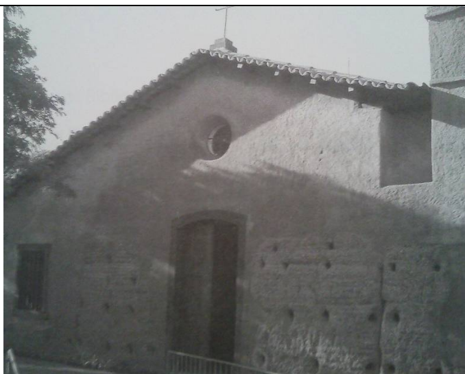
Figura 6.4.10.2-1: Vista externa da Capela do Morumbi. 2002. Foto de Márcia Alvez. NA/DIM/DPH/SMC. (Fonte: COSTA FARIA et alli . p. 98).
