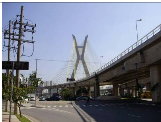
Foto 6.4.10.3-10: Vista para a ponte estaiada a partir da área prevista para implantação da parada Chucri Zaidan.
