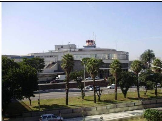
Foto 6.4.10.3-41: Canteiro central de frente ao Aeroporto de Congonhas.
