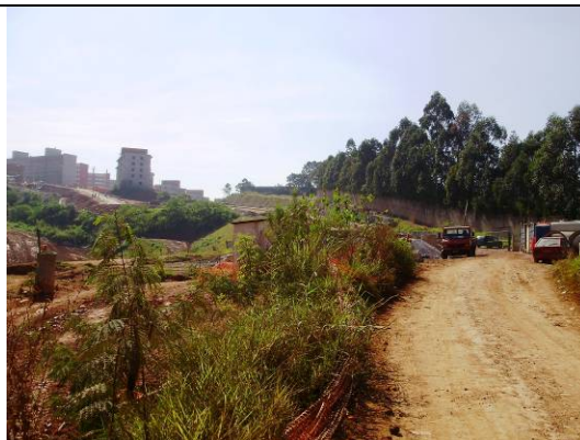
Foto 6.4.10.3-28: Área de implantação da Via Perimetral Sul.
