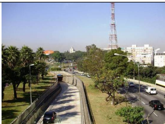
Foto 6.4.10.3-1: Vista da avenida Washington Luís a partir da passarela de frente ao aeroporto de Congonhas.
