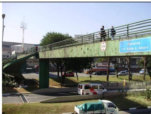
Foto 6.4.10.3-59: Passarela sobre a avenida Washington Luís, Comandante Rolim A. Amaro.
