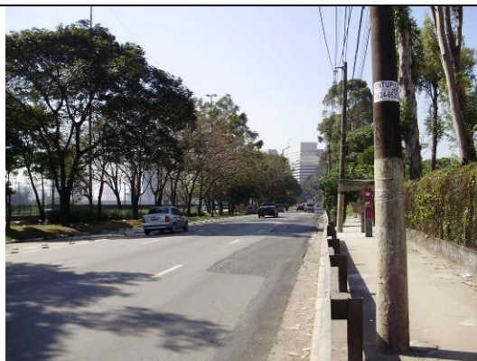
Foto 6.4.10.3-48: Vista da Marginal no intervalo compreendido entre a Estação Morumbi, da CPTM e a Estação Granja Julieta.
