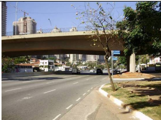
Foto 6.4.10.3-5: Viaduto da avenida Vereador José Diniz.
