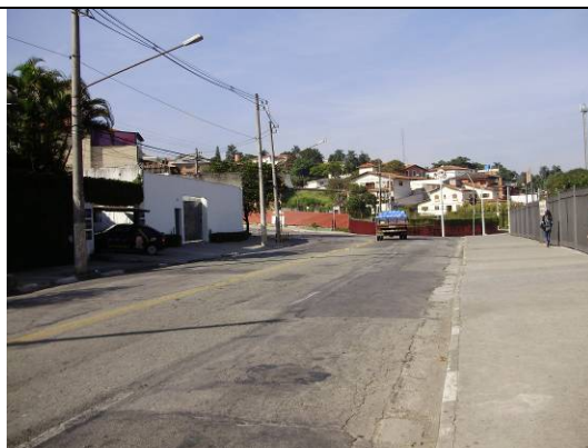
Foto 6.4.10.3-34: Avenida Jules Rimet, ao lado do estádio, vista em direção à sede social do clube.
