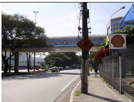
Foto 6.4.10.3-12: Estação Granja Julieta da CPTM, também à Marginal do Rio Pinheiros.
