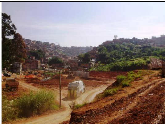
Foto 6.4.10.3-27: Obras de reurbanização na área da favela Paraisópolis.
