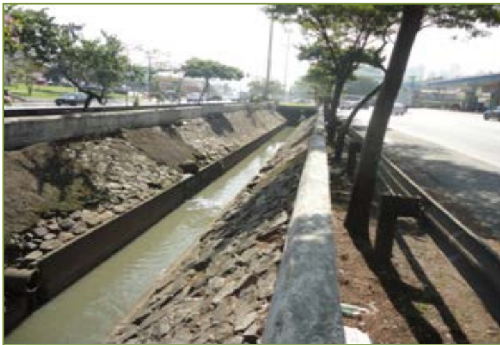
Canal do córrego Ipiranga com a planície de inundação totalmente alterada pela urbanização.
