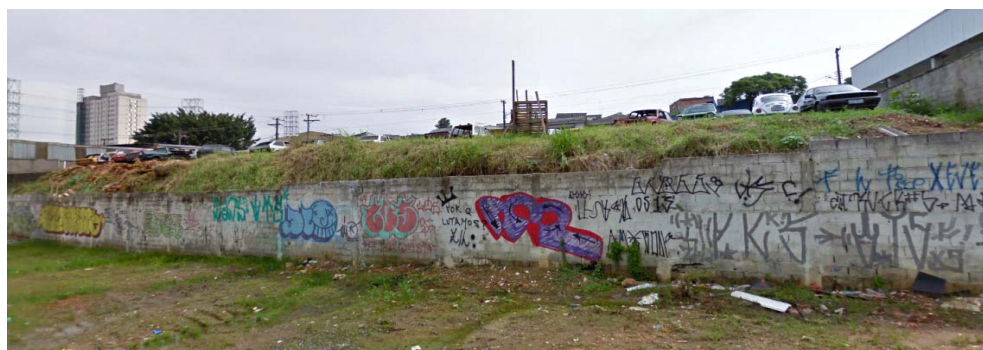
Área 3 / Norte: terreno e estacionamento visto pelos fundos, na Av. Prof. Luiz Ignácio de Anhaia Mello
