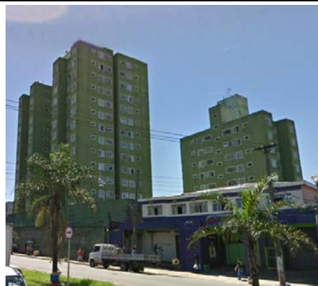
Condomínio de edifícios com frente para Av. Anhaia Mello, próximo da Rua Emilio Jafet Filho. Distância do eixo da via: 45m.
