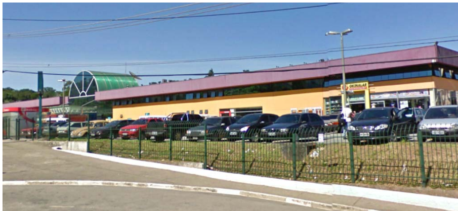
Área 25 / Oeste: Estrada do Iguatemi
