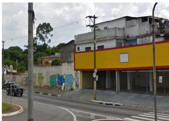
Área 4 / Sul: imóvel comercial e terreno Av. Prof. Luiz Ignácio de Anhaia Mello
