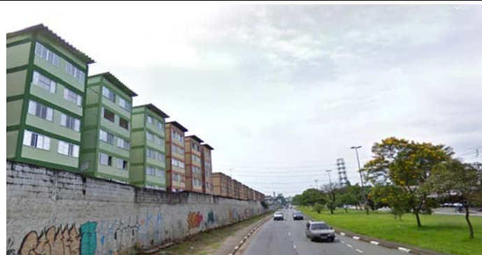
Condomínios de edifícios com frente para Av. Vila Ema e fundos para Av. Anhaia Mello, entre as ruas Sebastião Mena e Dr. Camilo Haddad. Distância do eixo da via: 30m.
