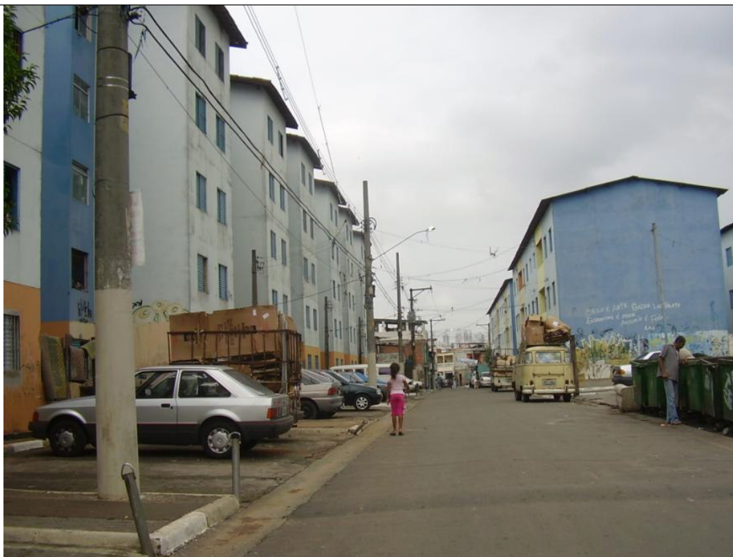
Figura 5.3.16.3 -40: Vista de habitações de baixa renda, Cingapura e favela ao fundo.
