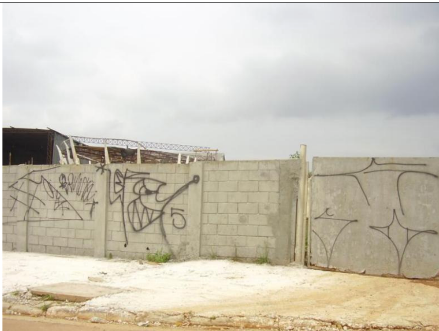
Figura 5.3.16.3 -44: Vista de muro da avenida Marginal Tietê com área sem edificações.
