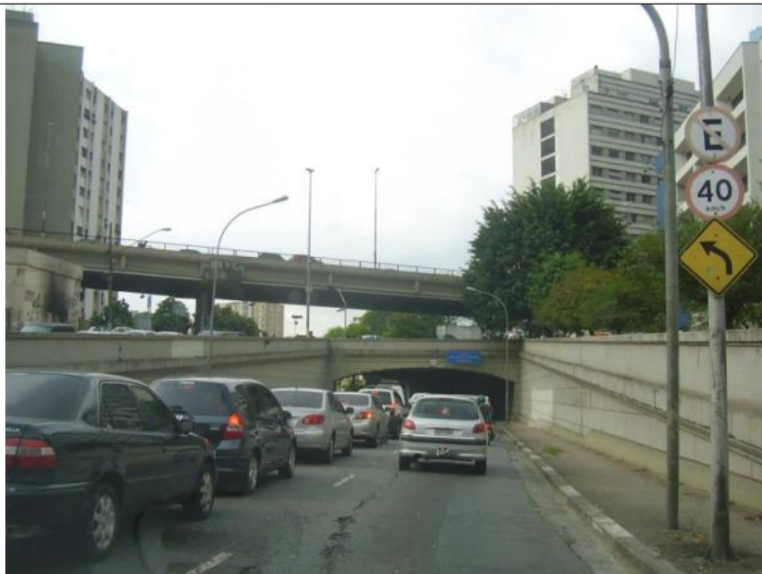
Figura 5.3.16.3 -38: Vista do Viaduto General Olímpio da Silveira
