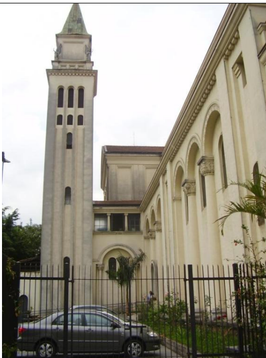
Figura 5.3.16.3 -35: Vista da lateral da Paróquia com torre que a abriga o sino da Independência.
