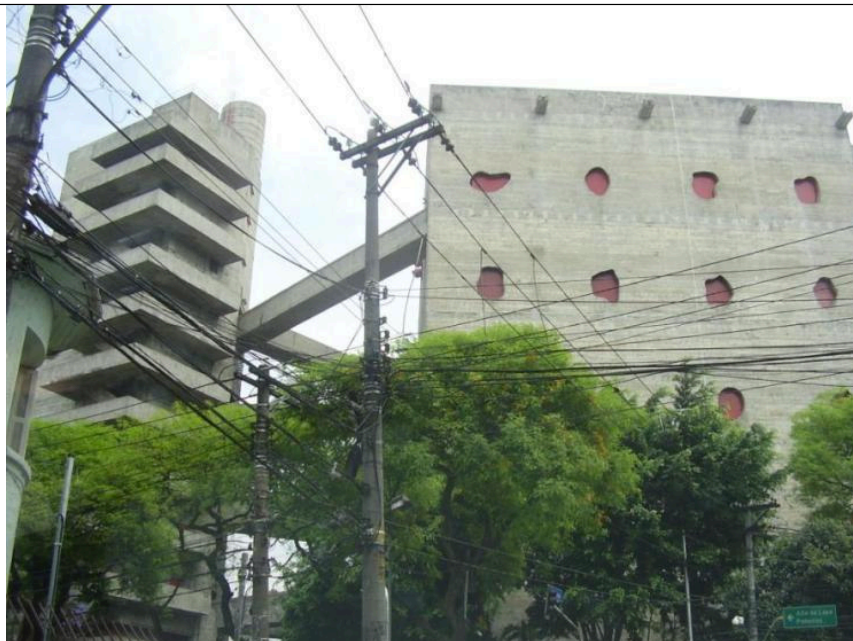
Figura 5.3.16.3 -16: Vista do prédio do SESC a partir da rua Turiassu.
