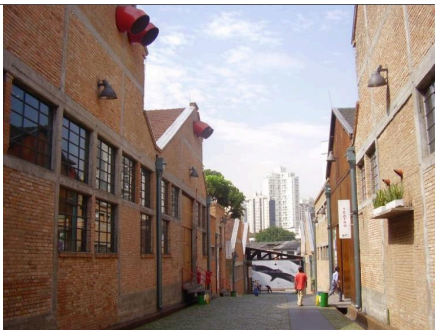
Figura 5.3.16.3 -14: Detalhe dos Galpões industriais do SESC.
