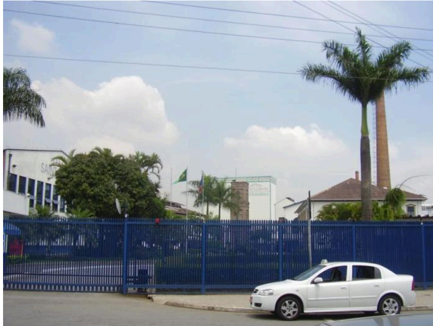
Figura 5.3.16.3 -4: Vista do portão principal da Vidraria com Chaminé do Forno, Torre e Edifício.
