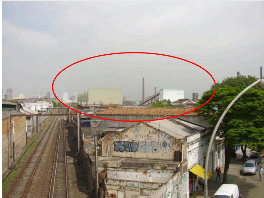
Figura 5.3.16.3 -2: Vista da Vidraria Santa Marina a partir de uma passarela da Linha Ferroviária.
