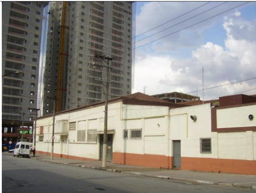
Figura 5.3.16.3 -29: Vista da Lateral da Antiga Serraria Americana.
