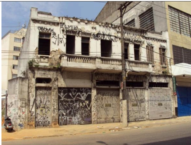
Figura 5.3.16.3 -11: Vista frontal dos imóveis da rua Carlos Vicari, 205-211.
