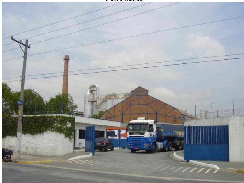
Figura 5.3.16.3 -3: Vista da portaria da Vidraria com Chaminé do Forno e edifício.
