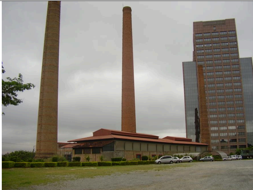
Figura 5.3.16.3 -17: Vista da “Casa das Caldeiras”.
