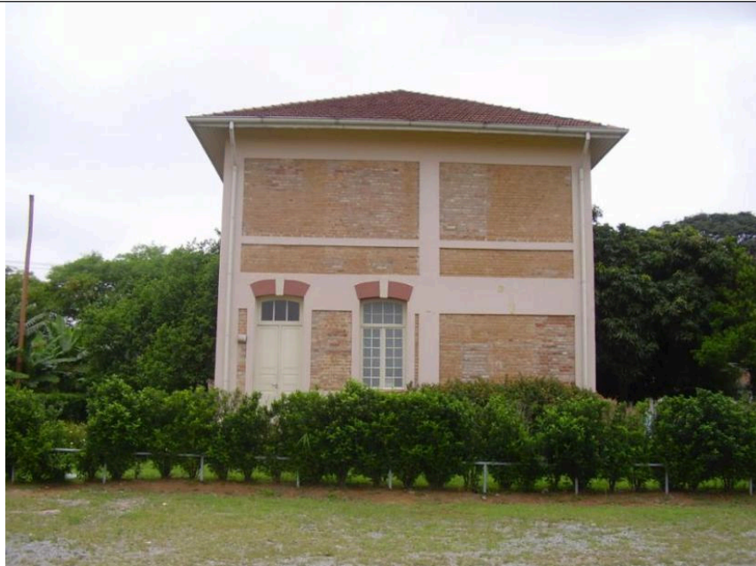
Figura 5.3.16.3 -21: Casa do Eletricista, parte da "Casa das Caldeiras"
