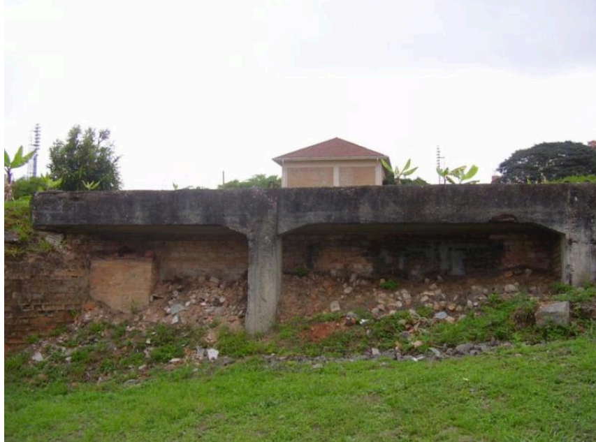
Figura 5.3.16.3 -20: Vista do entorno da Casa das Caldeiras com evidência de demolição das edificações das Indústrias Matarazzo.
