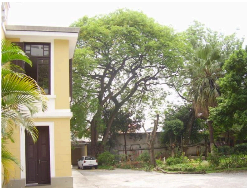
Figura 5.3.16.3 -6: Vista de jardim nos fundos do Edifício.
