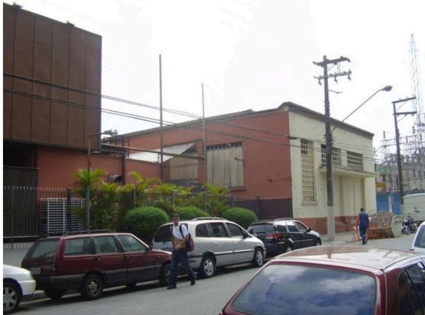
Figura 5.3.16.3 -28: Vista da frente da Antiga Serraria Americana, pela rua Tagipuru.
