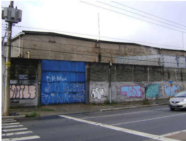
Foto 5.3.15.1-33: Bloco N – sub-bloco N2 – com galpão de armazém – Foto tirada da avenida Marquês de São Vicente.
