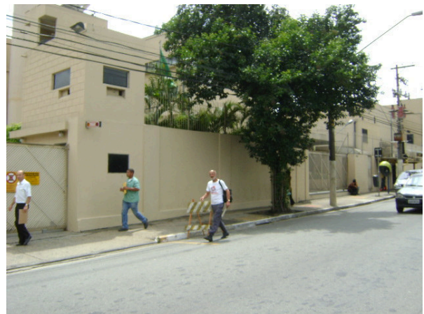
Foto 5.3.15.1-71: Bloco X - sub-bloco X2 - uso comercial - estabelecimento da emissora Record de Televisão - edificação com bom estado de conservação e Padrão Médio - rua da Várzea.
