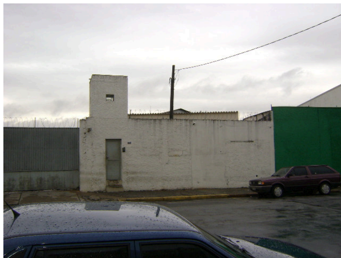
Foto 5.3.15.1-20: Bloco G – fachada da empresa transportadora – localizada na rua Capitão Francisco Teixeira Nogueira, na porção noroeste da ADA.
