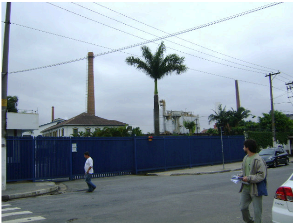
Foto 5.3.15.1-16: Bloco F – uso industrial – Fábrica Saint Gobain – notar a chaminé e edificação de padrão colonial ao fundo da Foto – localizado na avenida Santa Marina, na porção média da faixa de desapropriação.
