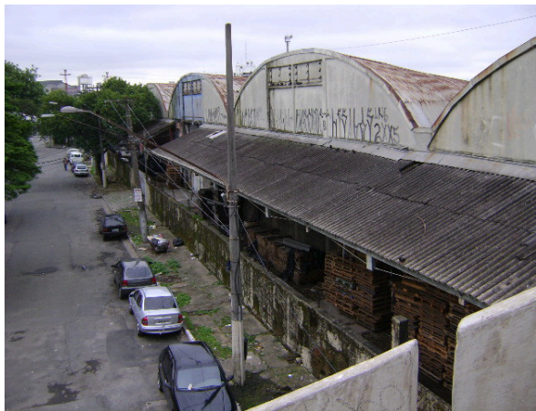
Foto 5.3.15.1-8: Bloco D - paisagem composta por Galpão de Padrão Econômico a Simples – a avenida Santa Marina aparece na esquerda da Foto.
