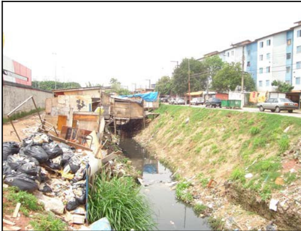
Foto 5.3.14.1-1: Saneamento Básico em condições precárias – Favela do Sapo – localizado na margem do córrego da Água Branca.
