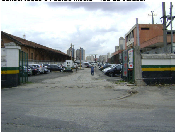
Foto 5.3.15.1-74: Bloco Y – sub-bloco Y2 – uso comercial – estacionamento de veículos – rua da Várzea (ao lado da linha férrea).
