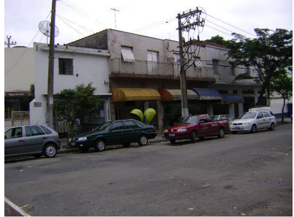
Foto 5.3.15.1-15: Bloco F – uso misto, com predomínio de pequenos comércios com Padrão Econômico a Simples – localizado na avenida Santa Marina, próximo da estação de trem Água Branca (CPTM).
