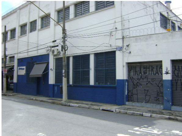
Foto 5.3.15.1-66: Bloco X - sub-bloco X1 - uso comercial - detalhe na Foto para o estabelecimento da empresa Miltilaser - edifício com bom estado de conservação e Padrão Econômico a Simples - rua Joaquim de Manuel Macedo.
