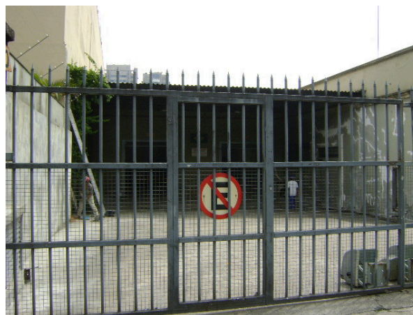
Foto 5.3.15.1-73: Bloco X – sub-bloco X3 – uso comercial – estabelecimento de armazém - edificação com bom estado de conservação e Padrão Econômico – rua da Várzea (ao lado da TV Record).
