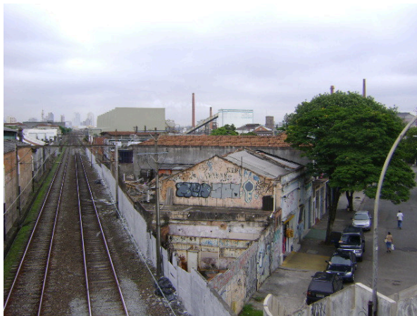
Foto 5.3.15.1-4: Vista geral do Bloco C – verificar que a linha férrea tangencia este Bloco, a direita e a avenida Santa Marina a esquerda.
