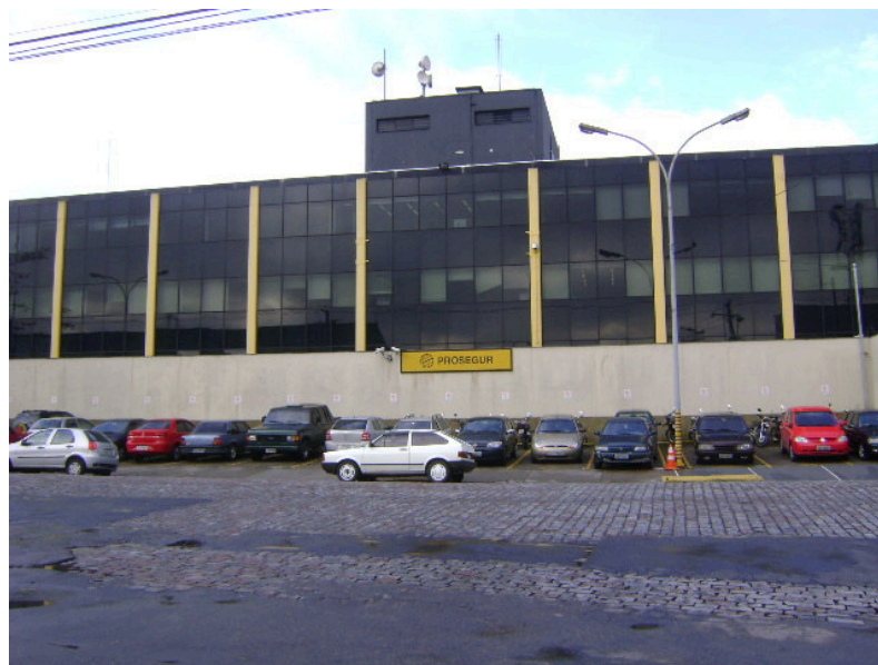
Foto 5.3.15.1-37: Bloco P – Fachada da empresa Prossegur, localizada na avenida Thomas Edson – próximo a Marginal do Tietê
