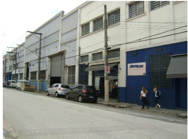
Foto 5.3.15.1-67: Bloco X - sub-bloco X1 - uso comercial -edificações demédio porte com dois ou três pavimentos - edificações com bom estado de conservação e Padrão Econômico a Simples - rua Joaquim de Manuel Macedo.
