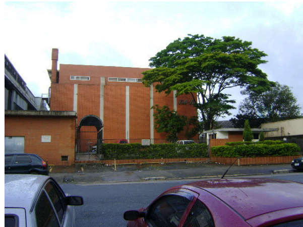
Foto 5.3.15.1-34: Bloco N – sub-bloco N3 – notar a fachada da empresa Full-Fit – Foto tirada da rua Thomas Édson.
