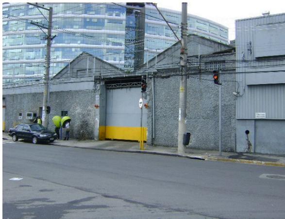
Foto 5.3.15.1-61: Bloco V – sub-bloco V1 – edificação comercial – empresa Prosegur – rua Tagipuru.
