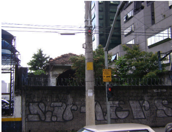
Foto 5.3.15.1-59: Bloco V – sub-bloco V1 – edificação residencial, em estágio avançado de degradação – avenida Francisco Matarazzo.
