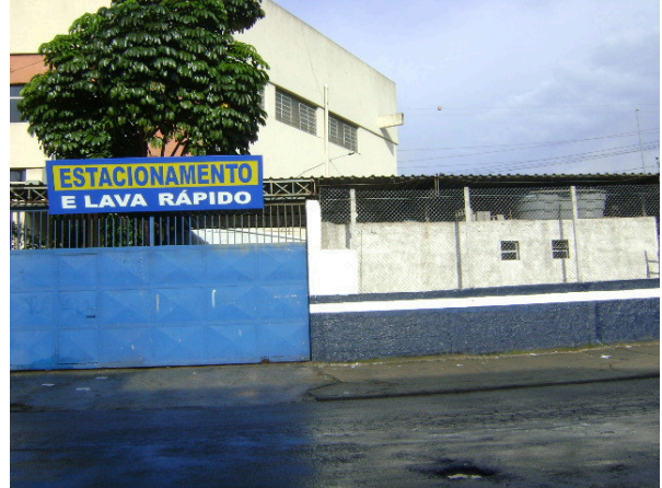
Foto 5.3.15.1-36: Bloco O – sub-bloco O2- Fachada do imóvel (estacionamento e lava rápido) – Foto tirada da rua José de Oliveira Coutinho
