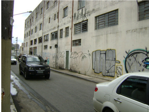
Foto 5.3.15.1-78: Bloco Y – sub-bloco Y4 – uso comercial (mecânica de veículos) com edificação de Galpão com Padrão Econômico– rua James Holland.
