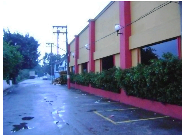
Foto 5.3.15.1-58: Bloco U – restaurante e churrascaria – avenida Marquês de São Vicente.
