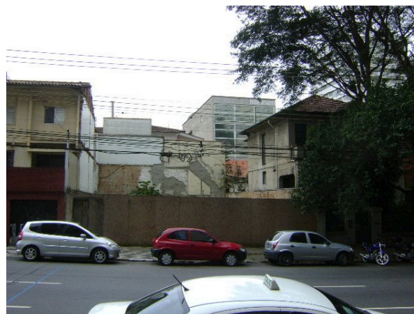
Foto 5.3.15.1-2: Bloco de desapropriação A – face da rua Turiassu – Terreno e fundo de uma residência.
