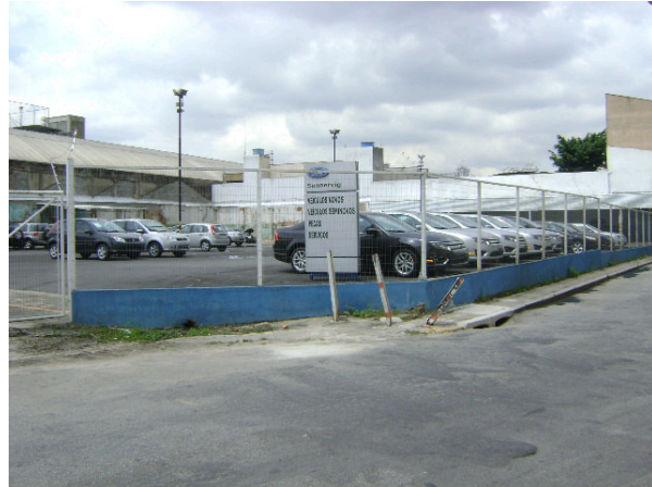
Foto 5.3.15.1-79: Bloco Y – sub-bloco Y4 – uso comercial (concessionária de veículos da Ford - Sonnervig) com edificação de Galpão com Padrão Econômico– rua James Holland.
