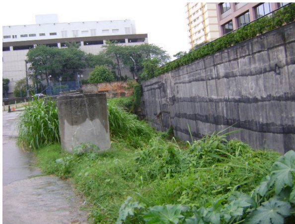
Foto 5.3.15.1-23: Bloco H – vista geral da área do sub-bloco H2 – inserido de forma perpendicular à avenida Francisco Matarazzo (ao fundo da Foto) – notar que a área encontra-se desocupada (terreno).
