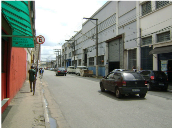
Foto 5.3.15.1-68: Bloco X - sub-bloco X1 - uso comercial - grandes edificações com dois ou três pavimentos - edificações com bom estado de conservação e Padrão Econômico a Simples - rua Joaquim de Manuel Macedo.
