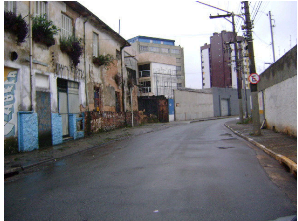
Foto 5.3.15.1-48: Bloco T – sub-bloco T1 - área de uso misto com predomínio de residência de Padrão Econômico com estado degradado de conservação – localizada na rua do Bosque.
