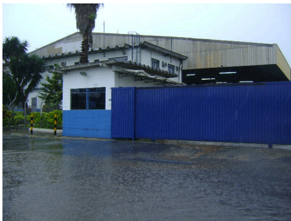
Foto 5.3.15.1-27: Bloco J – Fachada da empresa Tecmar – localizada próxima da Marginal do Tietê e Ponte Júlio Mesquita Neto.
