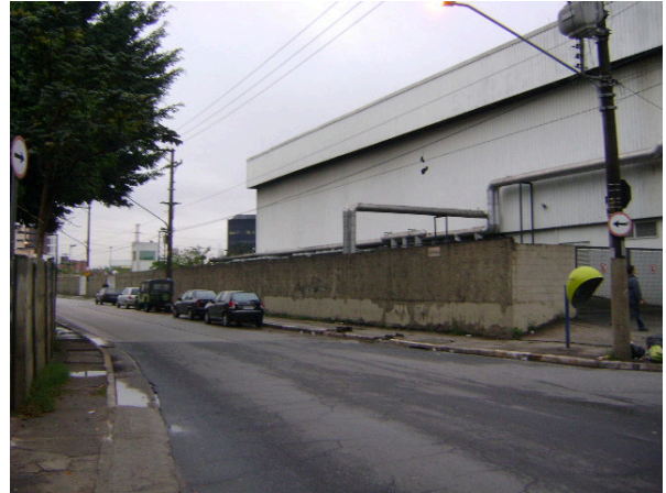
Foto 5.3.15.1-46: Bloco S - área ocupada pela empresa Contax – localizada na rua Bento Teobaldo Ferraz
