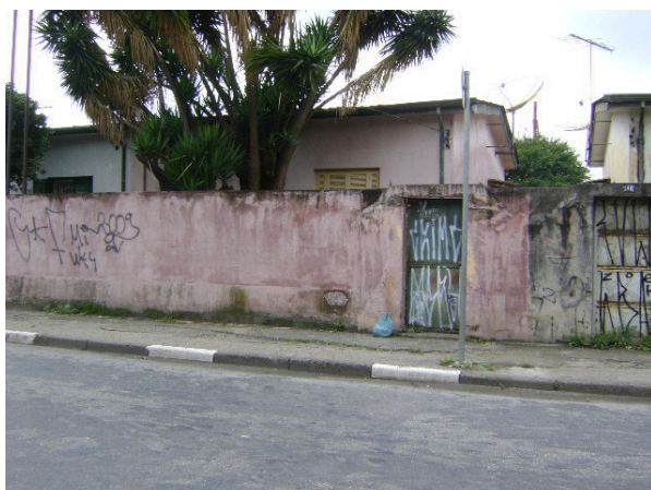
Foto 5.3.15.1-76: Bloco Y – sub-bloco Y3 – uso residencial horizontal com Padrão Econômico– rua Capitão Mor Gonçalo Monteiro.
