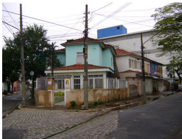
Foto 5.3.15.1-40: Bloco R – sub-bloco R2 – área de uso residencial horizontal – localizado no entroncamento da rua do Bosque com a rua João Jair Banks
