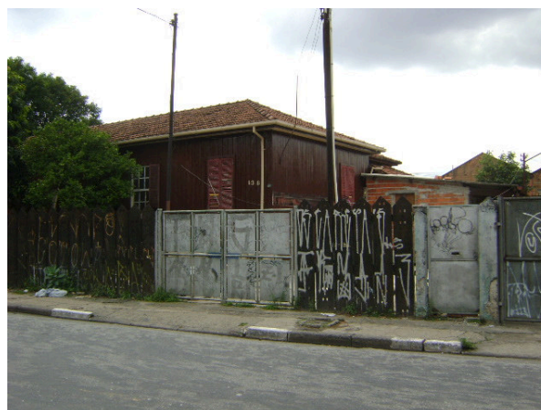
Foto 5.3.15.1-77: Bloco Y – sub-bloco Y3 – uso residencial horizontal com Padrão Econômico em estado de deterioração – rua Capitão Mor Gonçalo Monteiro.
