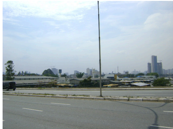
Foto 5.3.15.1-26: Bloco I – vista geral da área do sub-bloco i2 – localizado na margem do viaduto Pompéia – área com diversas edificações.
