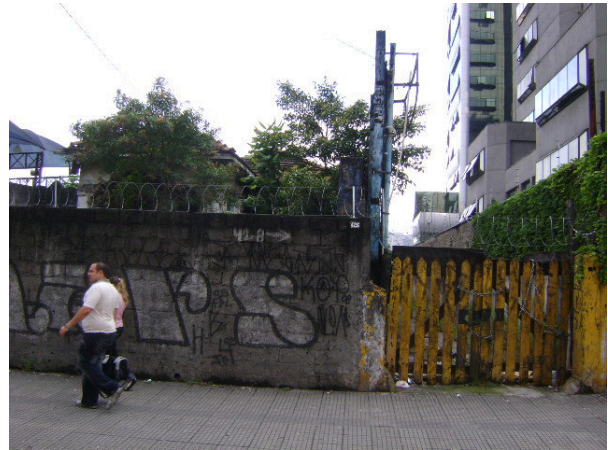
Foto 5.3.15.1-60: Bloco V – sub-bloco V1 – edificação residencial, em estágio avançado de degradação – avenida Francisco Matarazzo.
