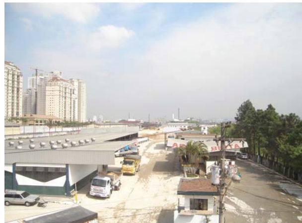
Foto 5.3.15.1-13: Bloco E – Empresa Pedrasil – local de depósito.
