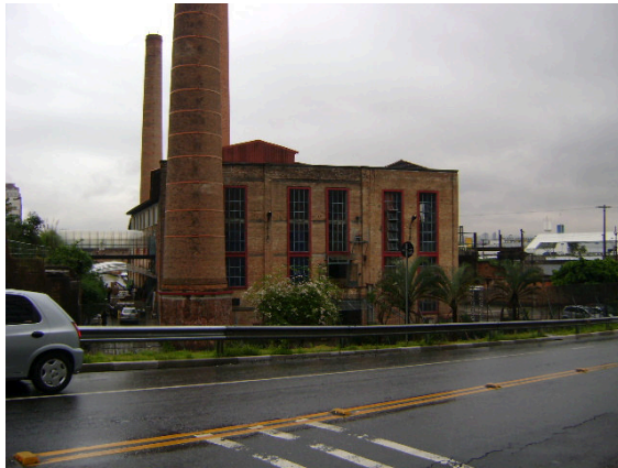
FOTO 5.3.12.5-5: Casa das Caldeiras.
