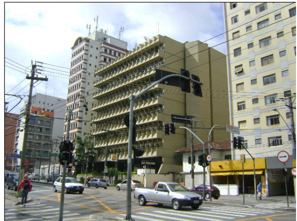
FOTO 5.3.12.5-20: SENAC, avenida Marques de São Vicente.
