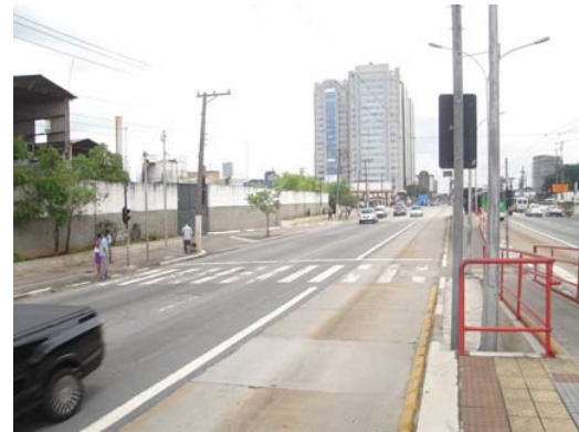
Foto 5.3.14.1-2: viário estrutural com corredor central para transporte público
