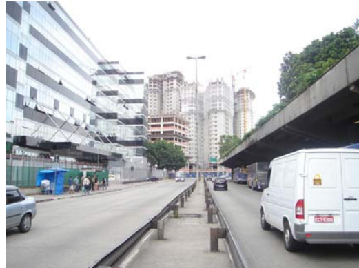
Foto 5.3.13.1-6: avenida Auro Soares, próximo ao Terminal Intermodal.
