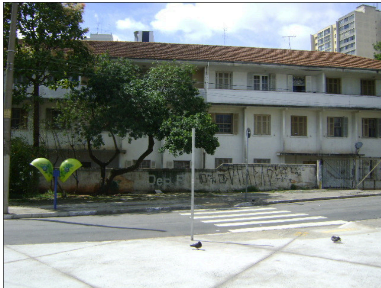
Foto 5.3.8.3-7: Área com domicílio do tipo cômodo – localizado no entroncamento da rua Tagipuru com a rua Fuad Naufel, nas proximidades da UNINOVE – notar a fachada dos domicílios em estágio médio de degradação.
