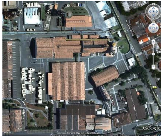
Foto 5.3.3.3-5: Imagem aérea da indústria Saint Globain, adjacente a avenida Santa Marina (Google Earth – 20/10/09)
