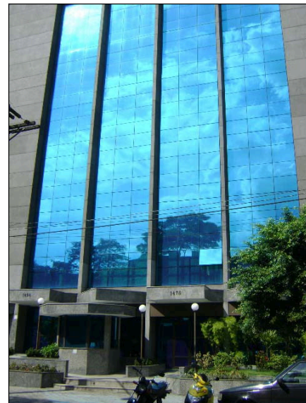
Foto 5.3.3.3-19: Edifício empresarial, localizado na Avenida Santa Marina – noroeste da ADA
