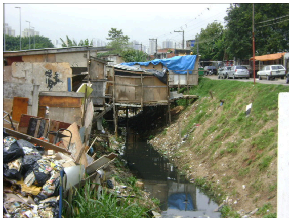
Foto 5.3.2.1-3: Favela do Sapo com barracos construídos de forma precária às margens do córrego Água Branca. (registro no dia 19/10/09)
