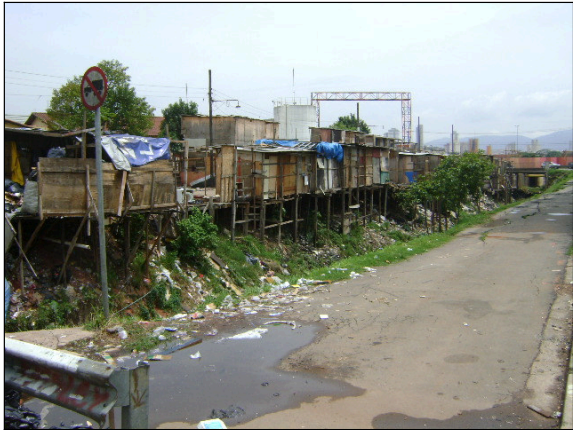
Foto 5.3.2.1-1: Favela do Sapo com barracos construídos de forma precária às margens do córrego Água Branca. (registro no dia 19/10/09)
