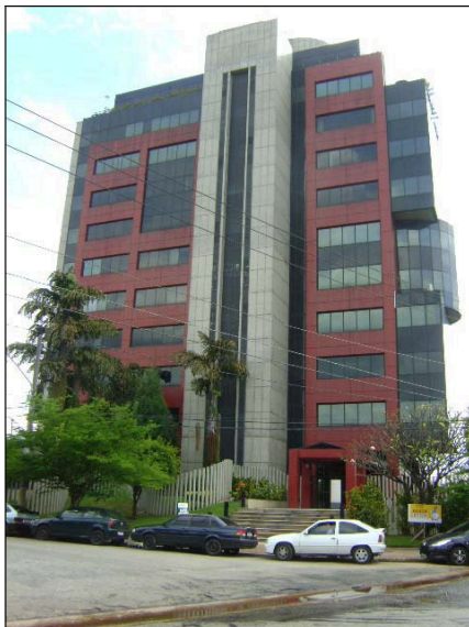
Foto 5.3.3.3-18: Edifício empresarial, localizado na Rua Vladimir Herzog – porção noroeste da ADA
