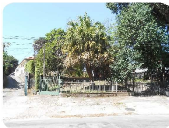
Entrada de área residencial ao lado esquerdo da via, que será diretamente afetada pelo empreendimento, ainda que parcialmente, para abertura de nova passagem sob a ferrovia.
