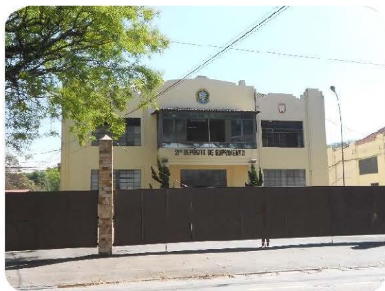
Quartel do Exército Brasileiro, que terá sua área parcialmente afetada para substituição da galeria de drenagem.
