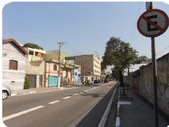
Visão Geral da R. John Harrison, com ocupações residenciais e comerciais.
