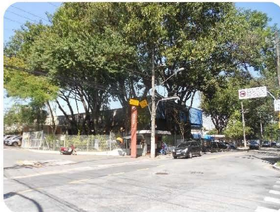
Área de uso da CPTM e da Alstom, no lado esquerdo da via (sentido Lapa), que será parcialmente afetado pelo empreendimento.
