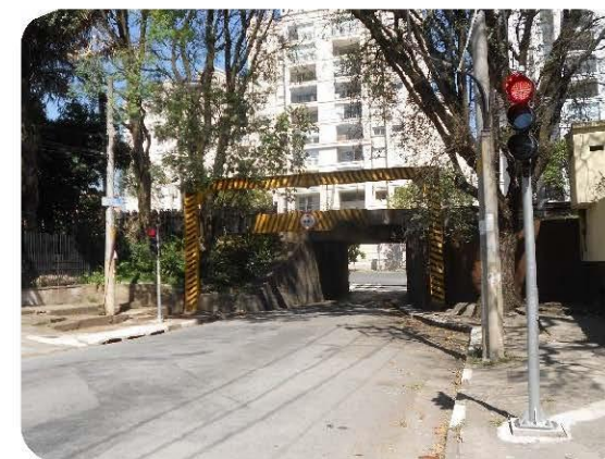
Passagem sob a ferrovia, a qual será duplicada. Vista a partir da Av. Raimundo Pereira de Magalhães.
