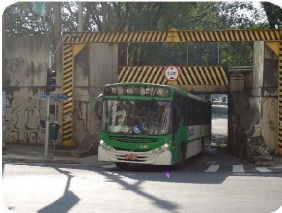
Passagem sob a ferrovia, a qual será duplicada. Vista a partir da R. Gago Coutinho.
