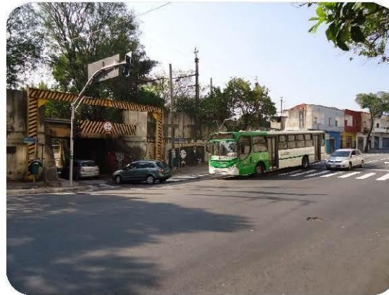
Visão geral da R. Gago Coutinho, ADA do empreendimento.
