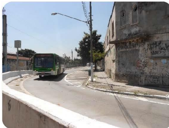
Curva acentuada da R. John Harrison com R. D. João V. O antigo galpão, à direita da foto, será parcialmente desapropriado.
