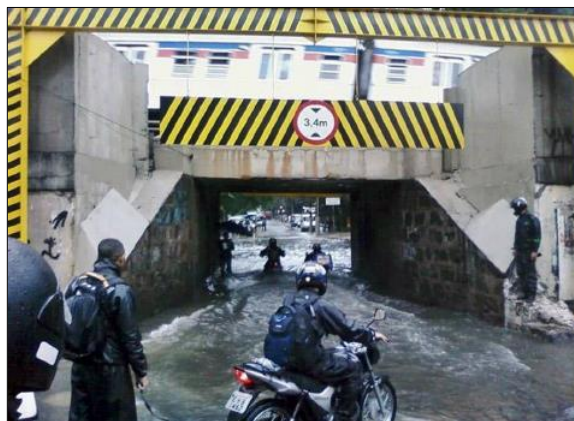
Foto 9.1.4-2 - Alagamento na passagem inferior sob a Linha 8 da CPTM
