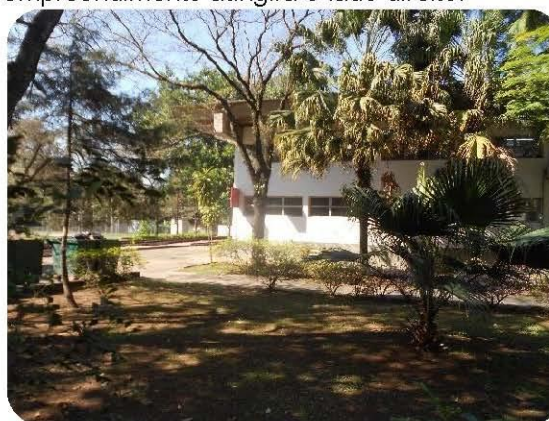
Instalações da CPTM. Local que será afetado pelas obras do empreendimento.
