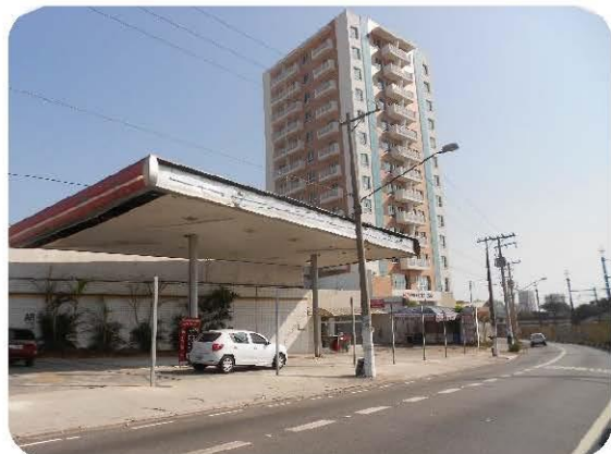
Posto de gasolina desativado e edifício comercial, os quais serão parcialmente afetados na R. John Harrison.
