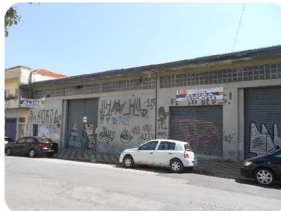
Galpões que serão desapropriados, na R. Gago Coutinho.
