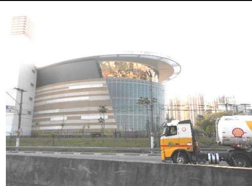
Tietê Plaza Shopping, na Marginal Tietê junto à Av. Raimundo Pereira de Magalhães, distrito de Pirituba.
