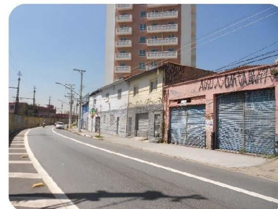
Quadra que será parcialmente afetada na R. John Harrison, para suavização do curva e abertura de corredor de ônibus.
