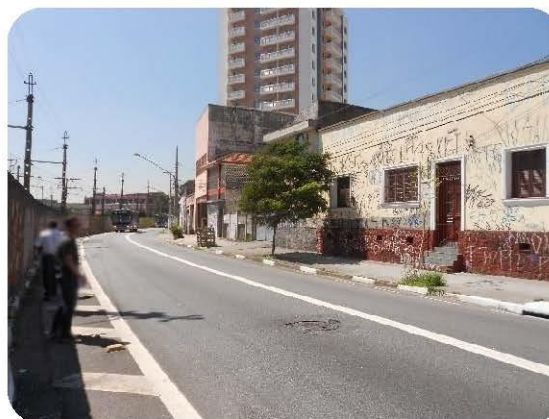
Quadra que será parcialmente afetada na R. John Harrison, para suavização do curva e abertura de corredor de ônibus.
