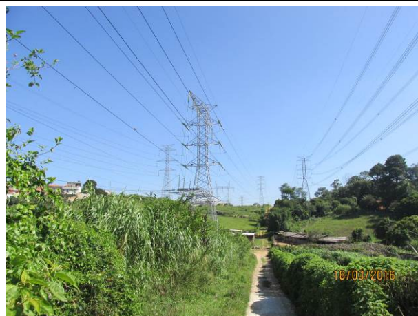
Foto 22: Vista geral do eixo da LTA Henry Borden e acesso.
