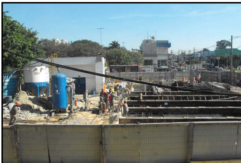
Figura 6.2.11.2-2 – Obras na área de antigo posto de serviços localizada na Av. Professor Francisco Morato 2631.
