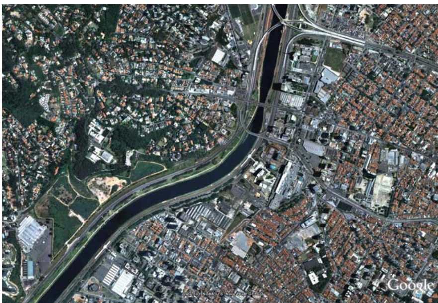
Figura 6.2.9.3-2: Rio Pinheiros no trecho onde a Linha 17 – Ouro acompanha o traçado da Av. das Nações Unidas.
