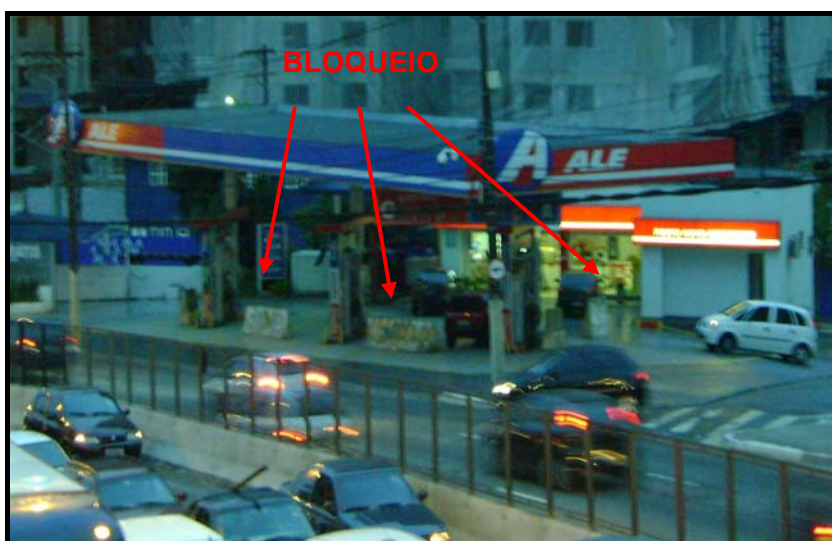
Figura 6.2.11.2-1 – Entrada do Posto de Serviços bloqueada por blocos de concreto.
