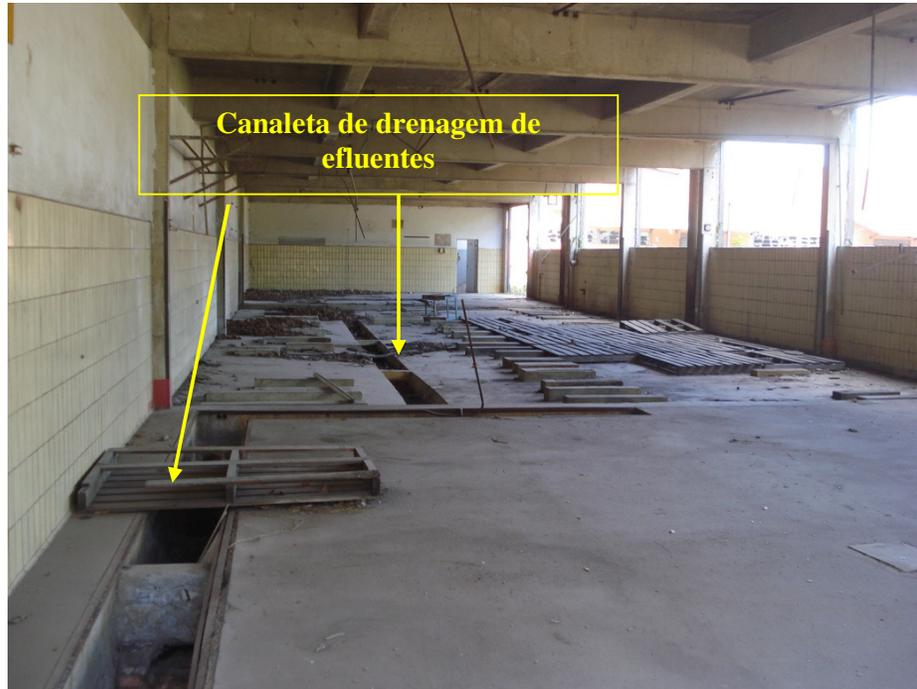
**Figura 2.3-12 – Vista interna da área, com destaque para as canaletas de drenagem dos efluentes**
