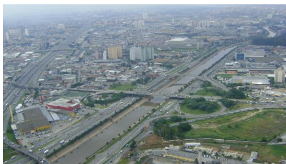
Foto nº 01: Empreendimento Adequação Viária da Marginal Tietê.
