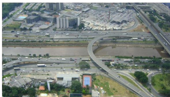
Foto nº 02: Empreendimento Adequação Viária da Marginal Tietê.
