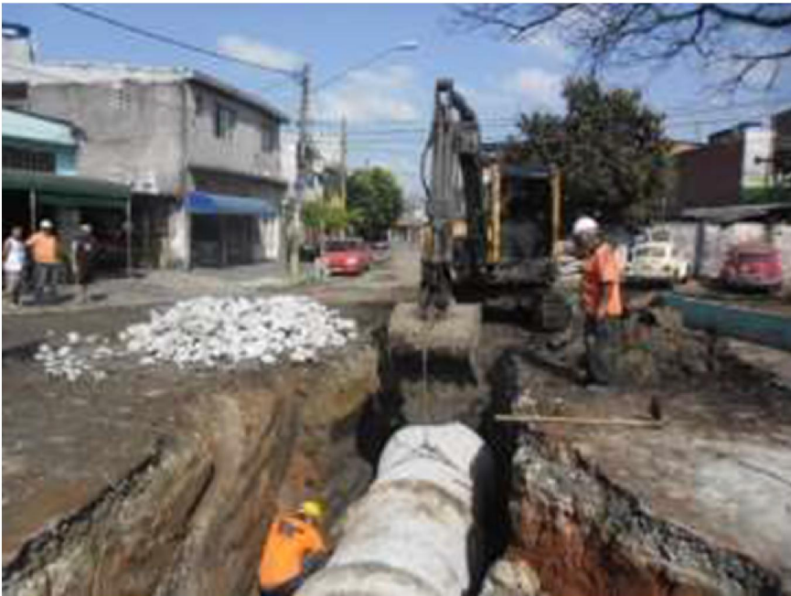
obra em andamento execução de rede de drenagem
