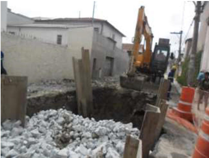
obra em andamento abertura de vala entre poços de visita
