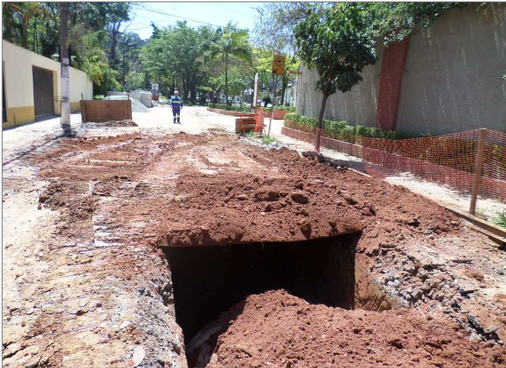
obra em andamento escavação de vala, escoramento, assentamento de tubulação e reaterro
