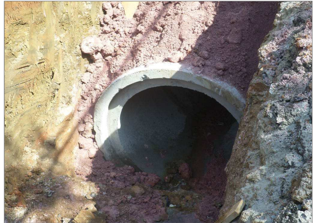
obra em andamento assentamento de tubulação
