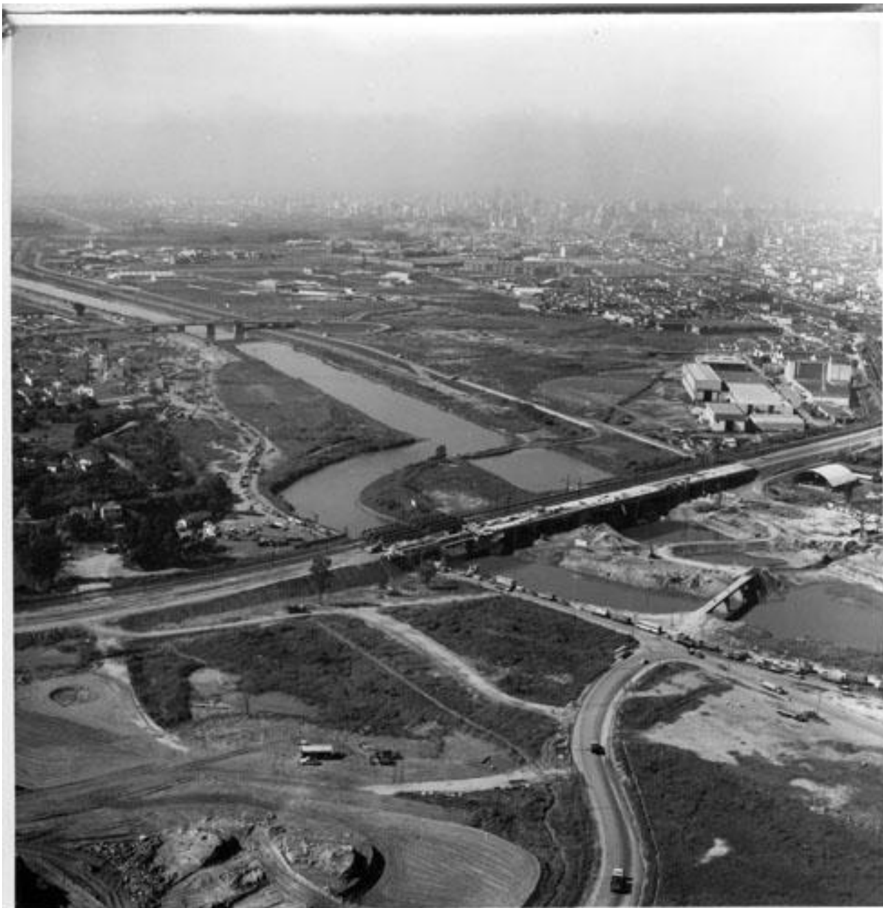
Construção de ponte ferroviária sobre o Tietê, 1968.
