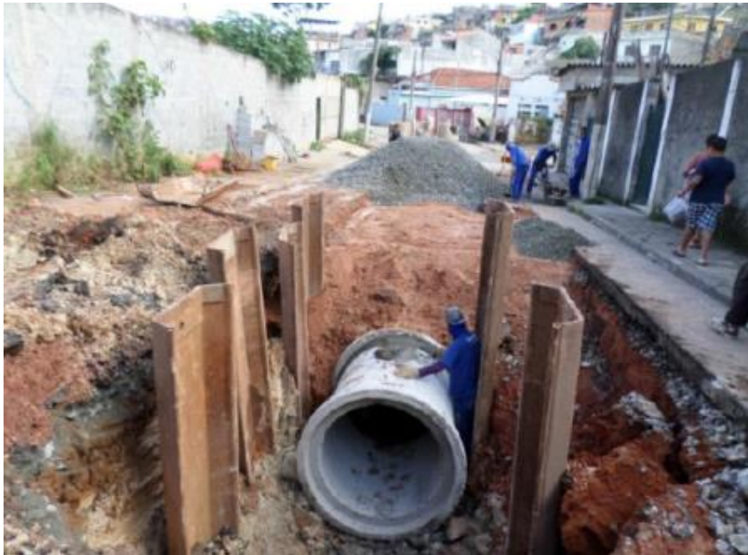
obra em execução
