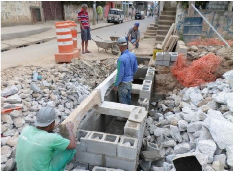
obra em execução
