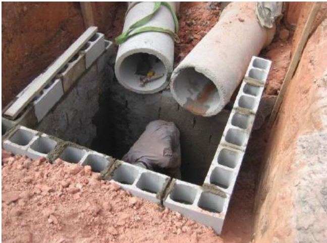
obra em execução
