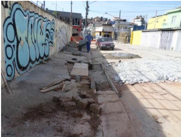
obra em execução
