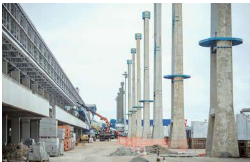
Aeroporto Internacional Afonso Pena, em Curitiba, em obras: de acordo com o governo, a intervenção não pode ser considerada inacabada, pois foi prevista para ser concluída em 39 meses
