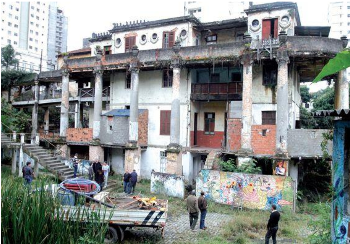
Colunas gregas do antigo teatro São José foram utilizadas na obra original da Vila Itororó, que foi construção pioneira no Brasil, na década de 1920, a ser realizada com material reaproveitado
