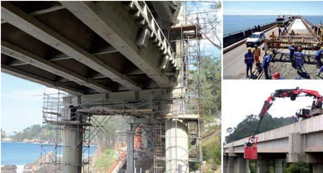
Serviços de recuperação de pontes com recomposição de estrutura, uso de fibra de carbono e aplicação de protensão externa
