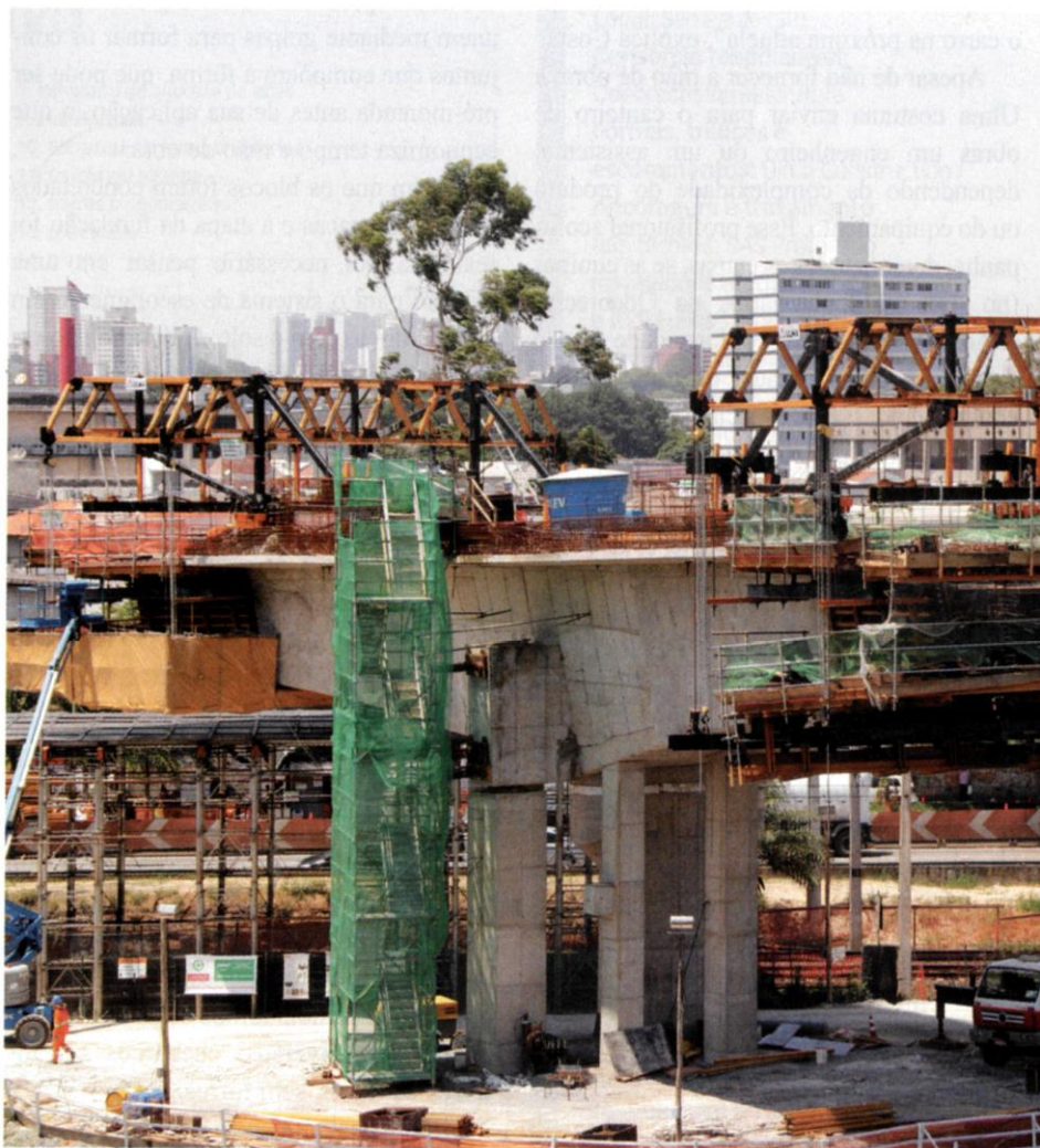
Tecnologia de balanço sucessivo durante a construção da Ponte Itapaiúna, sobre a Marginal Pinheiros. Sob a responsabilidade da Ulma Construction, o sistema permitiu o avanço das obras sem afetar o fluxo de carros nas pistas do eixo rodoviário
