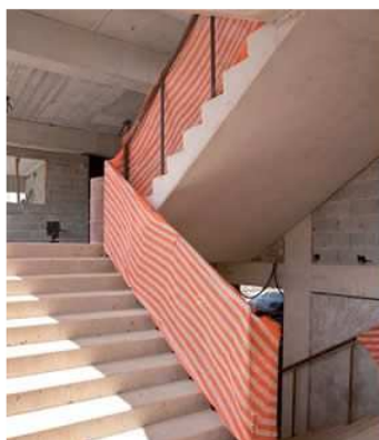
Escadas pré-fabricadas já instaladas
