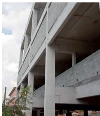
Piso com lajes assentadas sobre pilares e vigas
