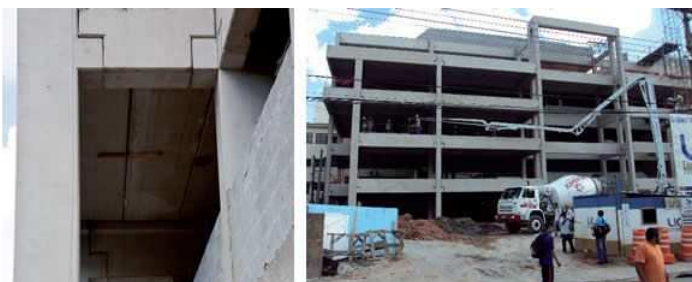
Ligações entre as peças feitas são executadas por grauteamento
