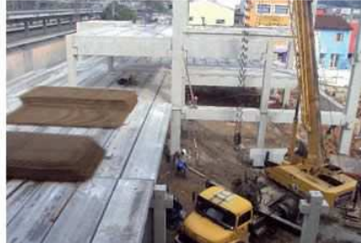
Colocação das lajes de piso alveolar L20 A9 sobre cargas utilizadas: >500 kgf/m 2 > 200 kgf
