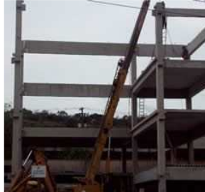
Içamento e colocação das vigas a serem assentadas sobre elastoméricos
