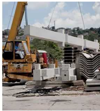
Içamento dos pilares no pátio da indústria para serem levados à obra
