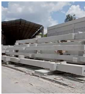
Conjunto de pilares pré-fabricados à espera de transporte
