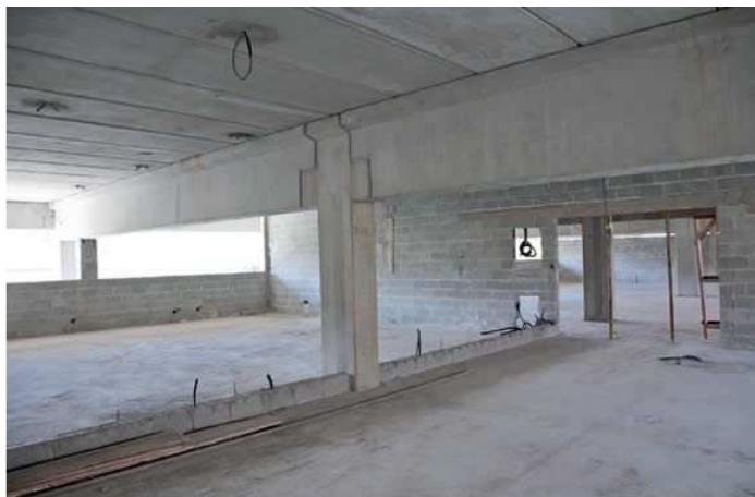
Quanto menor o conjunto de peças pré-fabricadas e a família dos componentes, maior a facilidade de fabricação, transporte e montagem em canteiro
